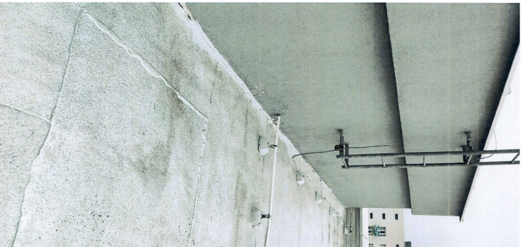
Zdj. 7. Widok dachu budynku (widok na drugi segment)
