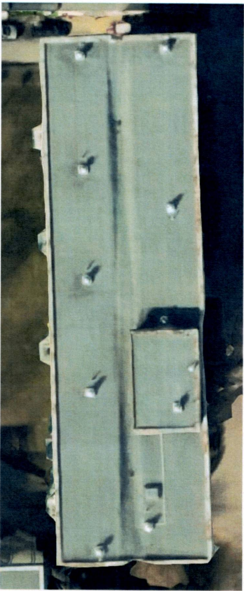
Zdj. 2 – Widok dachu budynku z góry
