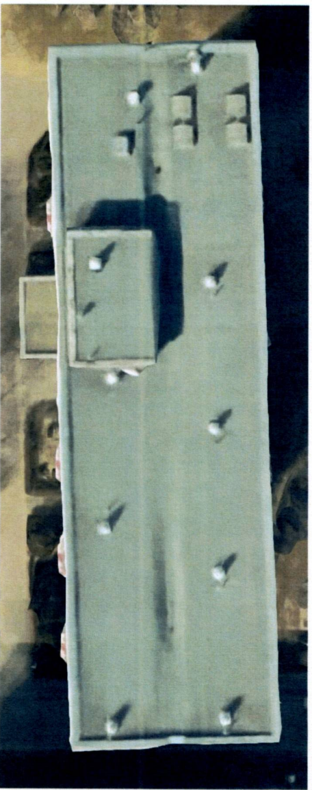
Zdj. 2 – Widok dachu budynku z góry
