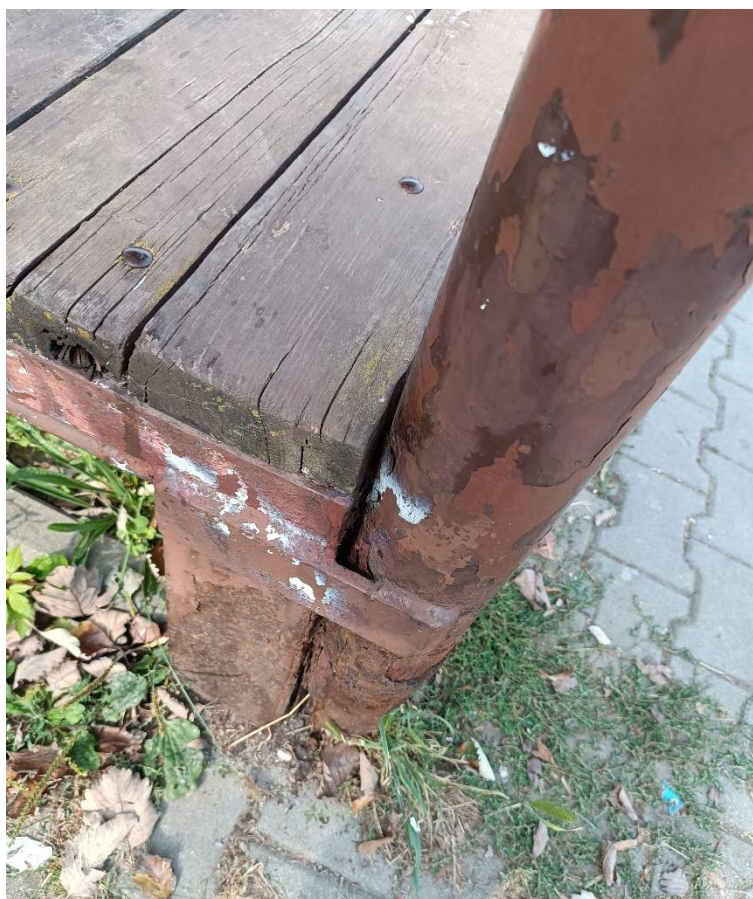
Rys. 6.4 Widoczne uszkodzenie powłok malarskich na konstrukcji podestu i słupie.
