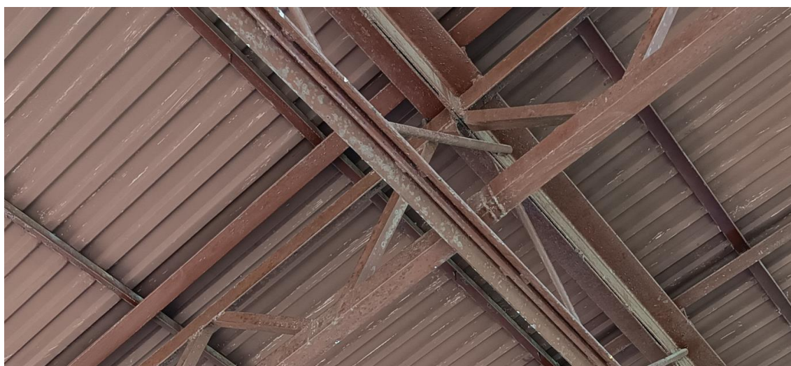
Rys. 6.7 Widoczne ubytki powłoki malarskiej na kratownicach.
