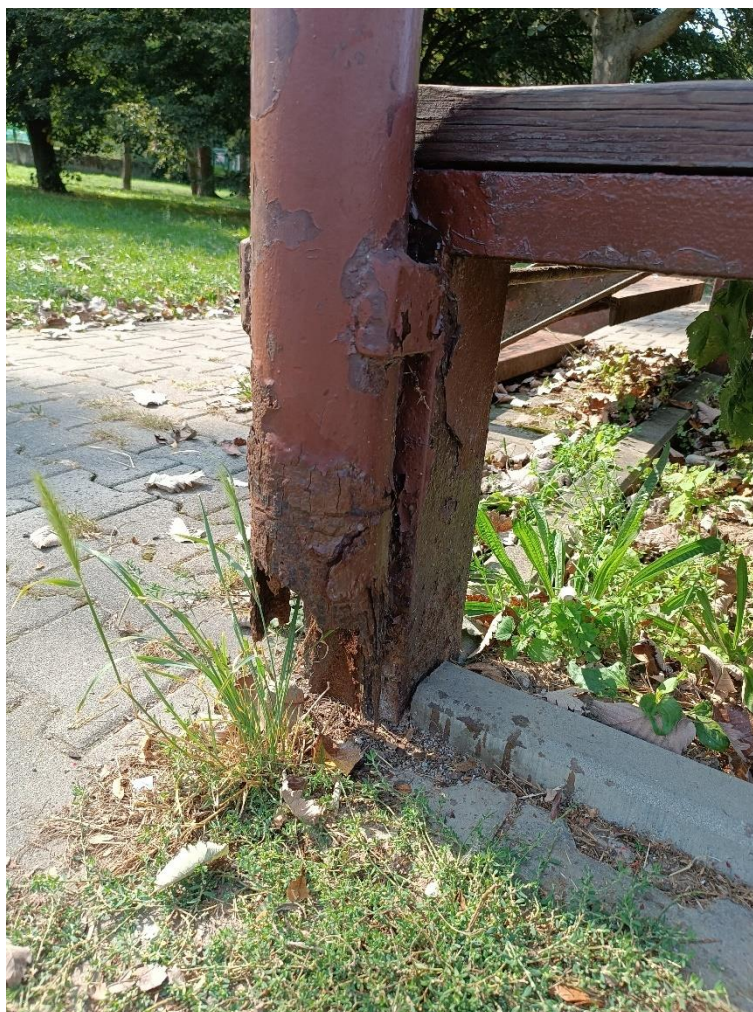
Rys. 6.6 Korozja i całkowity ubytek fragmentu słupa.
