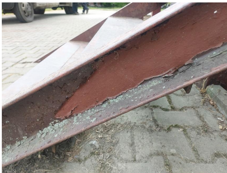
Rys. 6.3 Widoczne uszkodzenie powłok malarskich na schodach.
