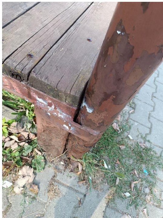
Rys. 4.6 Widok mocowania słupów zadaszenia do słupków podestu – słup narożny.
