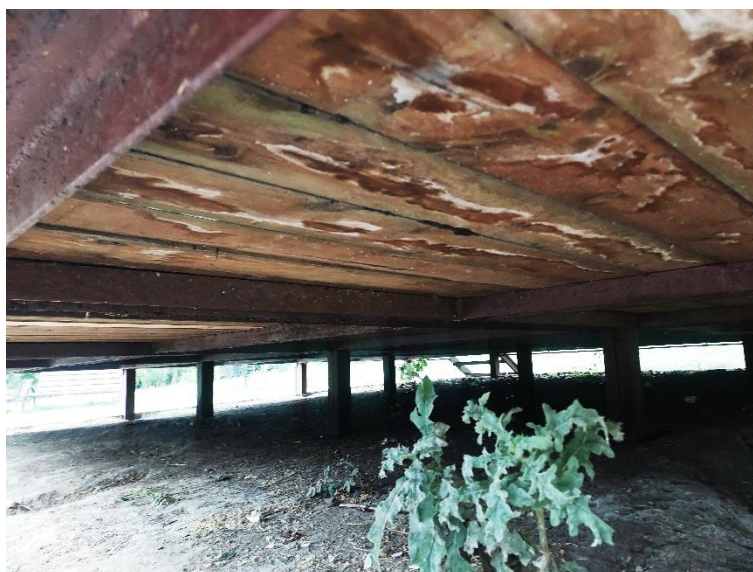
Rys. 6.1 Widoczne zawilgocenie desek podestu.
