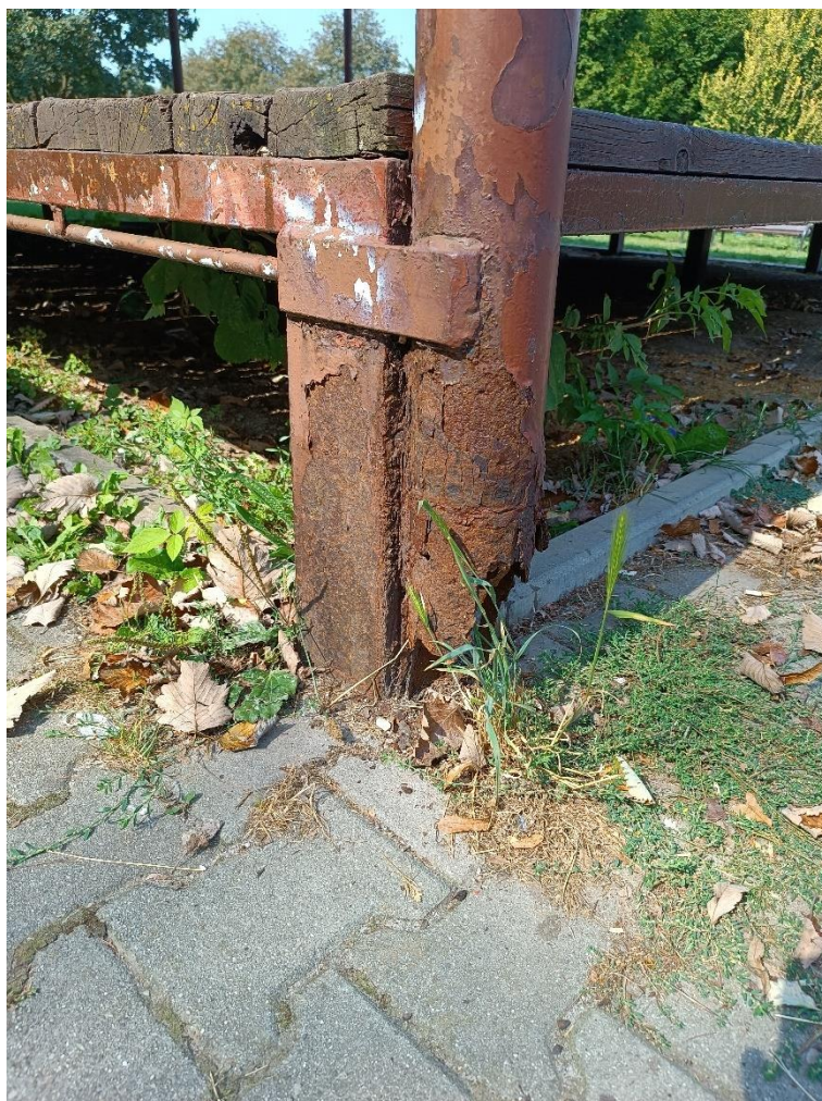
Rys. 6.5 Korozja i całkowity ubytek fragmentu słupa.
