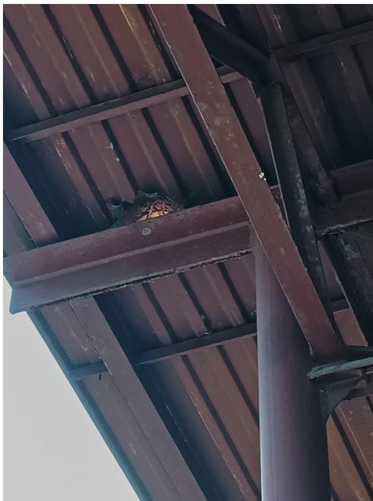
Rys. 6.8 Ubytek w blasze trapezowej.
