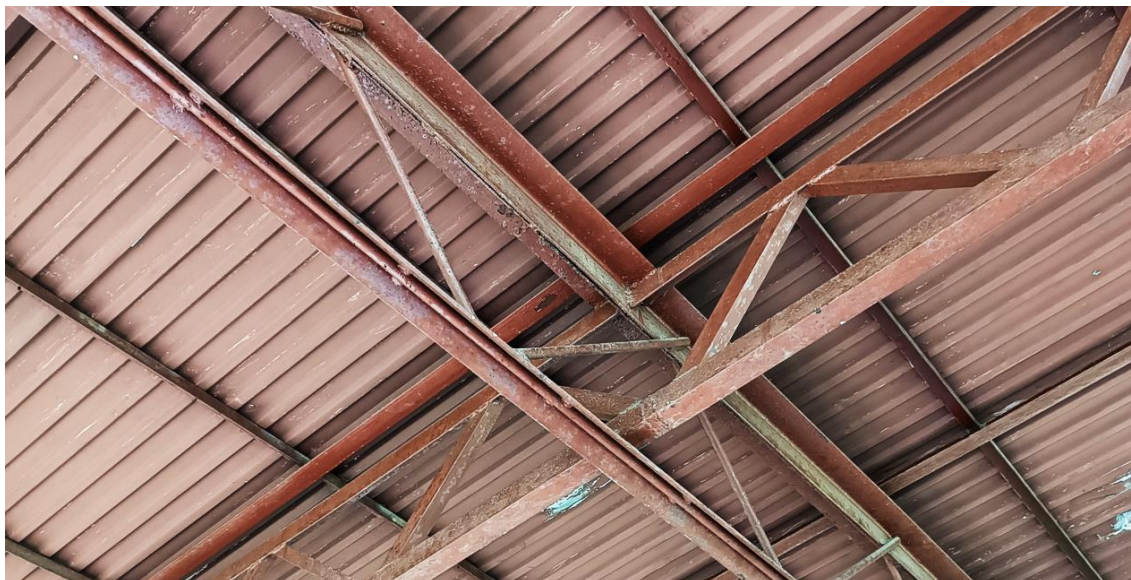
Rys. 4.10 Widok oparcia kratownicy K3 pomiędzy pasami kratownicy K1.
