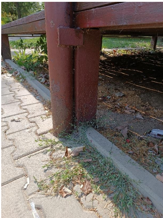
Rys. 4.5 Widok mocowania słupów zadaszenia do słupków podestu – słup pośredni.
