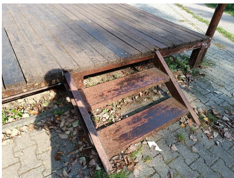
Rys. 6.2 Widoczne uszkodzenie powłok malarskich na schodach.
