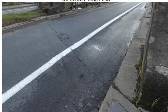
Szczegół nawierzchni bitumicznej jezdni w obrębie oparcia przęsła na przyczółku od strony Oksywie
