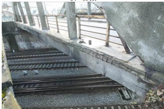
Ściąg wewnętrzznego dźwigara łukowego w osi 04 – widok od strony Oksywi
