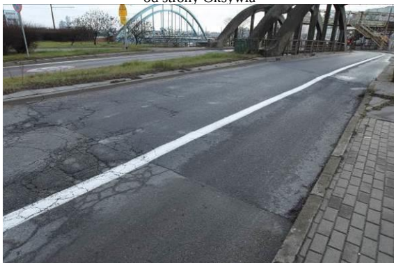
Szczegół nawierzchni bitumicznej jezdni na dojeździe do przęsła od strony Oksywie
