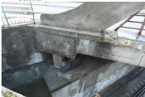
Wezłowie oraz ściąg wewnętrzznego dźwigara łukowego w osi 04 – oś H1
