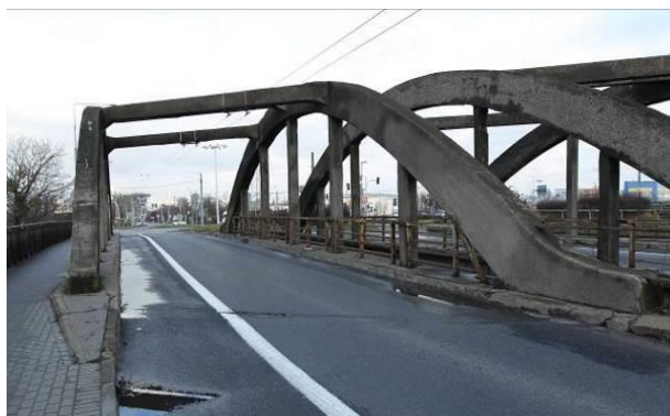
Widok przęsła z poziomu jezdni – widok od strony Śródmieścia
