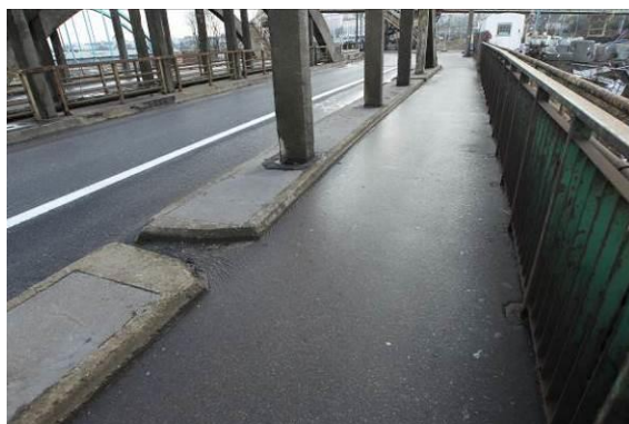
Nawierzchnia na chodniku zewnętrznym
