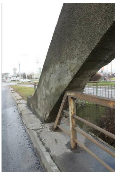
Szczegół dźwigara łukowego w osi o4 w obrębie węzłowania w osi H13
