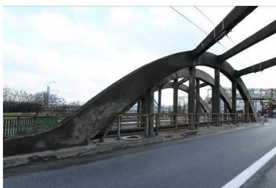
Widok dźwigara łukowego w osi o4 – widok od strony Oksywie
