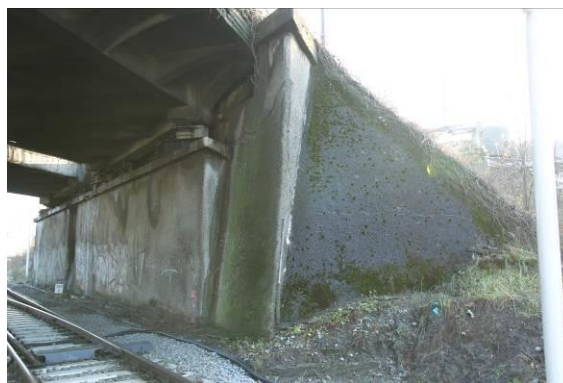
Skrzydło przyczółka od strony Śródmieścia – od strony Chyloni
