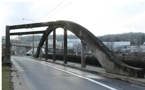
Widok przęsła z poziomu jezdni – widok od strony Oksywiu
