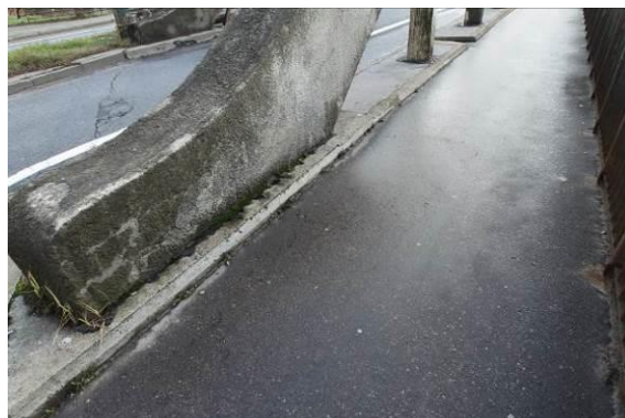
Nawierzchnia na chodniku zewnętrznym w sąsiedztwie węzłowa w osi H16
