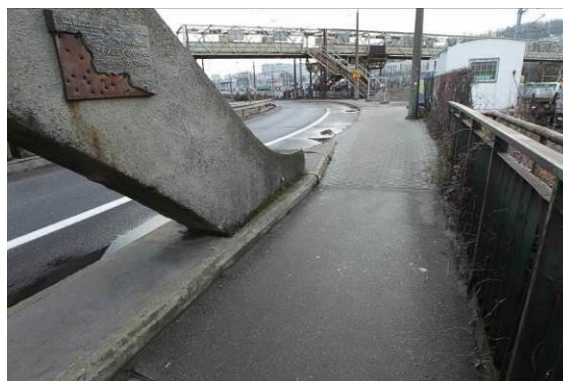
Nawierzchnia na chodniku zewnętrznym w sąsiedztwie węzłowa w osi H4
