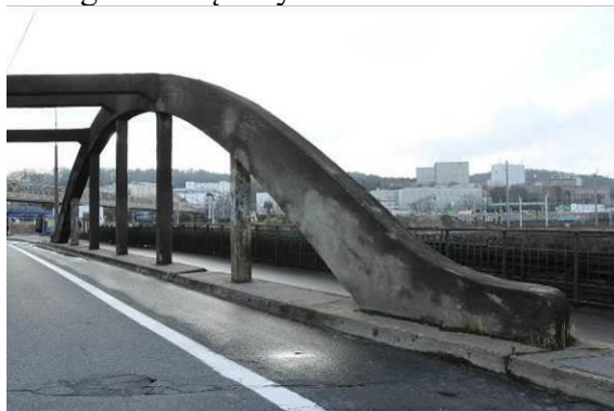
Widok zewnętrznego dźwigara łukowego w osi 01 – widok od strony Oksywi
