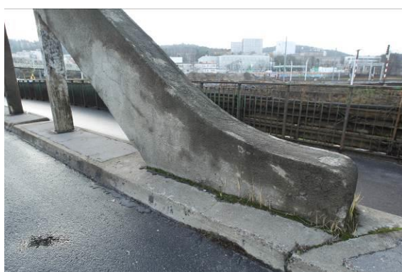
Węzłowie zewnętrznego dźwigara łukowego w osi o1 – oś H16
