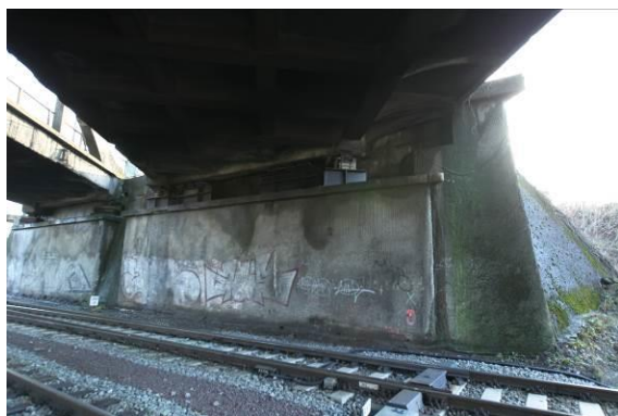
Korpus przyczółka od strony Śródmieścia pod przęsłem od strony Chyloni
