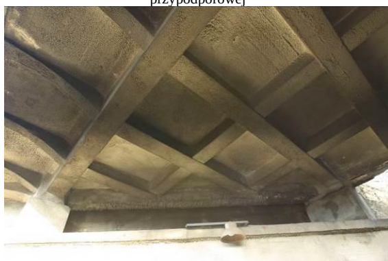
Widok od spodu na pomost w rejonie oparcia konstrukcji przęsła na przyczółku od strony Oksywie oraz w rejonie przypodporowym
