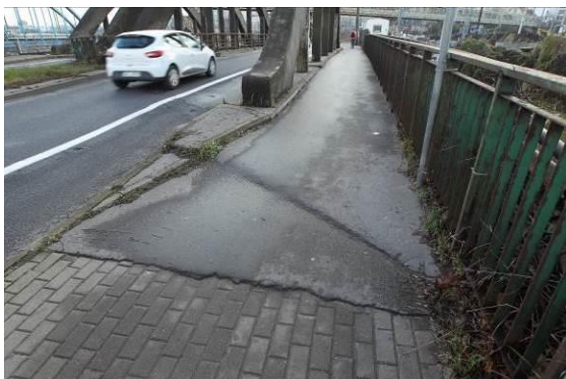
Nawierzchnia na chodniku zewnętrznym wzdłuż osi o1
