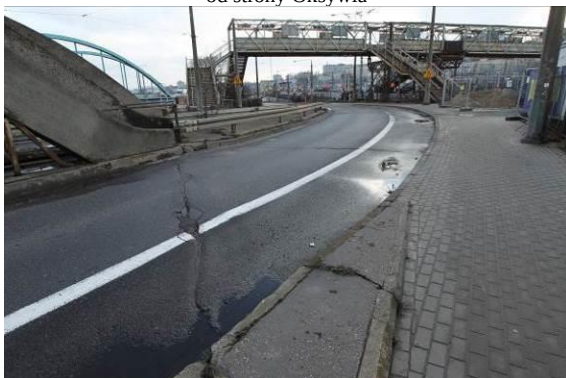
Szczegół nawierzchni bitumicznej jezdni na dojeździe oraz w obrębie oparcia przęsła na przyczółku od strony Śródmieścia
