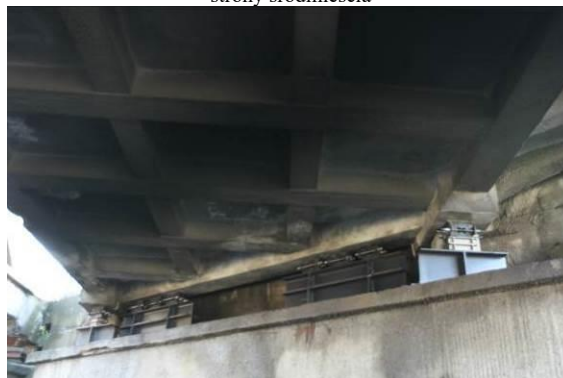
Widok od spodu na pomost w rejonie oparcia konstrukcji przęsła na przyczółku od strony Śródmieścia oraz w rejonie przypodporowym
