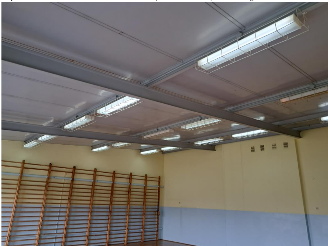
Zdjęcie nr 1 – Widok na rozmieszczenie i montaż opraw oświetlenia podstawowego
