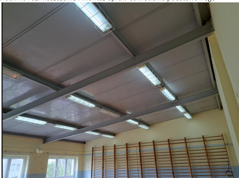
Zdjęcie nr 2 – Widok na rozmieszczenie i montaż opraw oświetlenia podstawowego
