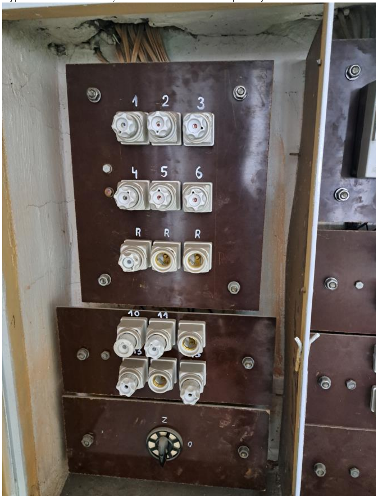
Zdjęcie nr 6 – Rozdzielnica elektryczna z obwodami oświetlenia Sali sportowej
