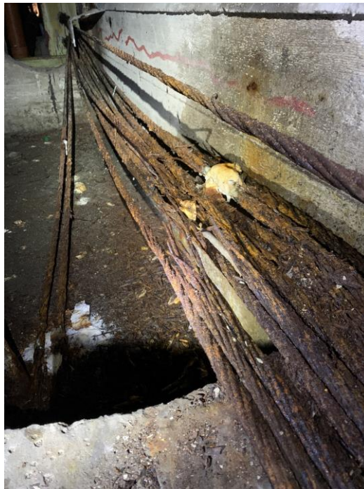
Fot.2.32 Kanał IX, podpora C: Korozja kabla typu (a) na skutek przecieków wody z płyty pomostu (strona lewa), zerwane liny kabli typu (b) na skutek korozji spowodowanej przeciekiem wody przez płytę pomostu (strona prawa).
