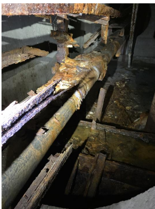
Fot.2.34 Skorodowany stelaż utrzymujący instalację kablową w kanale I (strona lewa), skorodowany podest pod instalacją kablową w kanale III (strona prawa)
