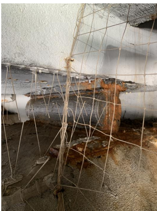
Fot.2.20 Łożyska wałkowe na przyczółkach
