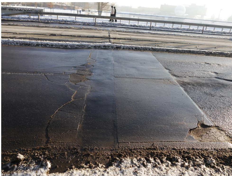
Fot.2.4 Nawierzchnia na dojeździe od ulicy Dietla (jezdnia od górnej wody)
