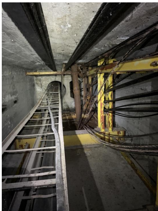
Fot.2.26 Kanał I, podpora B: zwisające luźno zerwane liny jednego z trzech kabli typu (a), z boku luźne na skutek zerwania kable typu (b) w dewiatorze (strona lewa), blok oporowy kabli typu (a) (strona prawa)
