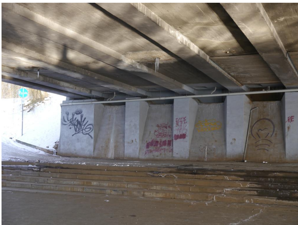
Fot.1.4 Spód konstrukcji przęsła i przyczółek od strony ul. Dietla
