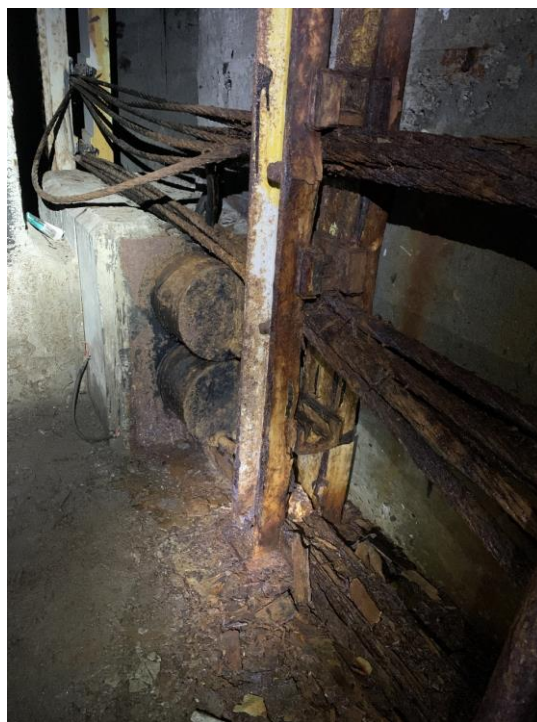
Fot.2.31 Kanał IX, podpora C: Luźne liny kabli typu (b) na skutek ich zerwania w sąsiednich sekcjach (strona lewa), skorodowane i zerwane liny w kablach typu (b), widoczne zakotwienie kabli dolnego rzędu (strona prawa)
