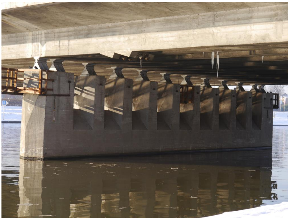
Fot.1.3 Filar od strony ul. Dietla
