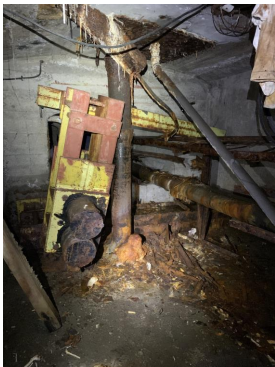
Fot.2.25 Kanał I, podpora B: blok oporowy dwóch kabli typu (b) luźno odsunięty od poprzecznicy na skutek zerwania kabli (strona lewa), zerwane kable typu (b) na skutek korozji stali. W tle luźno odsunięty blok oporowy za poprzecnicą (strona prawa)
