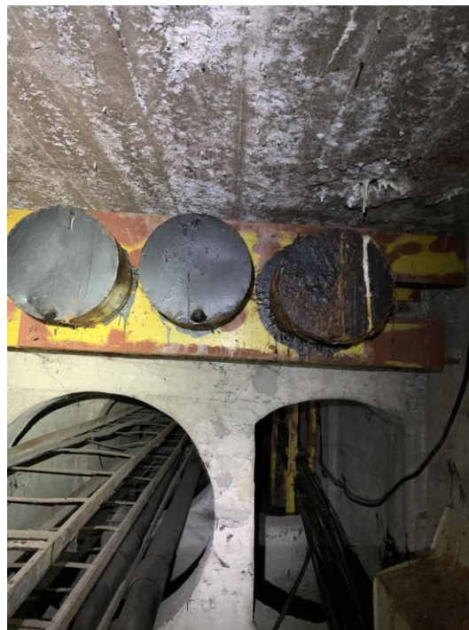
Fot.2.26 Kanał I, podpora B: zwisające luźno zerwane liny jednego z trzech kabli typu (a), z boku luźne na skutek zerwania kable typu (b) w dewiatorze (strona lewa), blok oporowy kabli typu (a) (strona prawa)
