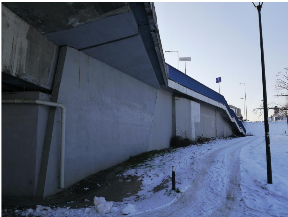
Fot.2.1 Skrzydło od strony górnej wody i Ronda Grunwaldzkiego
