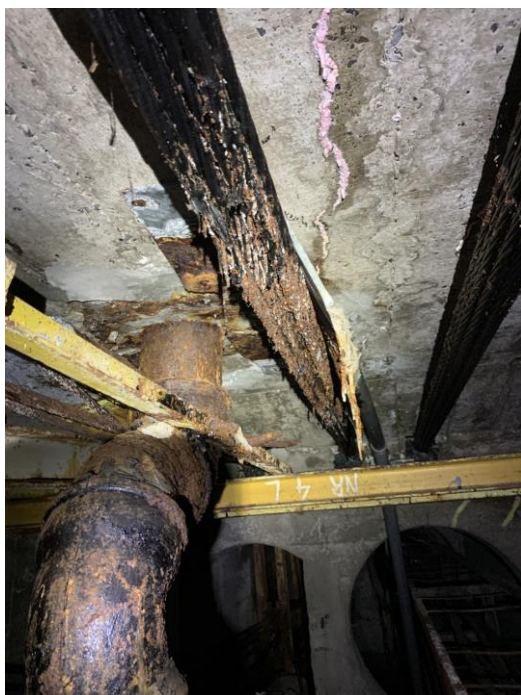
Fot.2.32 Kanał IX, podpora C: Korozja kabla typu (a) na skutek przecieków wody z płyty pomostu (strona lewa), zerwane liny kabli typu (b) na skutek korozji spowodowanej przeciekiem wody przez płytę pomostu (strona prawa).
