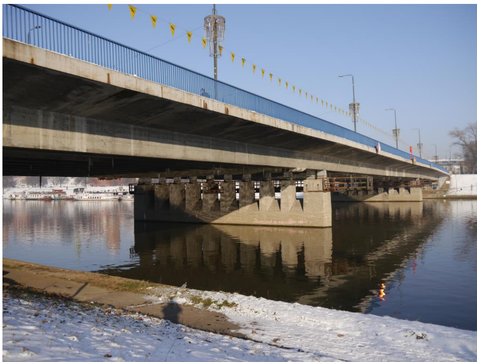
Fot.1.1 Widok ogólny mostu od strony dolnej wody
