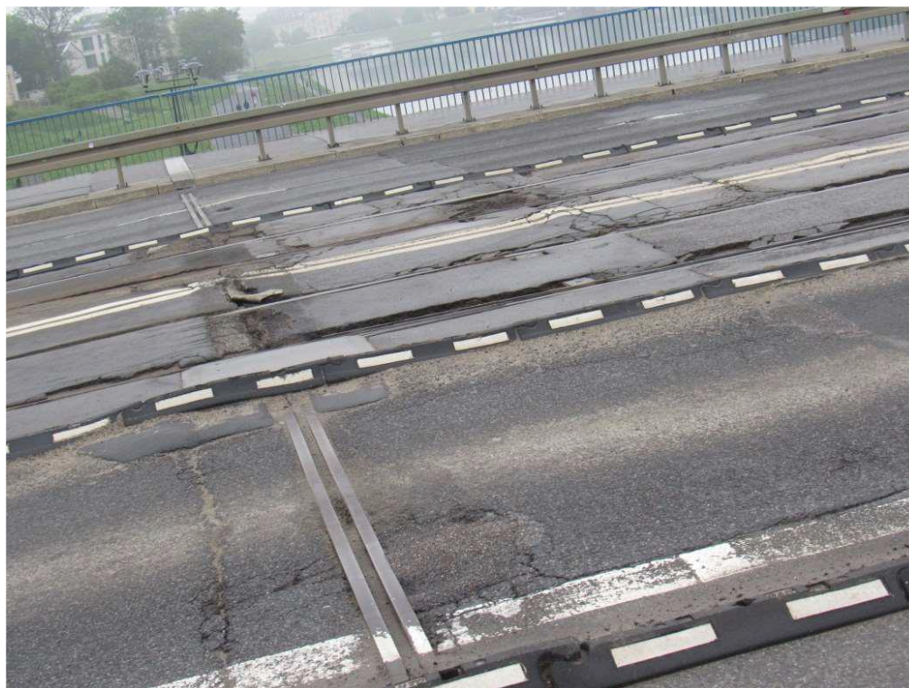
Fot.2.22 Urządzenie dylatacyjne od strony Ronda Grunwaldzkiego
