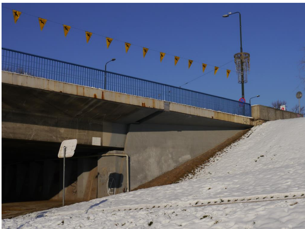
Fot.2.2 Skrzydło i nasyp od strony dolnej wody i ul. Dietla
