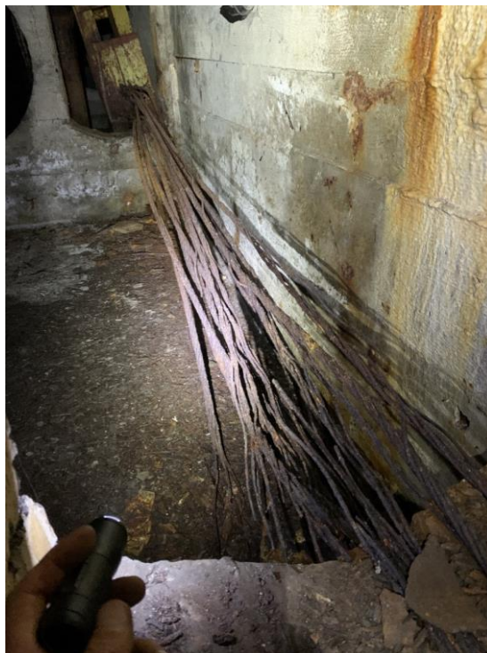
Fot.2.25 Kanał I, podpora B: blok oporowy dwóch kabli typu (b) luźno odsunięty od poprzecznicy na skutek zerwania kabli (strona lewa), zerwane kable typu (b) na skutek korozji stali. W tle luźno odsunięty blok oporowy za poprzecnicą (strona prawa)
