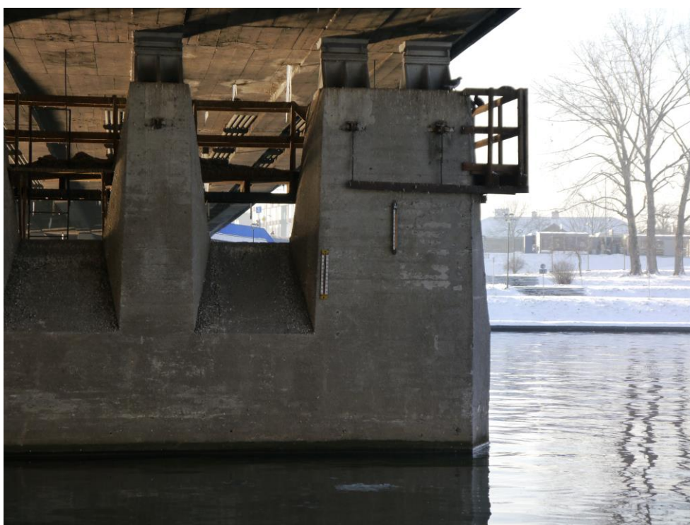
Fot.2.24 Stan filara od strony ul. Dietla
