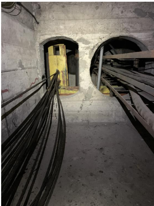
Fot.2.31 Kanał IX, podpora C: Luźne liny kabli typu (b) na skutek ich zerwania w sąsiednich sekcjach (strona lewa), skorodowane i zerwane liny w kablach typu (b), widoczne zakotwienie kabli dolnego rzędu (strona prawa)
