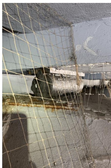
Fot.2.20 Łożyska wałkowe na przyczółkach
