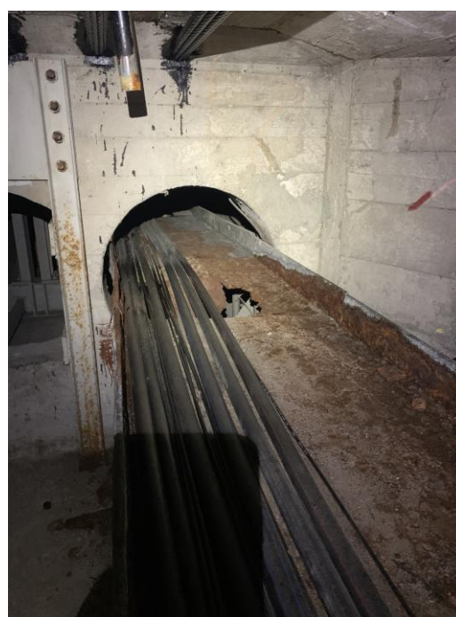
Fot.2.34 Skorodowany stelaż utrzymujący instalację kablową w kanale I (strona lewa), skorodowany podest pod instalacją kablową w kanale III (strona prawa)
