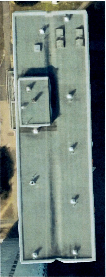
Zdj. 2 – Widok dachu budynku z góry
