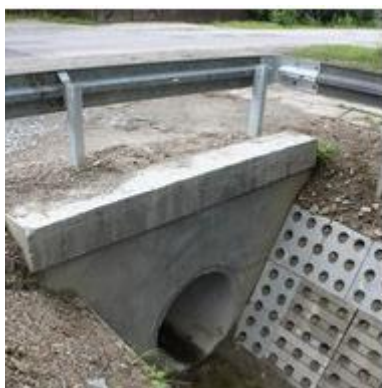
Fot. 8. Przykłady umocnienia skarp i dna rowu w sąsiedztwie wylotu przepustu
