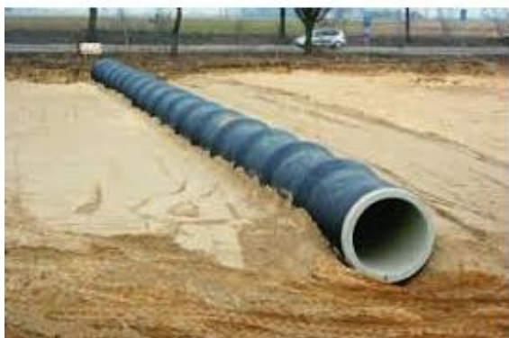
Fot. 6. Zmontowana część przelotowa przepustu
