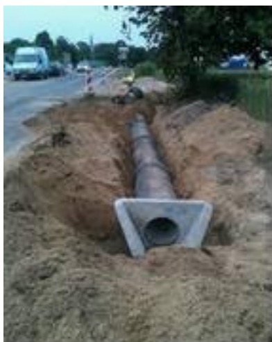
Fot. 7. Przepust z zamontowanym elementem wylotu
