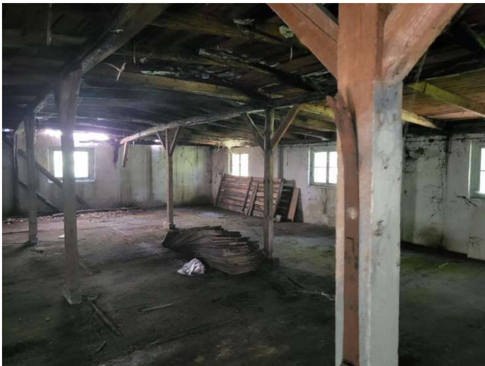
Fot. 5 Budynek magazynowy z rampą: Parter- wewnątrz
