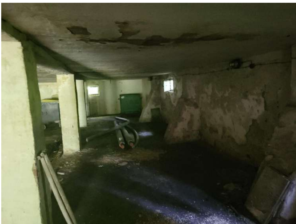
Fot. 8 Budynek magazynowy z rampą: Piwnica- wewnątrz
