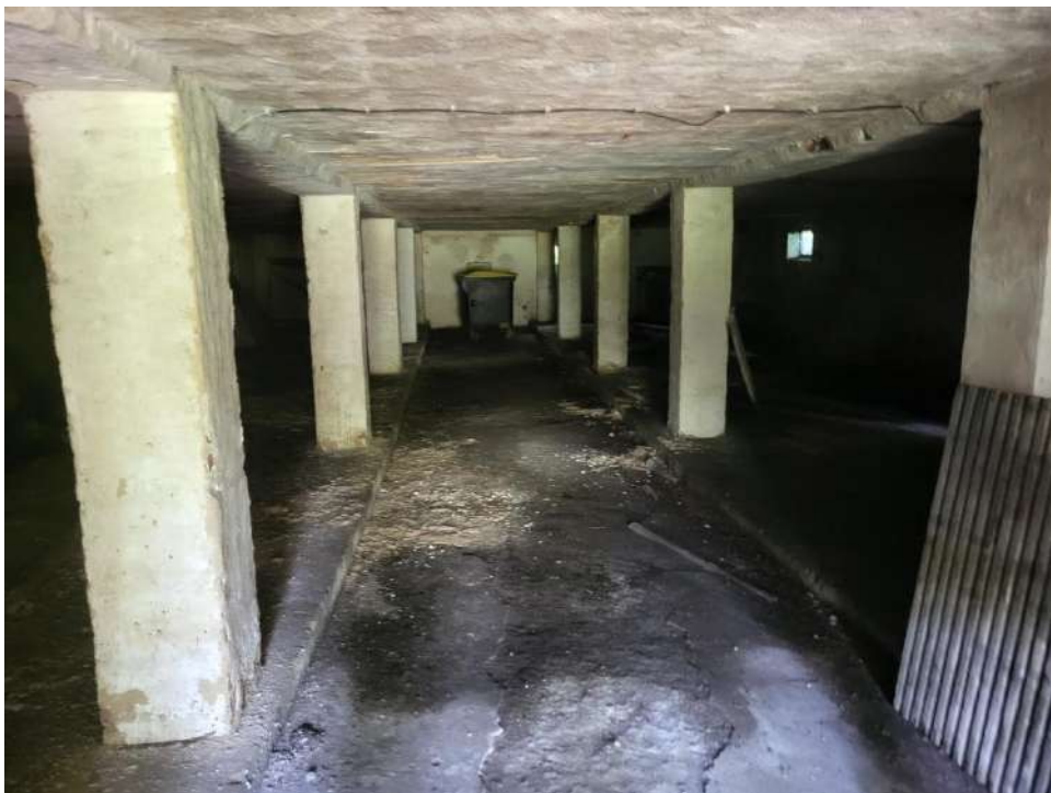
Fot. 7 Budynek magazynowy z rampą: Piwnica- wewnątrz
