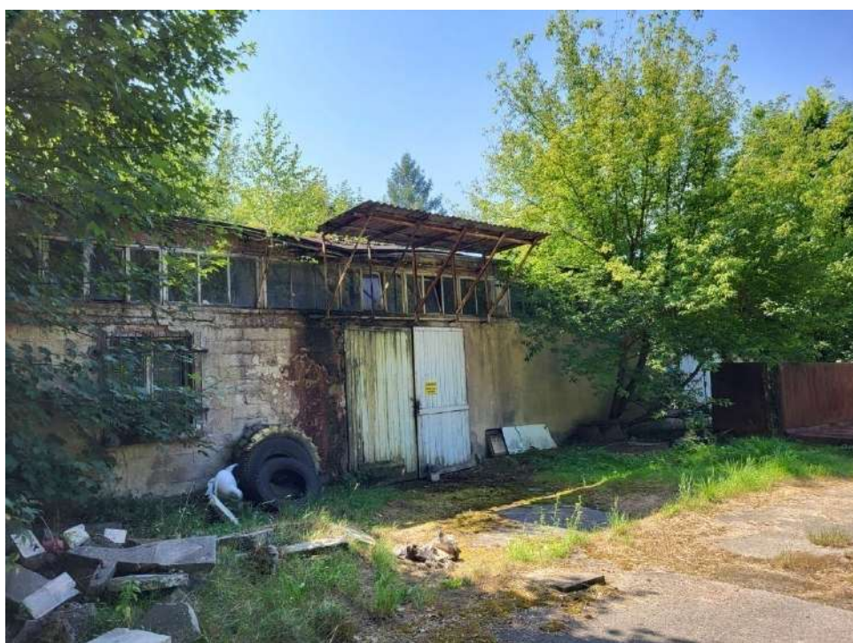
Fot. 2 Magazyn nawozów - hangar: Elewacja północno-zachodnia
