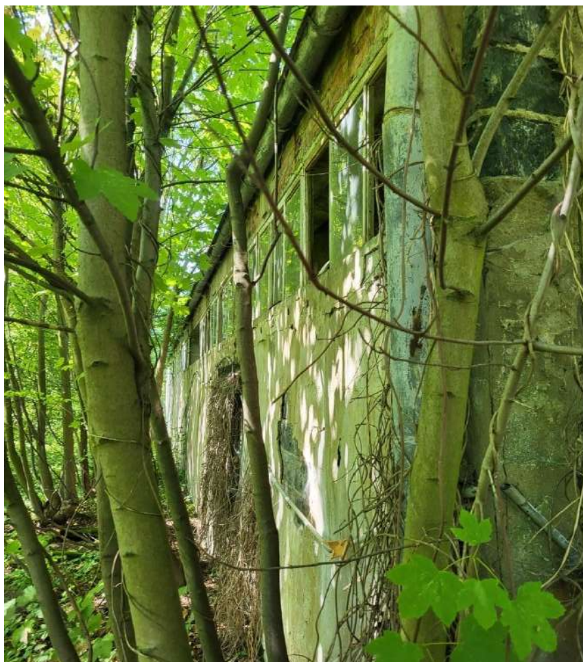
Fot. 4 Magazyn nawozów - hangar: Elewacja południowo-wschodnia
