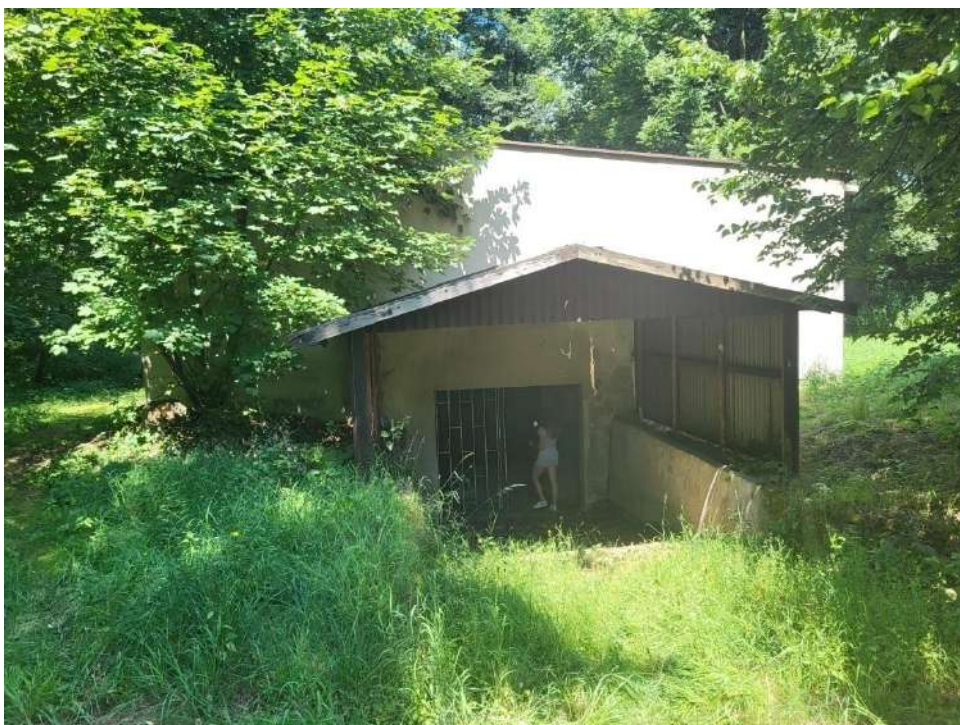
Fot. 1 Budynek magazynowy z rampą: Elewacja południowo-wschodnia
