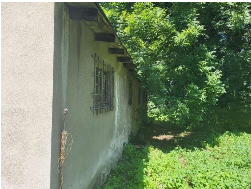
Fot. 2 Budynek magazynowy z rampą: Elewacja północno-wschodnia
