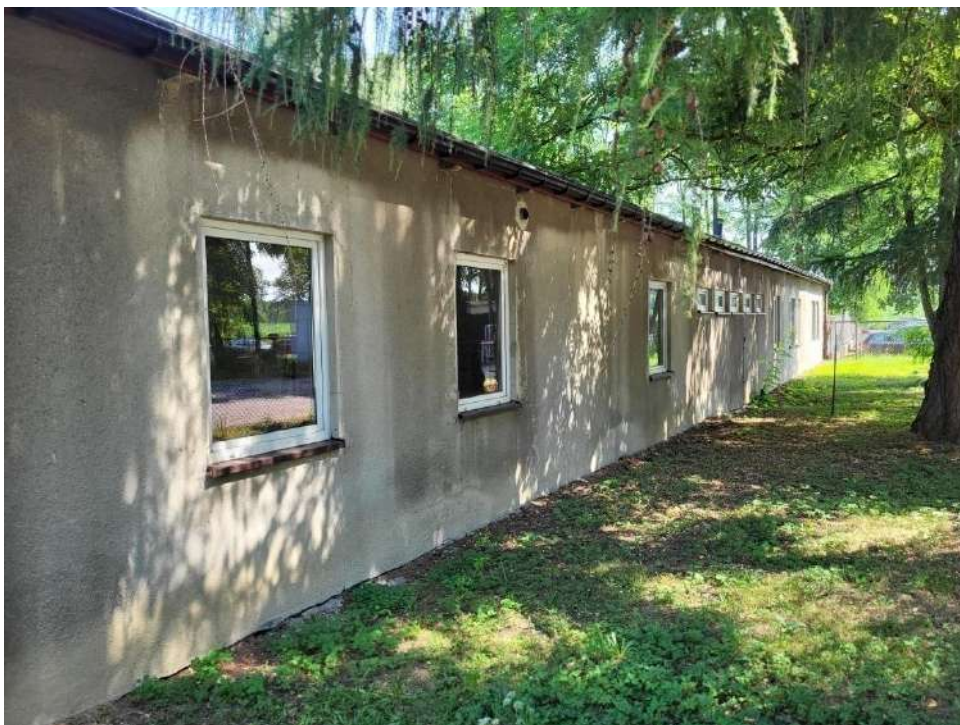
Fot. 2 Budynek magazynowy z rampą: Elewacja południowo-wschodnia
