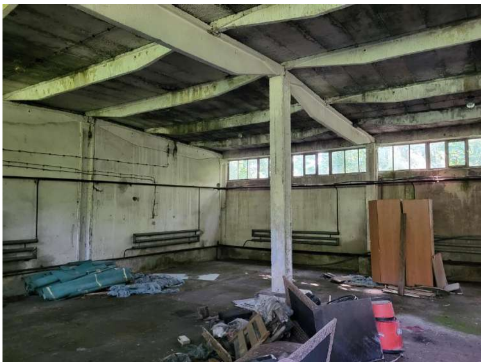
Fot. 5 Magazyn nawozów - hangar: wewnątrz
