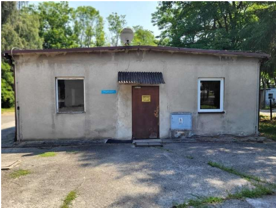
Fot. 1 Barak gospodarczy – warsztat: Elewacja południowo-zachodnia
