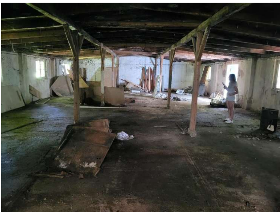
Fot. 6 Budynek magazynowy z rampą: Parter- wewnątrz
