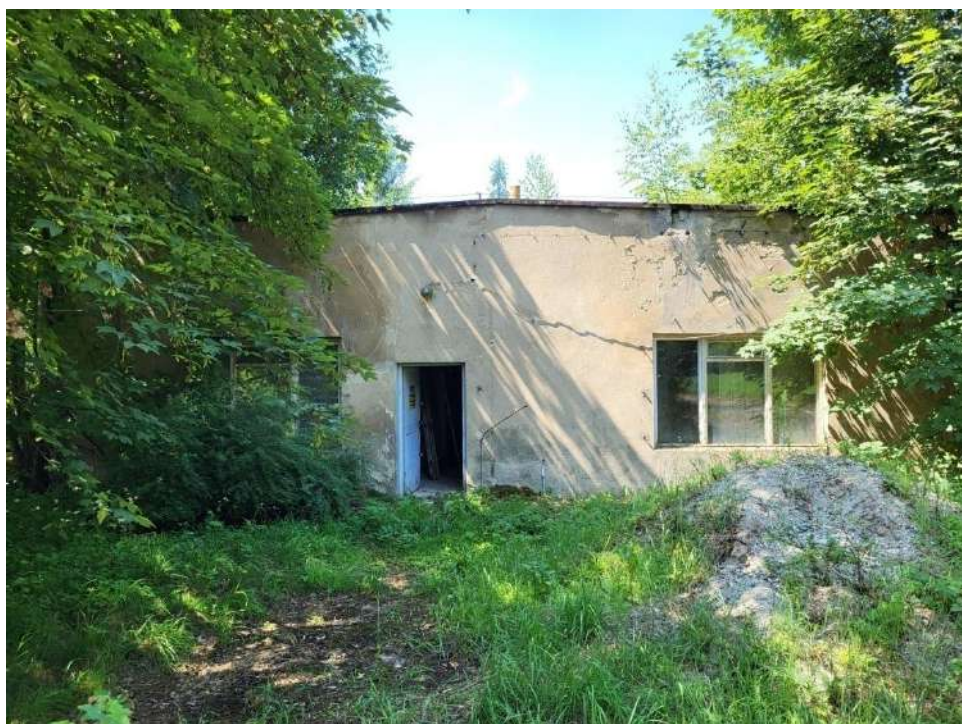
Fot. 1 Magazyn nawozów - hangar: Elewacja północno-wschodnia
