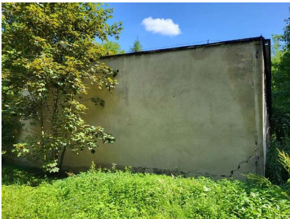
Fot. 3 Magazyn nawozów - hangar: Elewacja południowo-zachodnia
