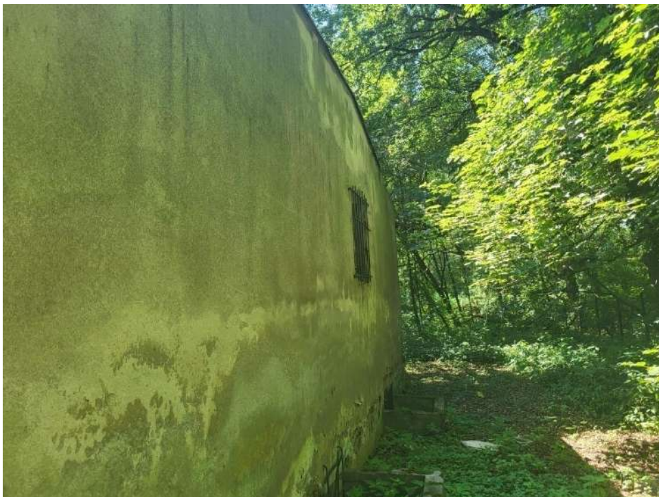
Fot. 3 Budynek magazynowy z rampą: Elewacja północno-zachodnia
