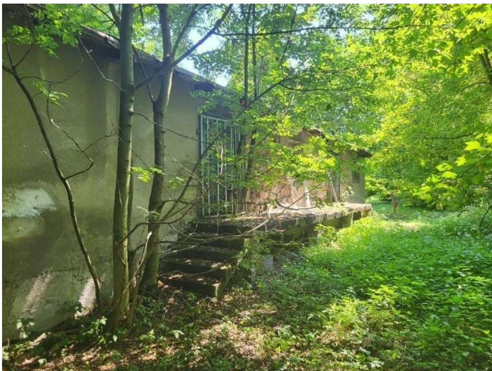
Fot. 4 Budynek magazynowy z rampą: Elewacja południowo-zachodnia
