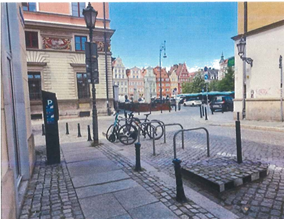
Fotografia 4 Separatory wykonane w obrzeżach stalowych w ul. Ofiar Oświęcimskich – widok na plac Solny
