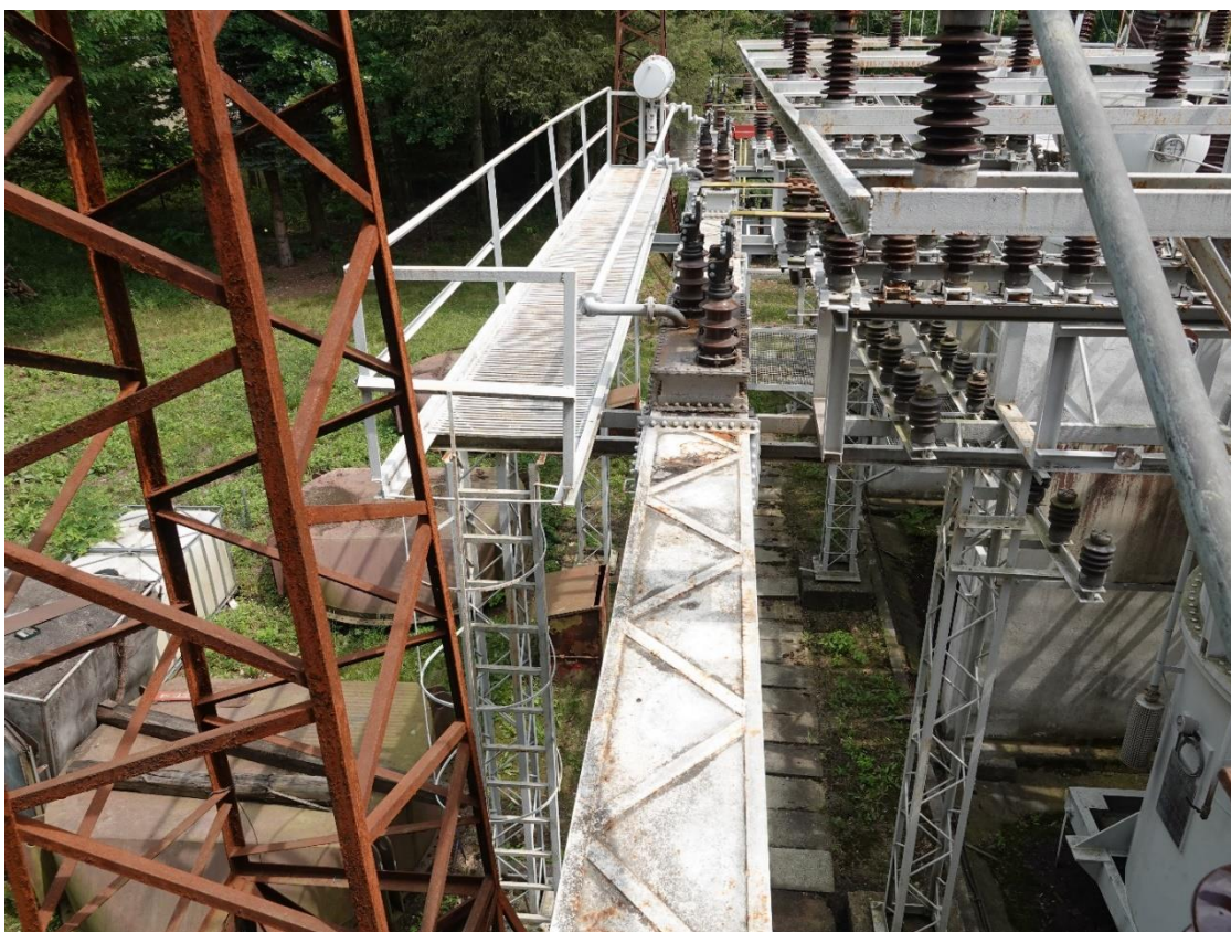
Foto 3. Miejsce przyłącza szynoprzewodu do transformatorów Indelve.
