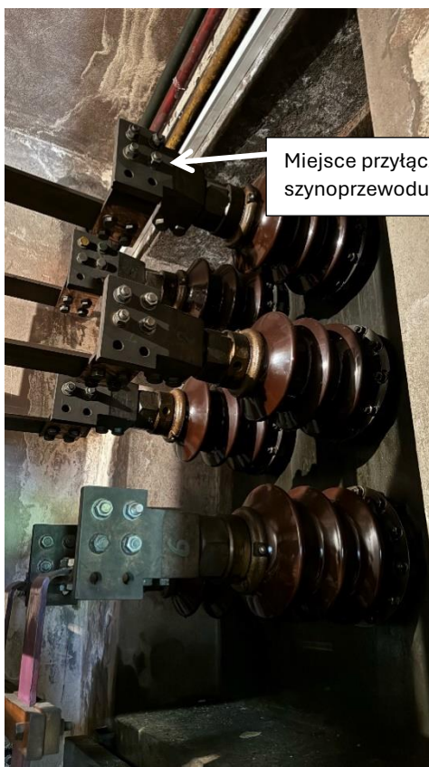
Foto 6. Przejście szynoprzewodu przez ścianę budynku.
