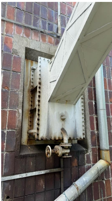
Foto 6. Przejście szynoprzewodu przez ścianę budynku.
