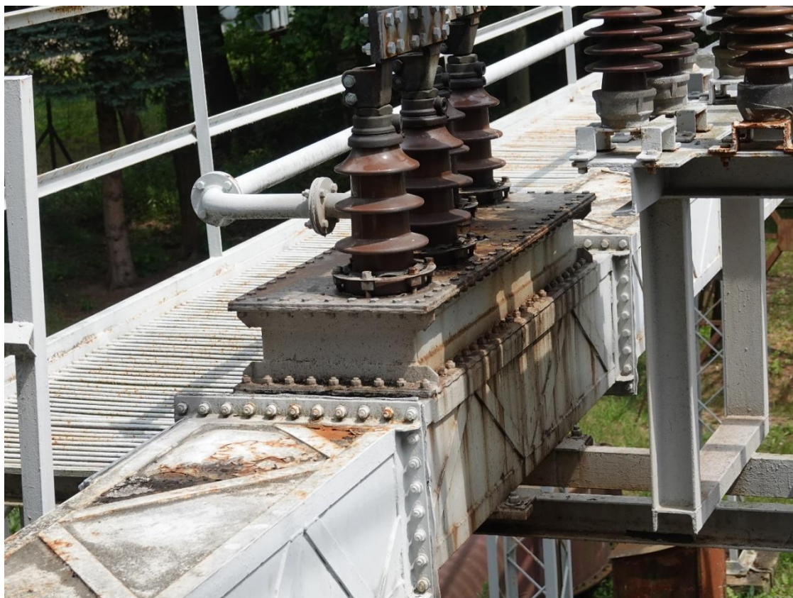
Foto 5. Połączenie szyn z obecnym szynoprzewodem
