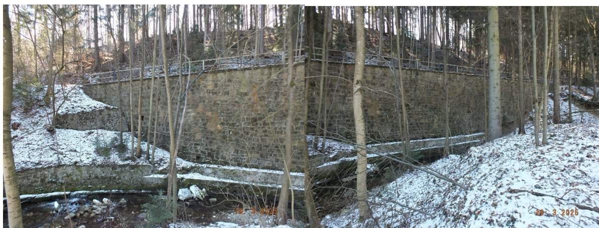
Zanieczyszczenia, korozja biologiczna murów
