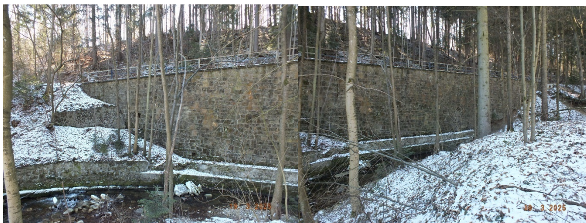
Zanieczyszczenia, korozja biologiczna murów
