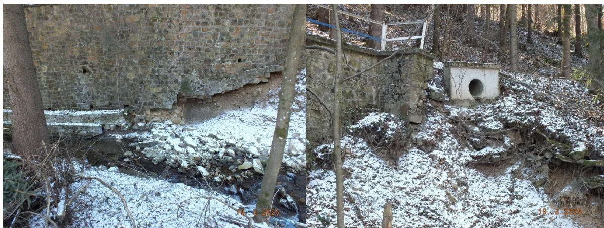
Widok ogólny muru z widocznymi podmyciem konstrukcji kamiennej i skarpy
