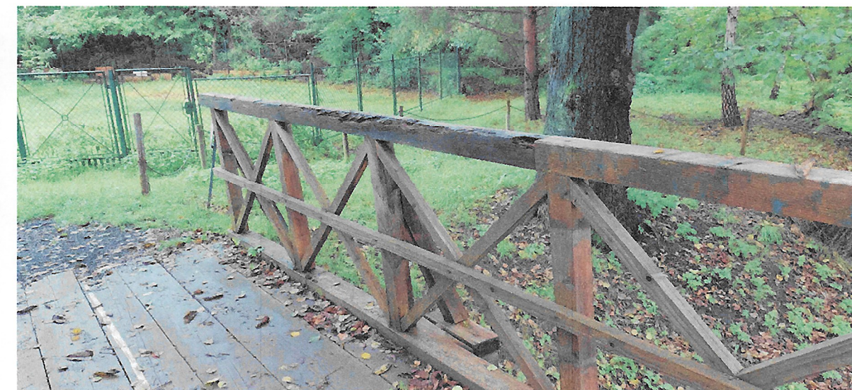
Korozja biologiczna balustrady
