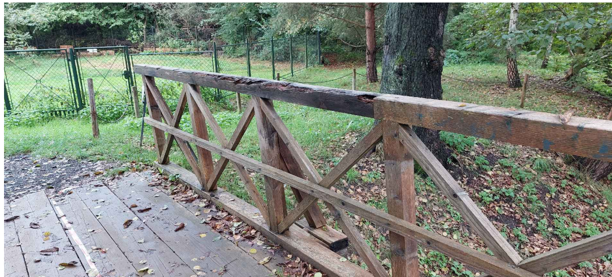
Korozja biologiczna balustrady
