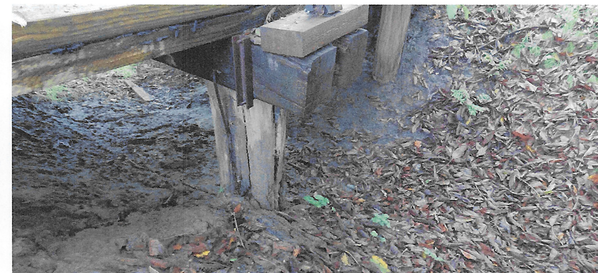
Zniszczenie struktury drewna podpór pośrednich (rozszczipienie wzdłużne)
