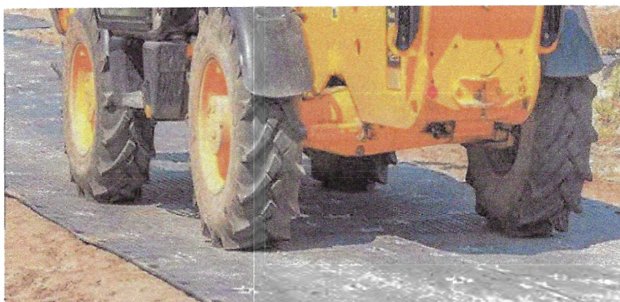
Rys. 4. Przykładowy sposób wykonania drogi tymczasowej
