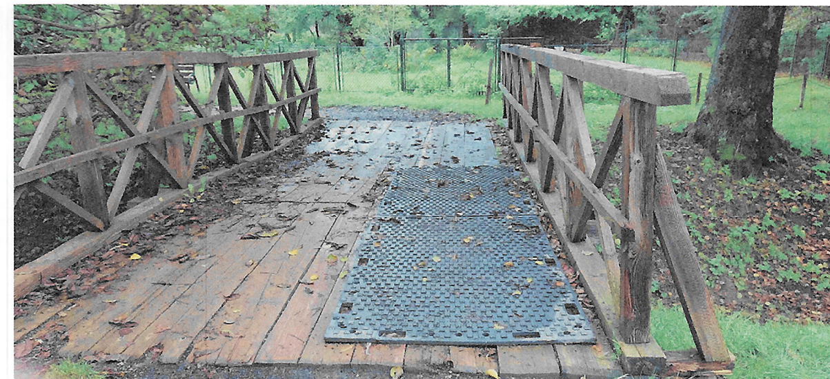
Tymczasowe zabezpieczenie skorodowanego pomostu
