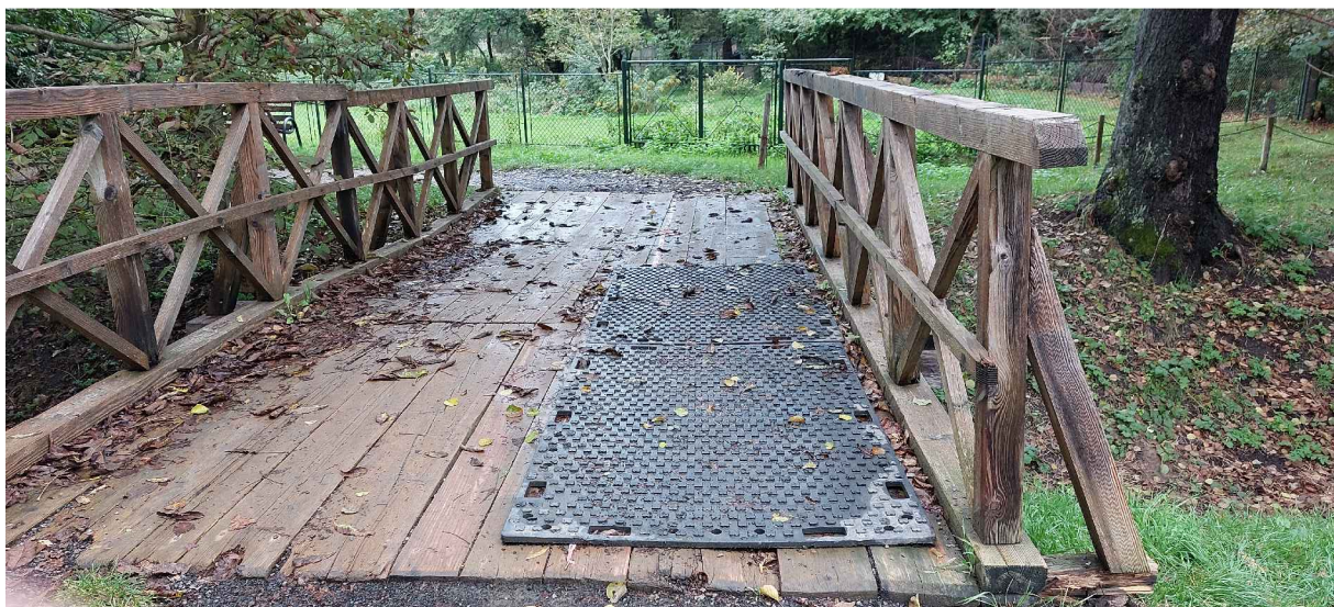
Tymczasowe zabezpieczenie skorodowanego pomostu
