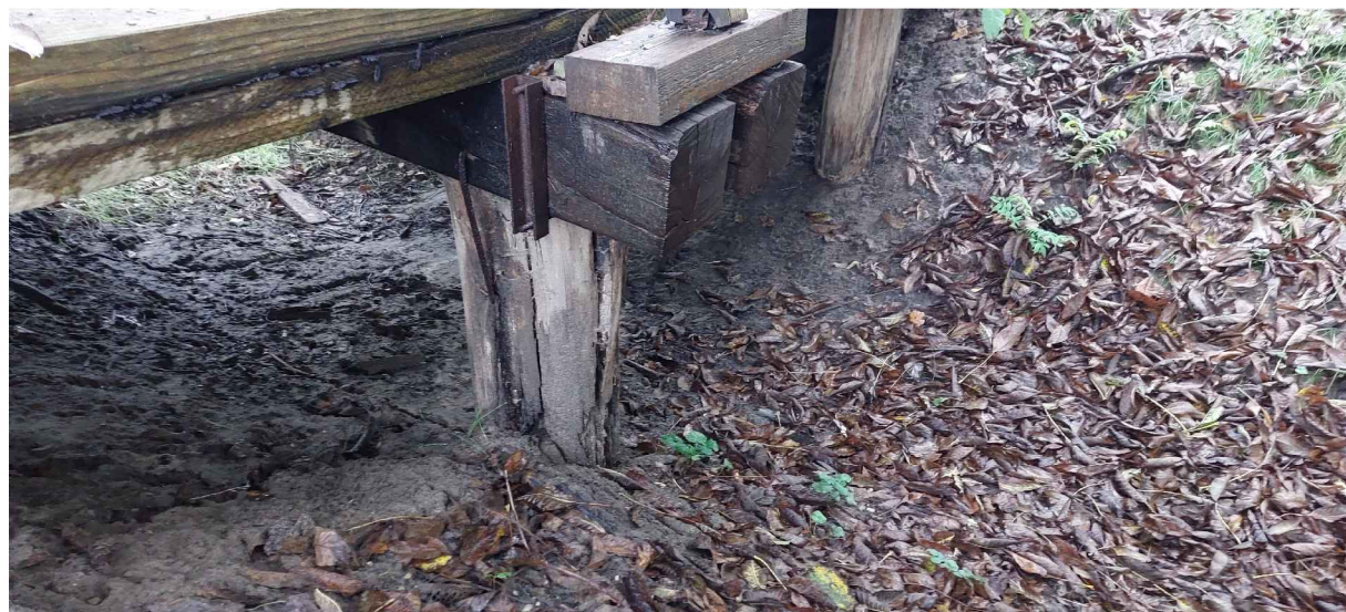
Zniszczenie struktury drewna podpór pośrednich (rozszczerzenie wzdłużne)
