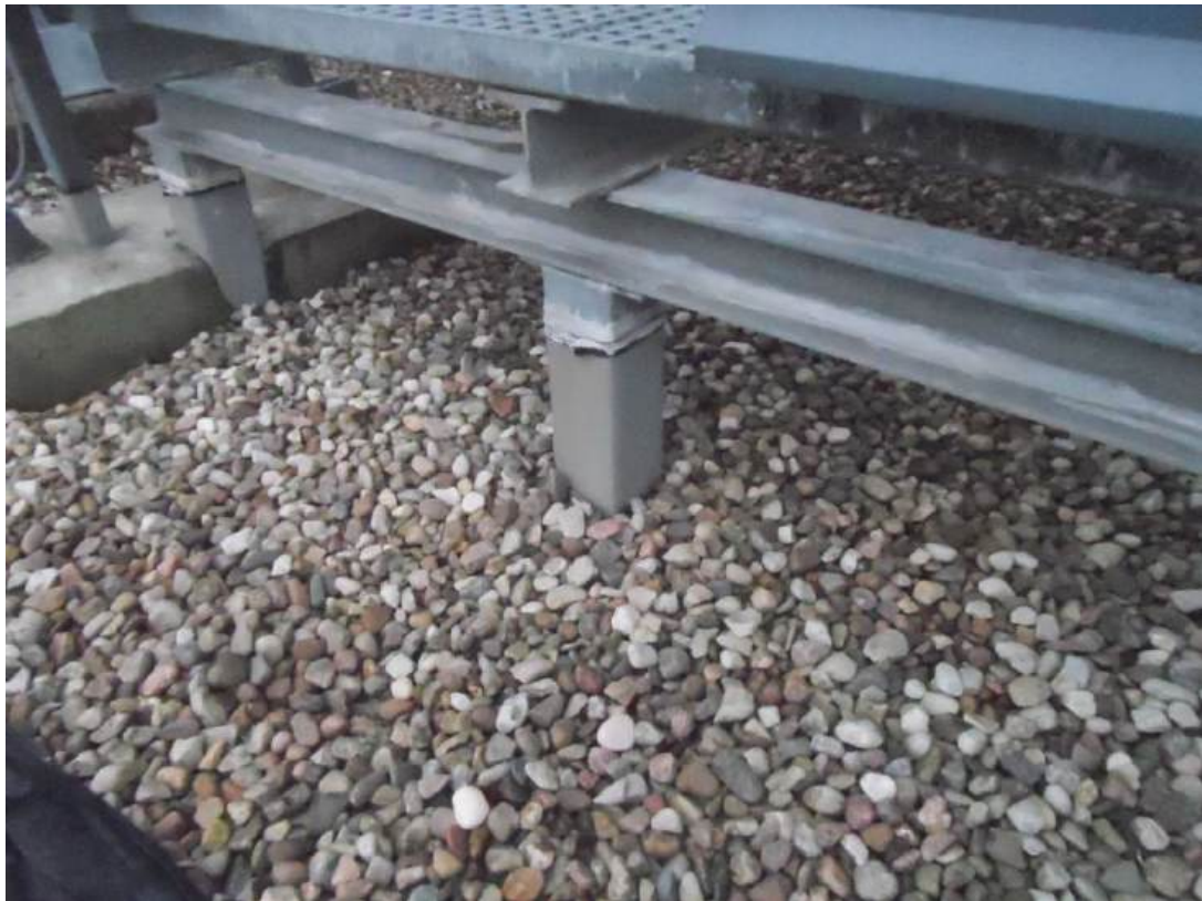
Fot. nr 18 - słupek stalowy z rury kwadratowej 100X100 mm
