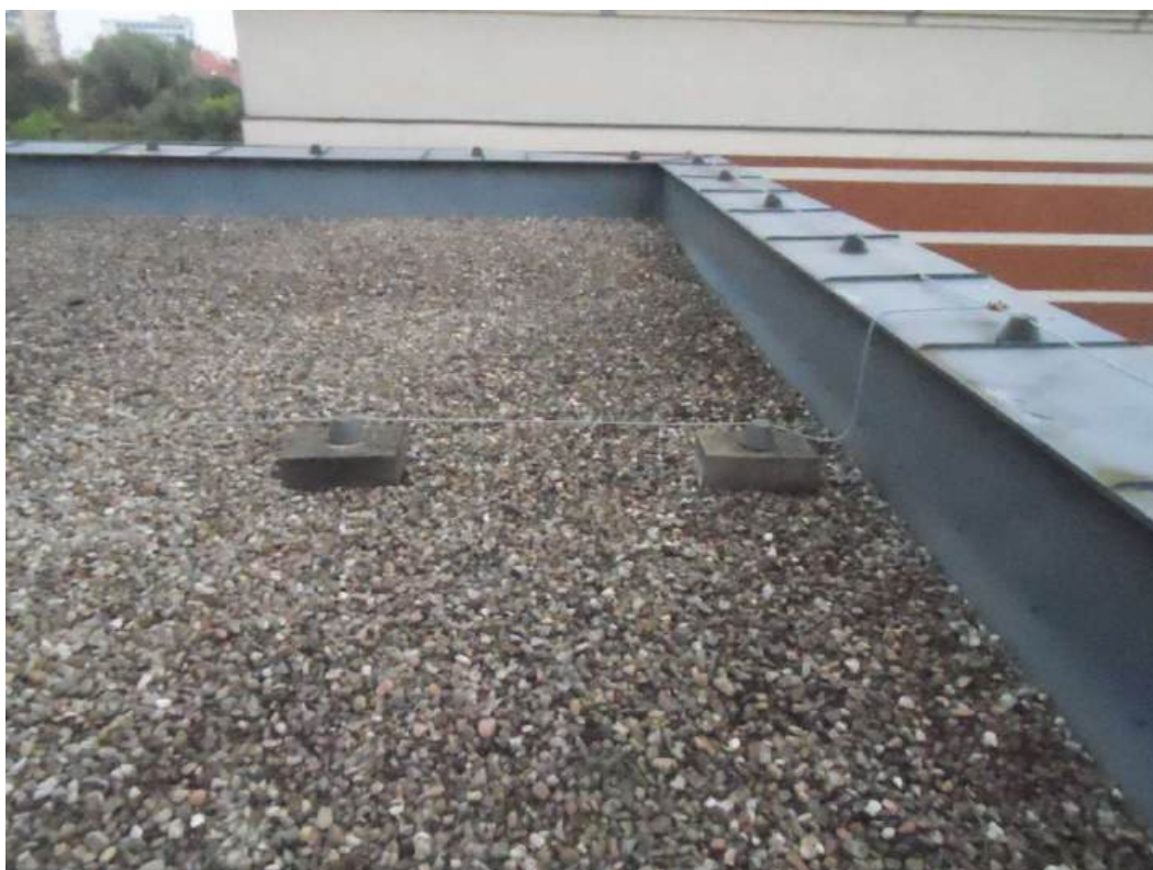
Fot. nr 14 – bloczki betonowe z opartymi na nich wspornikami instalacji odgromowej
