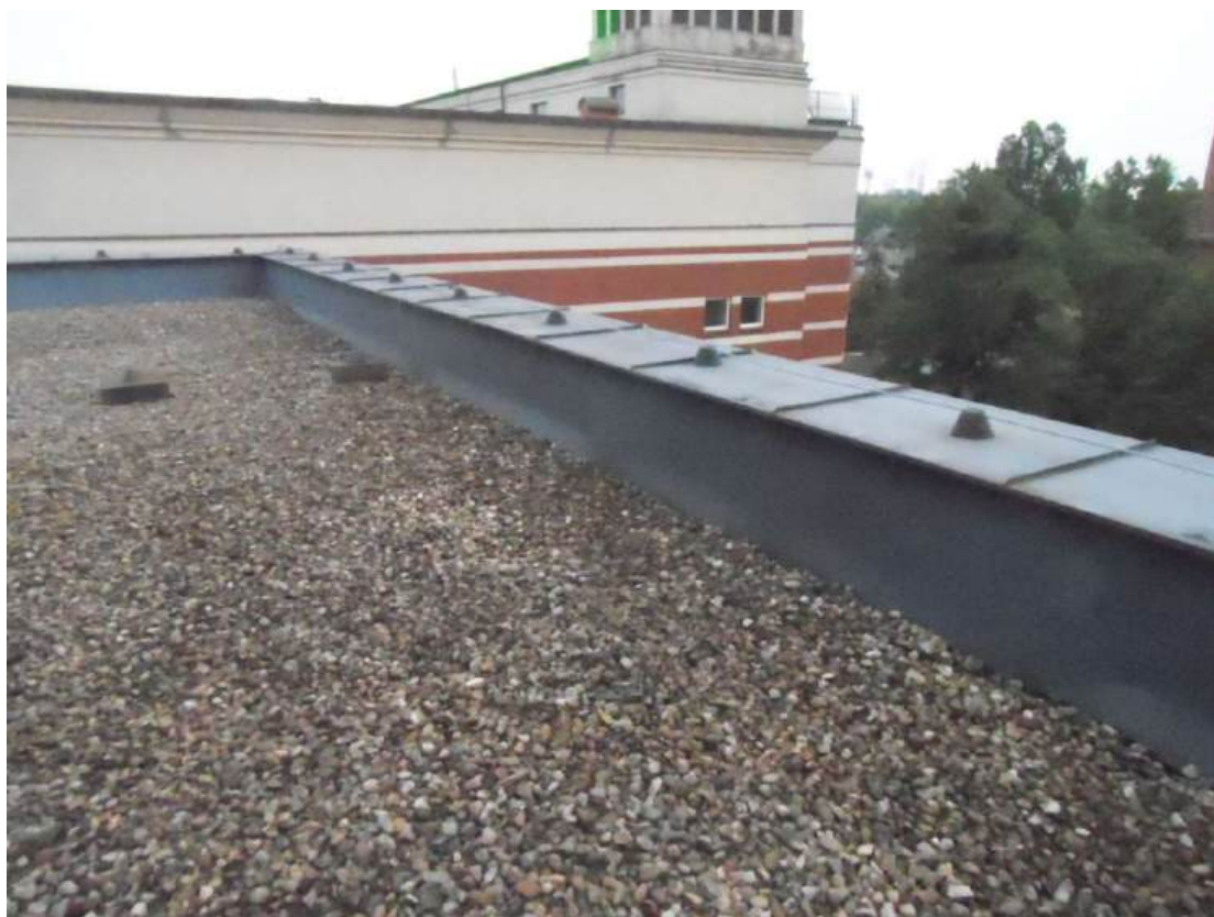
Fot. nr 8 – Otoczaki na dachu – część dachu bez instalacji
