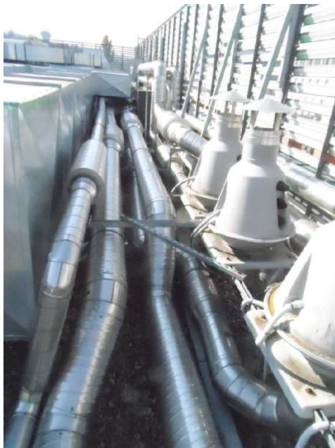
Fot. nr 5 – część widocznych na fotografii instalacji wymaga demontażu na czas wykonywania membrany i po jej wykonaniu odtworzenia (1)
