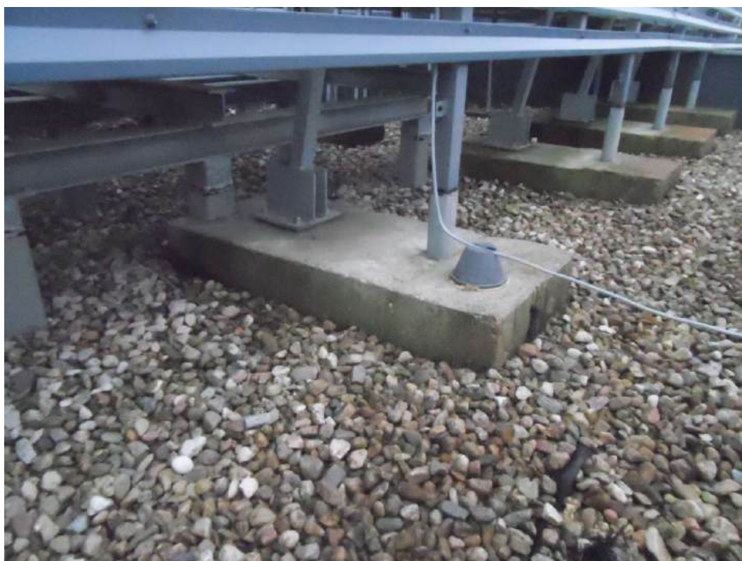
Fot. nr 12 – płyta „obwodowa” wygradzenia na dachu – z opartymi na niej słupkiem ogrodzenia i stopą zastrzału stabilizującego ogrodzenie oraz słupkami podtrzymującymi instalacje
