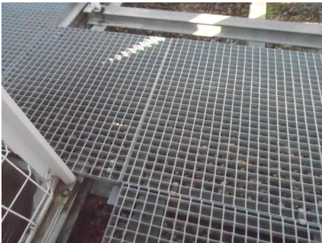
Fot. nr 7 – kraty pomostowe do demontażu i ponownego zamontowania
