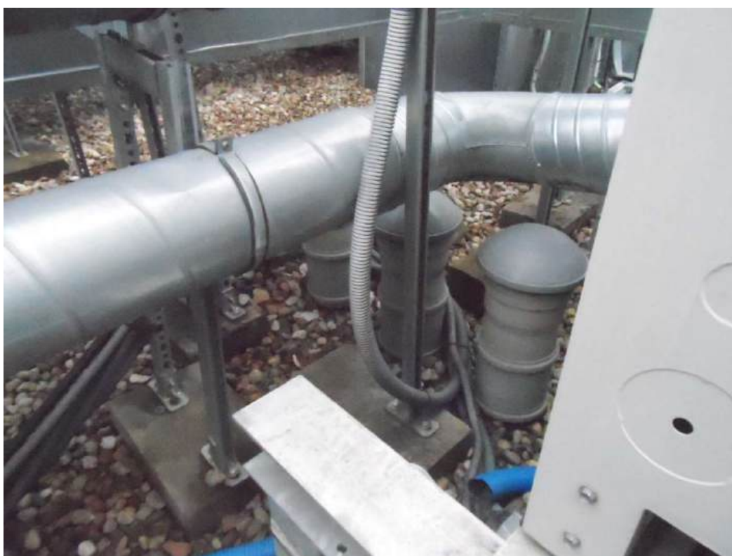
Fot. nr 22 – odpowietrzniki z PCV (widoczne 3, za nimi jest jeszcze jeden)
