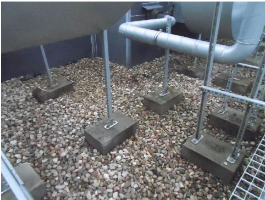
Fot. nr 13 – bloczki betonowe z opartymi na nich słupkami podtrzymującymi instalacje wentylacyjno – klimatyzacyjne
