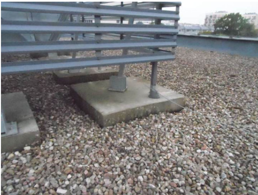
Fot. nr 10 – płyta „narożna” wygradzenia na dachu – z opartymi na niej słupkiem ogrodzenia oraz stopą zastrzału stabilizującego ogrodzenie
