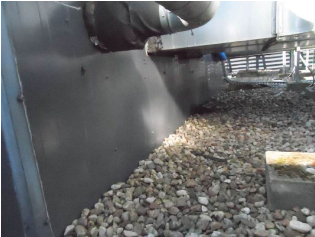
Fot. nr 15 – (po lewej) widoczna ściana obudowy urządzenia – ściana z blachy trapezowej o fali ok. 0,5-0,75 mm
