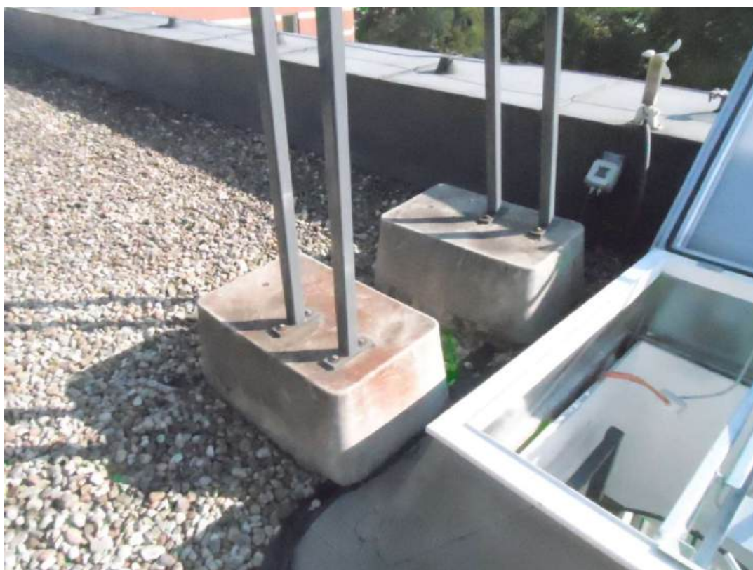
Fot. nr 20 – bloki z zakotwionymi w nich uchwytami przy wyłazie dachowym
