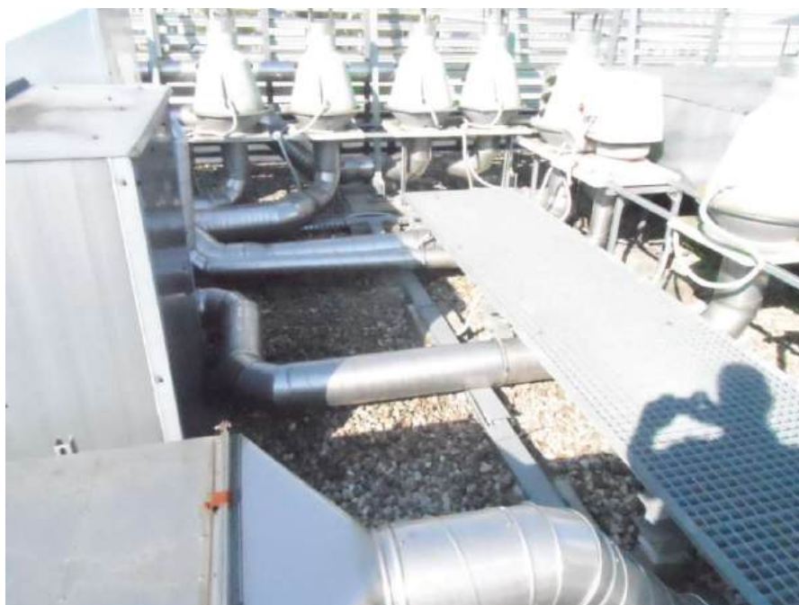
Fot. nr 6 – część widocznych na fotografii instalacji wymaga demontażu na czas wykonywania membrany i po jej wykonaniu odtworzenia (2)
