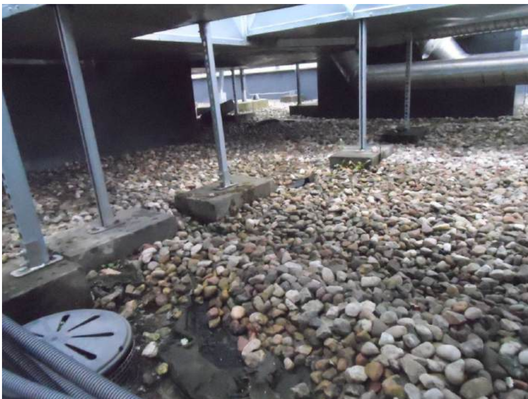
Fot. nr 21 – (po lewej stronie, w dolnej części fotografii) wpust deszczowy
