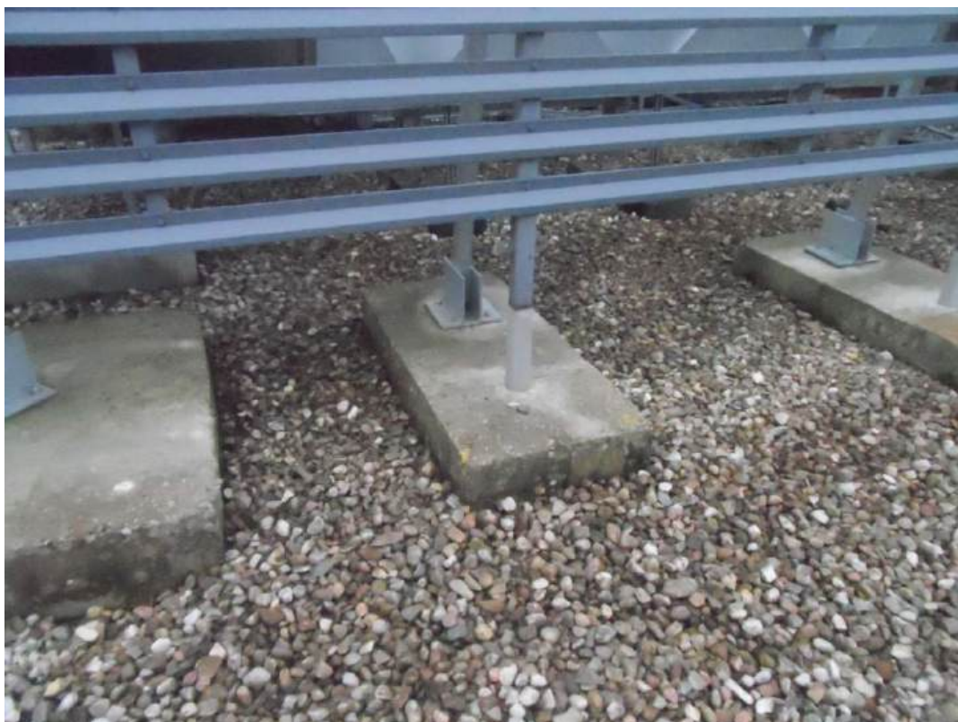
Fot. nr 11 – płyta „obwodowa” wygradzenia na dachu – z opartymi na niej słupkiem ogrodzenia oraz stopą zastrzału stabilizującego ogrodzenie
