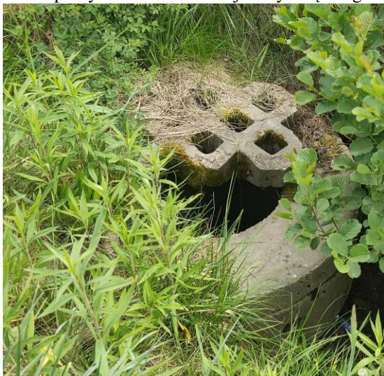
Zdjęcie nr 20 – zbiornik ZB1, rów od strony północno-wschodniej (za ogrodzeniem zbiornika) rów po drógiej stronie drogi wewnętrznej do uzupełnienia pokrywa betonowa zbrojona tytu ciężkiego
