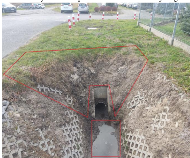
Zdjęcie nr 12 – odmulić istniejący przepust z rur PCV na całej jego długości tj. długości około 50m. Poprawić ułożenie istniejących płyt, wymienić uszkodzone płyty,
