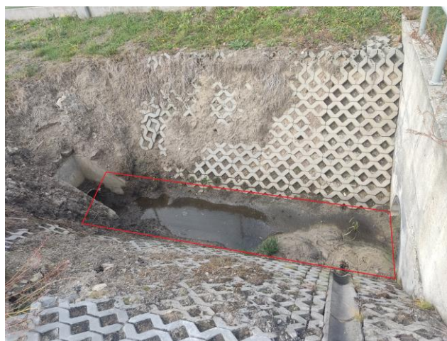
Zdjęcie nr 13 – rów do wyczyszczenia i poprawienia (zgodnie z opisem w OPZ)
