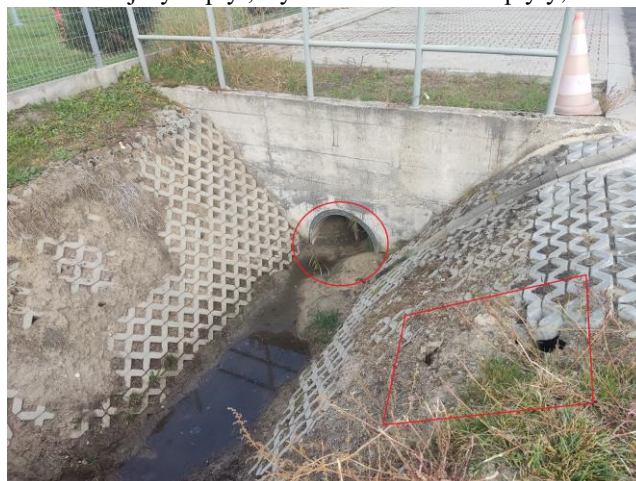
Zdjęcie nr 13 – rów do wyczyszczenia i poprawienia (zgodnie z opisem w OPZ)
