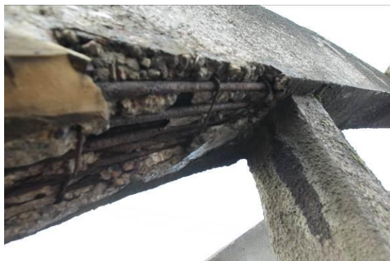
Szczegół spodu dźwigara łukowego w osi o5 w sąsiedztwie wieszaka W1/o5 (od strony wezłowania)
