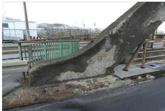
Wezłowie wew dźwigara łukowego w osi o5 – oś C4
