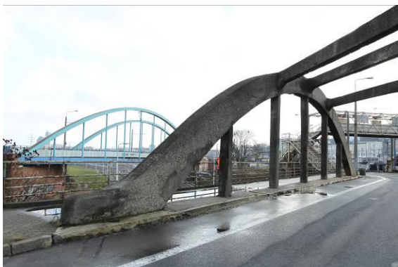
Widok zew dźwigara łukowego w osi o5 – widok od strony Oksywia
