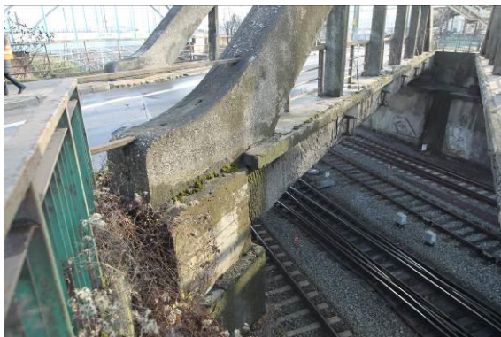
Ściąg łuku w osi 05 -widok do strony Oksywia
