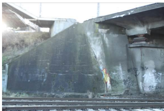
Skrzydło przyczółka od strony Śródmieścia
