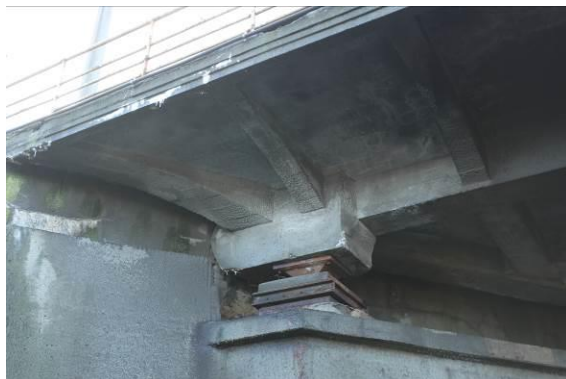
Zew łożysko na przyczółku od strony Śródmieścia
