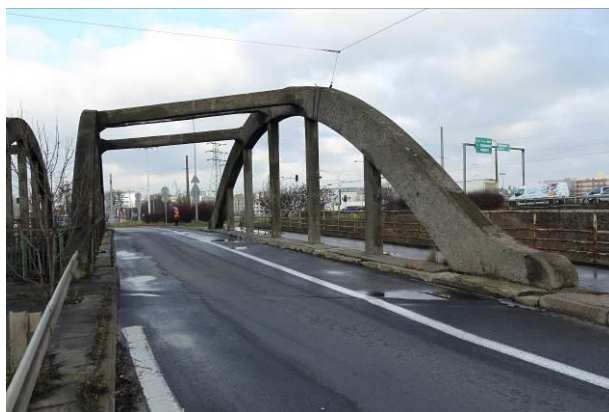
Widok przęsła wiaduktu W/3 – widok od strony Śródmieścia
