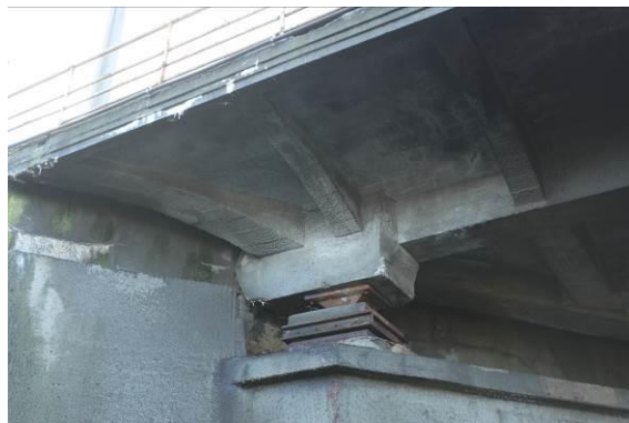
Widok od spodu na zew wspornik pomostu w rejonie oparcia konstrukcji przęsła na przyczółku od strony Śródmieścia
