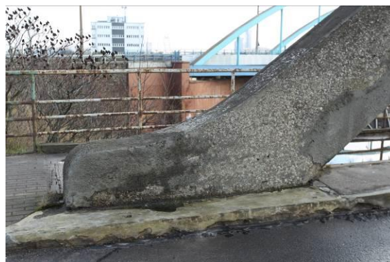
Dźwigar zew w osi o8 przy węzłowi – oś C13
