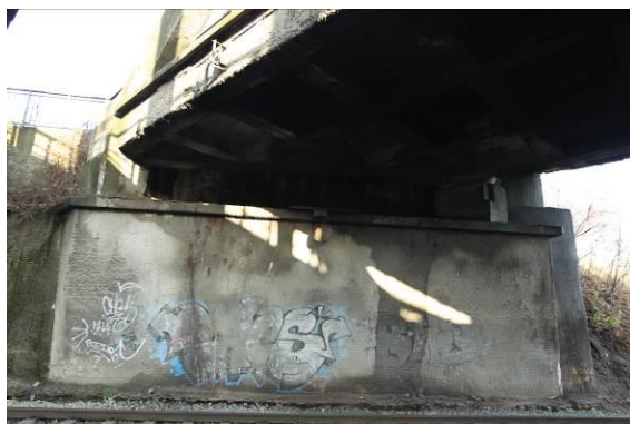
Korpus przyczółka od strony Oksywia
