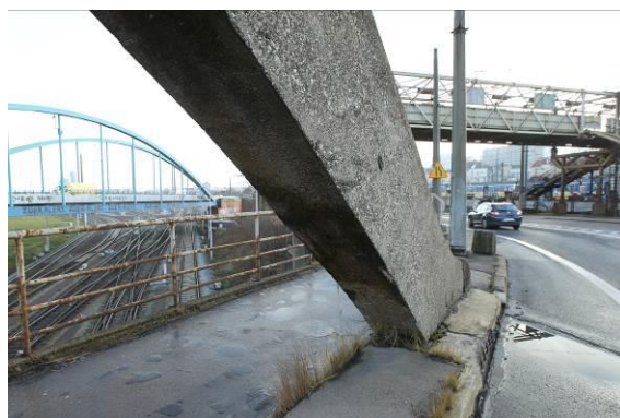
Szczegół spodu zew dźwigara łukowego w osi o8 w sąsiedztwie wezłowania (oś C1)
