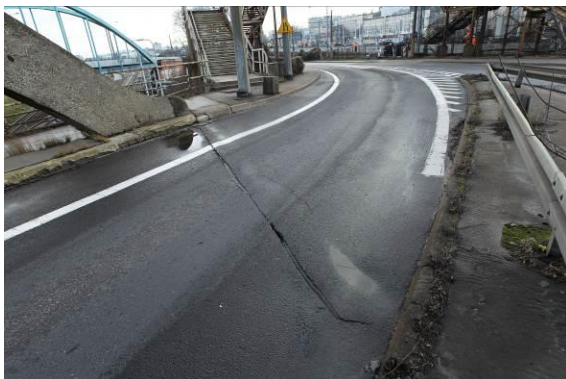
Szczegół nawierzchni bitumicznej jezdni w obrębie oparcia przęsła na przyczółku od strony Śródmieścia
