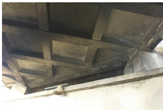
Widok od spodu na pomost w rejonie oparcia konstrukcji przęsła na przyczółku od strony Oksywia
