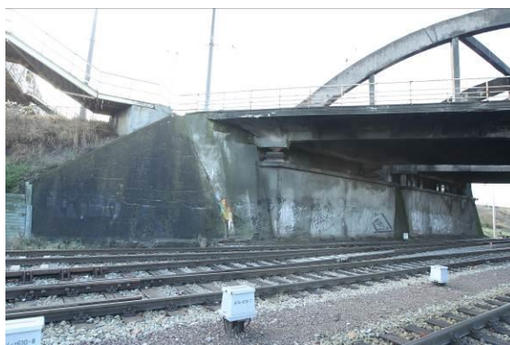
Widok ogólny przyczółka od strony Śródmieścia
