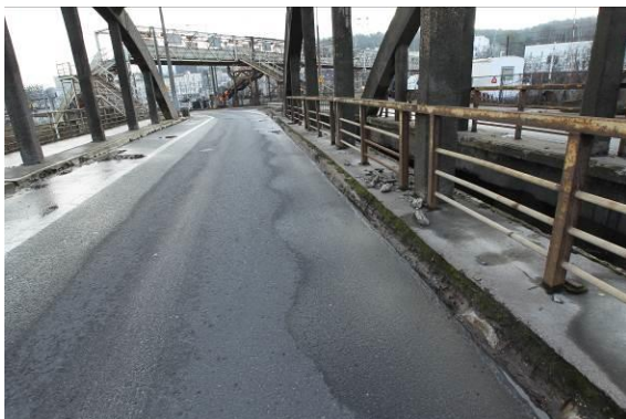
Szczegół nawierzchni bitumicznej jezdni w obrębie przęsła
