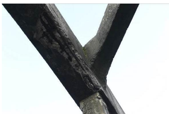
Szczegół spodu dźwigara łukowego w sąsiedztwie wieszaka W4/o5 (oś C12)
