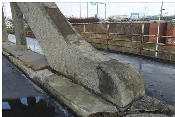
Wezłowie zew dźwigara łukowego w osi o8 – oś C1
