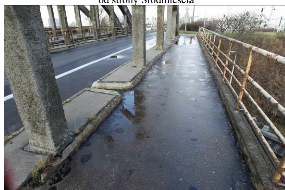
Chodnik w osi o8 na obiekcie
