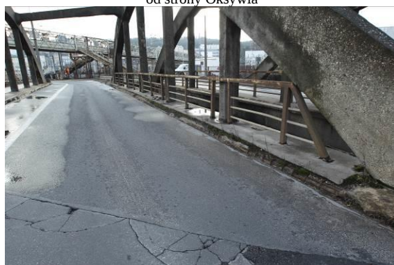
Szczegół nawierzchni bitumicznej jezdni w obrębie przęsła
