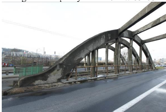
Widok wew dźwigara łukowego w osi o5 – widok od strony Śródmieścia
