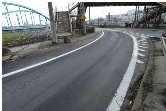
Szczegół nawierzchni bitumicznej jezdni na dojeździe do przęsła od strony Śródmieścia
