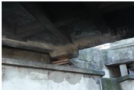
Wew łożysko na przyczółku od strony Śródmieścia
