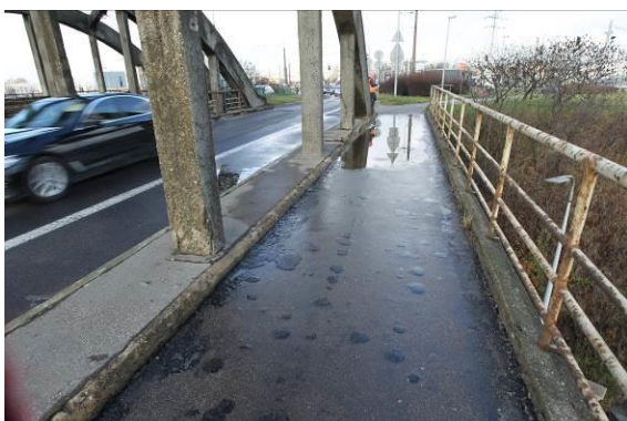
Chodnik w osi o8 na obiekcie
