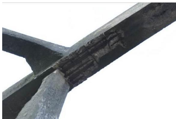
Szczegół spodu dźwigara łukowego w sąsiedztwie wieszaka W2/o5 (oś C8)
