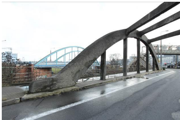
Widok zew dźwigara łukowego w osi o5 – widok od strony Oksywi
