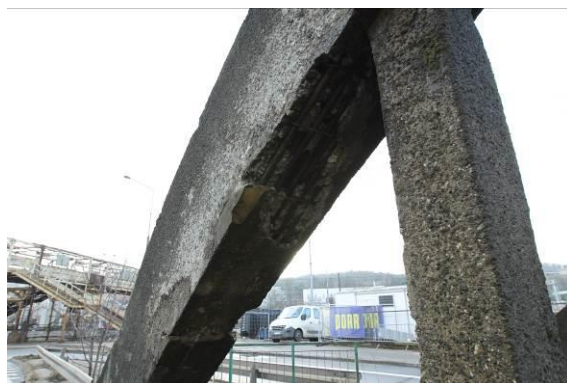
Szczegół spodu dźwigara łukowego w obrębie od wezłowania do wieszaka W1/o5 (oś C6)
