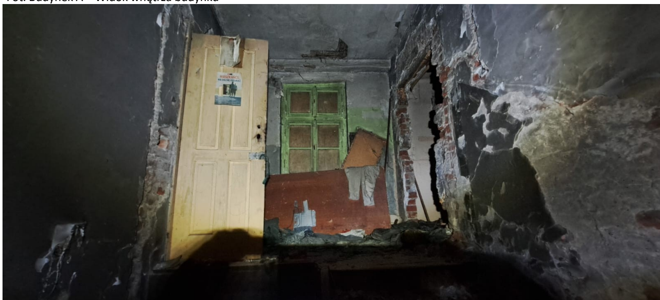
Fot. Budynek A – Widok wnętrza budynku
