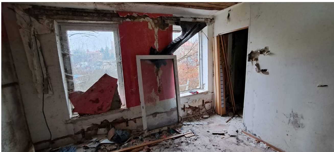
Fot. Budynek B – Widok wnętrza budynku
