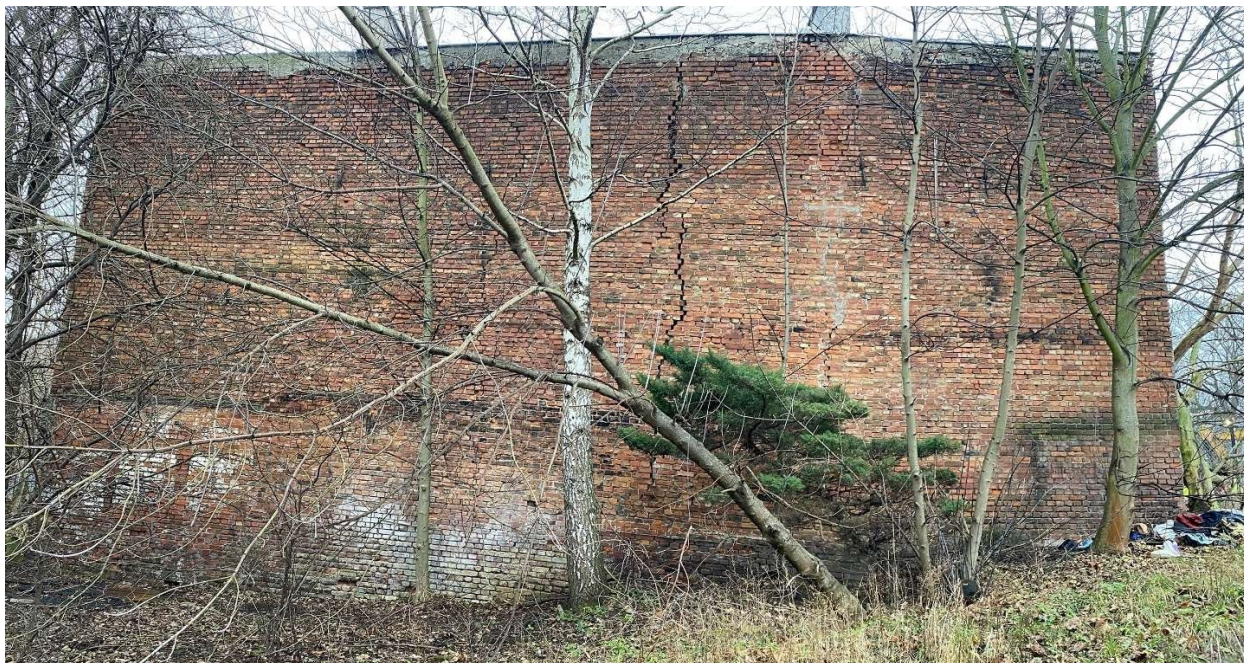
Fot. Budynek A od strony zachodniej
