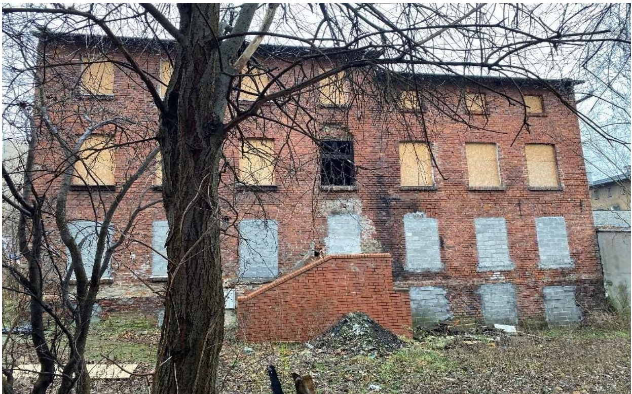
Fot. Budynek B od strony wschodniej
