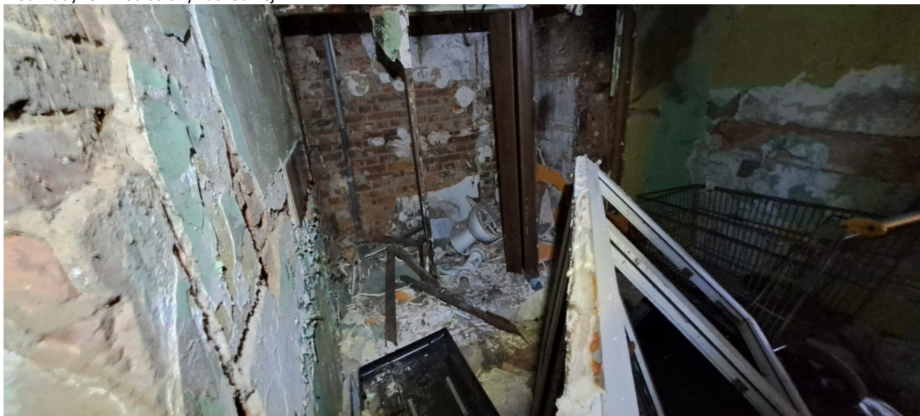
Fot. Budynek B – Widok wnętrza budynku
