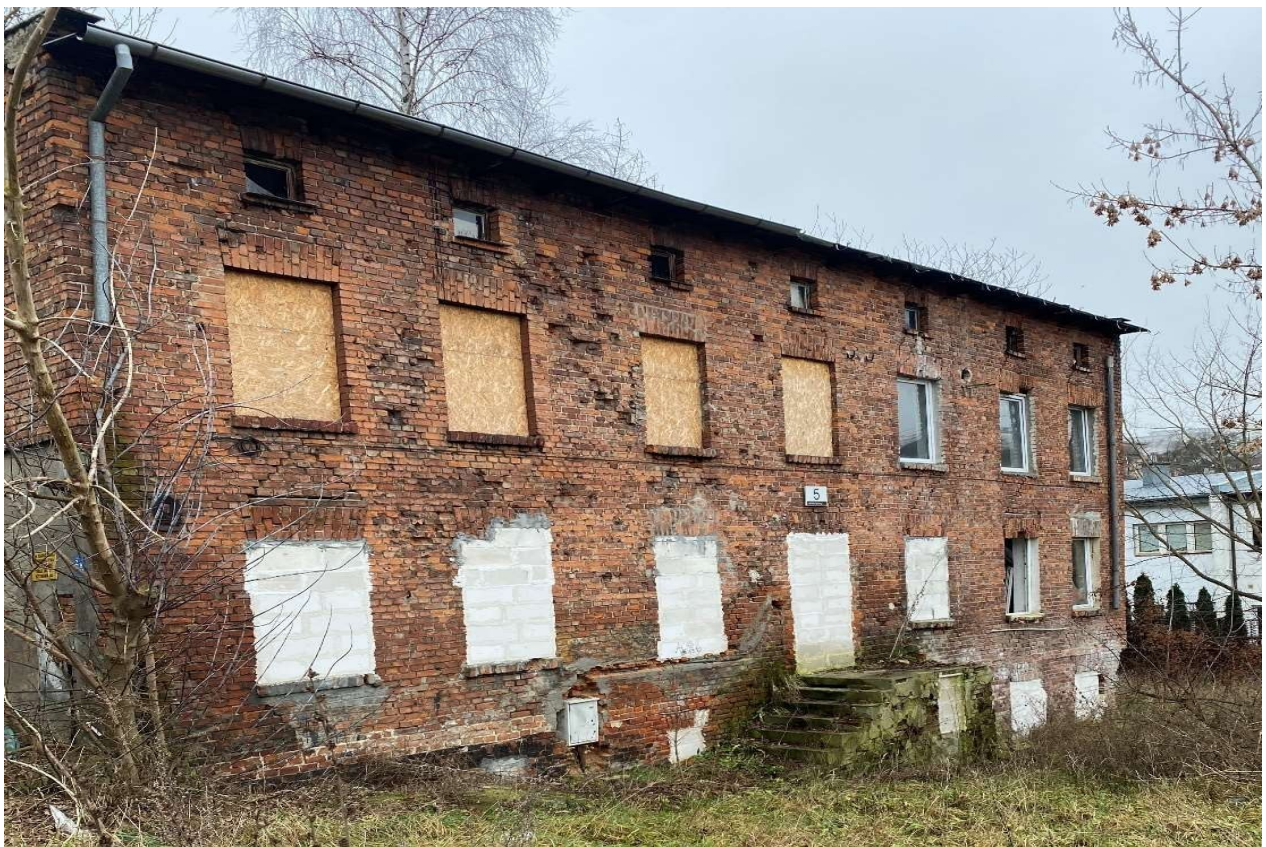
Fot. Budynek A od strony wschodniej
