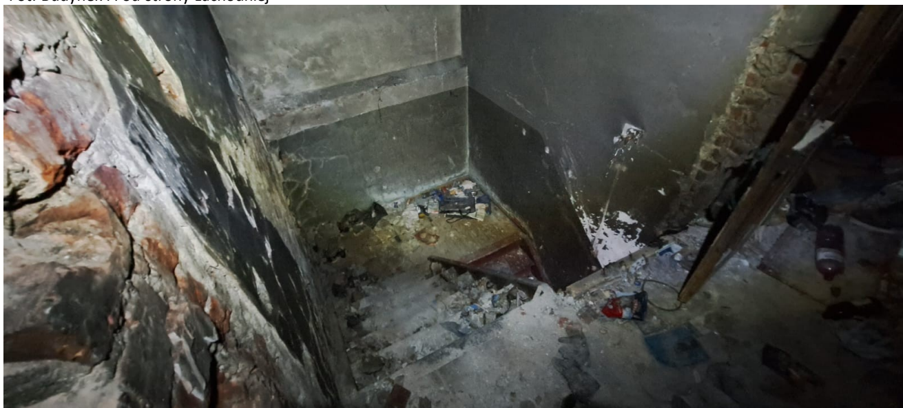
Fot. Budynek A – Widok wnętrza budynku
