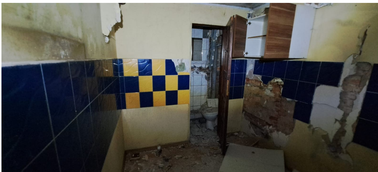
Fot. Budynek A – Widok wnętrza budynku
