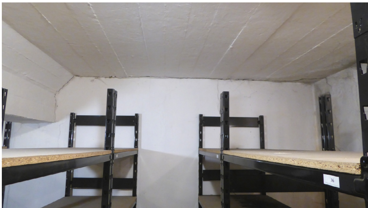
Rys. Z1-13. Zarysowanie na styku stropu i ściany zewnętrznej
