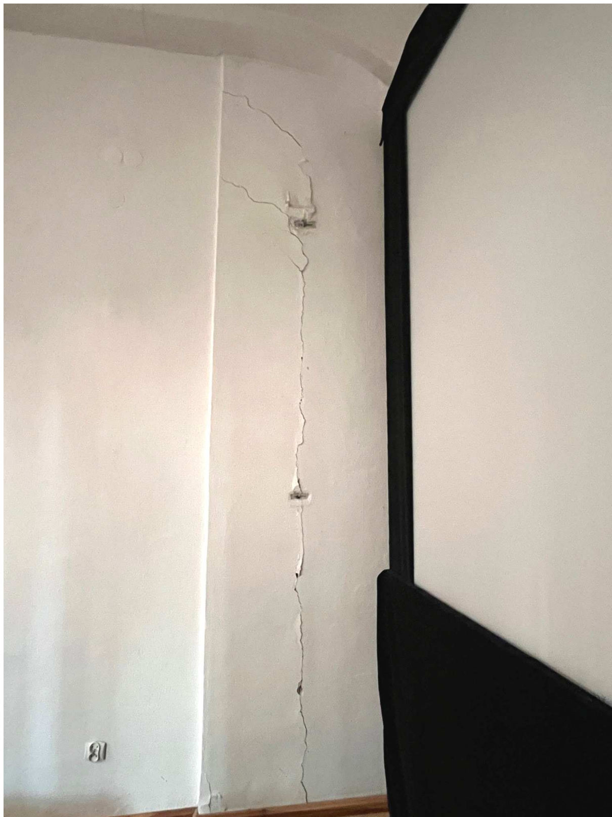
Rys. 56. I p. w Galerii Oko Ucho - widoczne zarysowanie na całą wysokość filarka murowego
