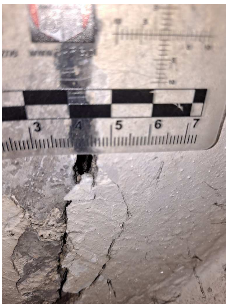
Rys. 22. Pomiar rozwartości zarysowania – 5 mm
