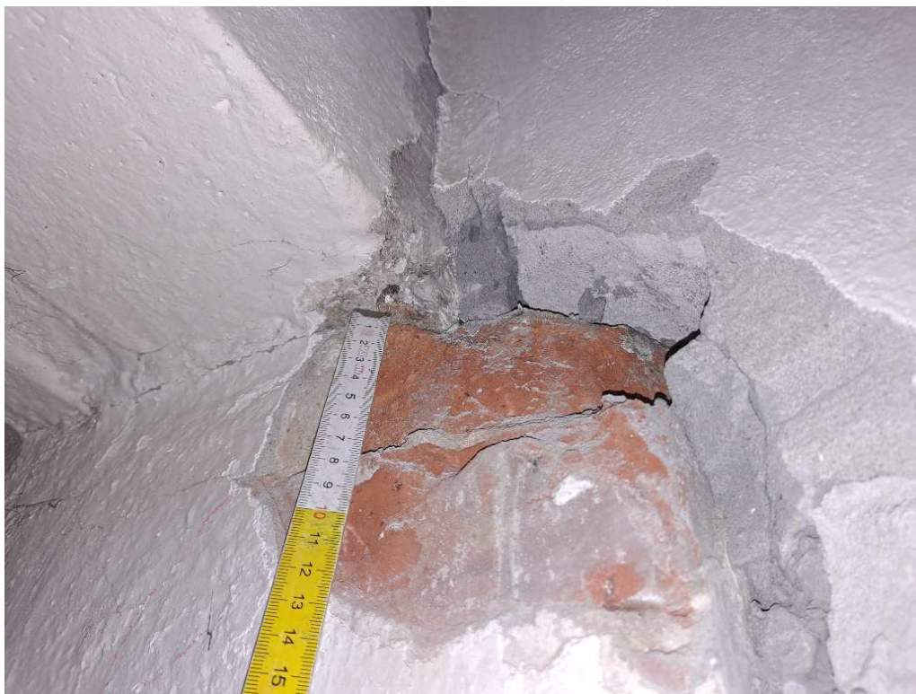
Rys. 27. Odkrywka w celu weryfikacji oparcia belki żelbetowej
