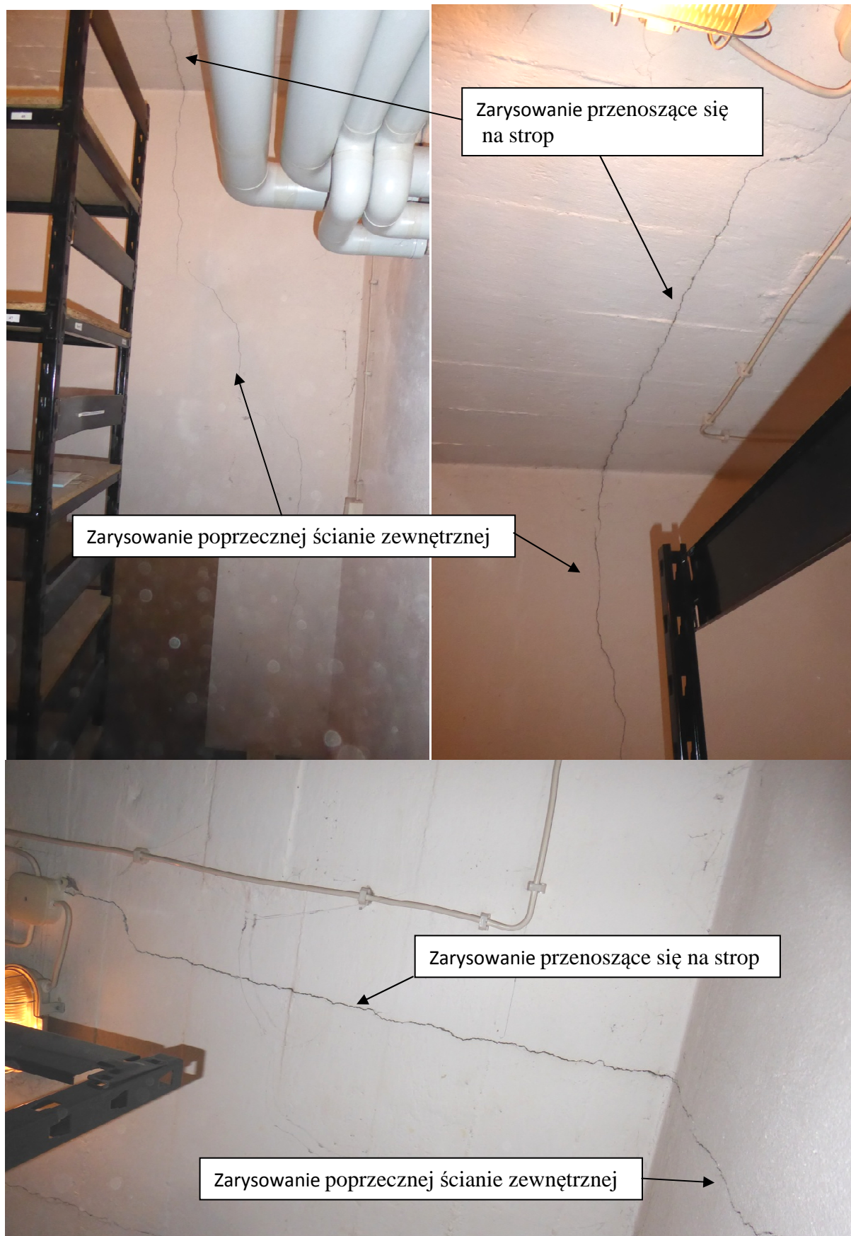
Rys. Z1-4-Z1-6. Zarysowanie na poprzecznej ścianie zewnętrznej przenoszące się na strop w poprzek jego rozpiętości
