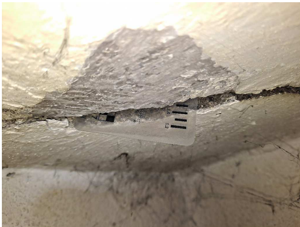
Rys. 23. Głębokość szczeliny w stropie - >8\text{cm}
