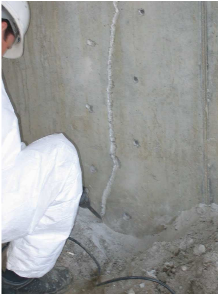
Rys. 67. Rozbuzdowanie rysy
