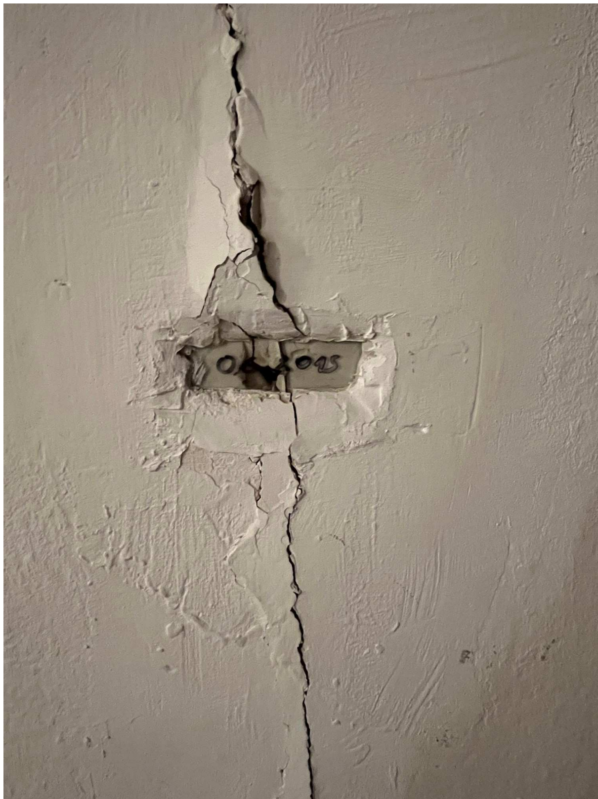
Rys. 57. I p. w Galerii Oko Ucho - widoczne pęknięcie kontrolnej opaski szklanej na filarku murowym
