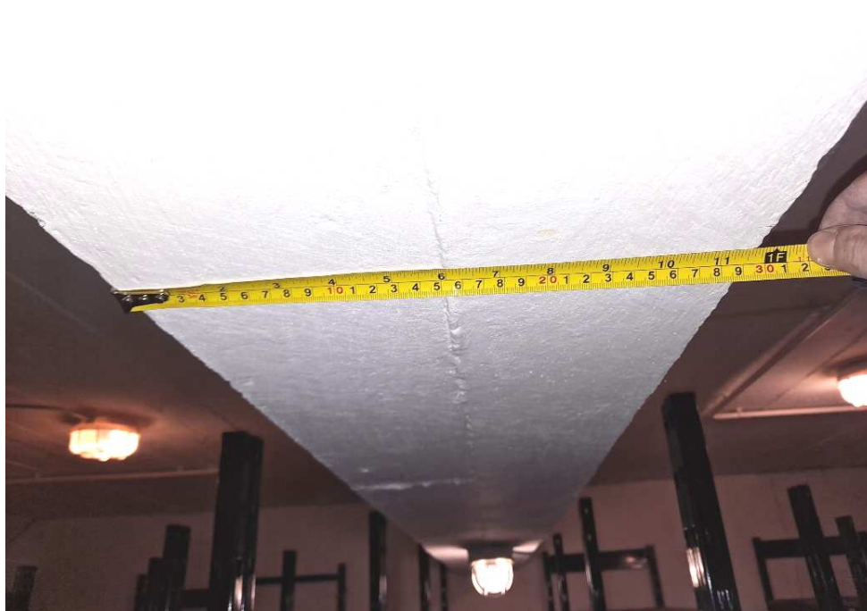
Rys. 25. Pomiar szerokości belki skrajnej – 29 cm
