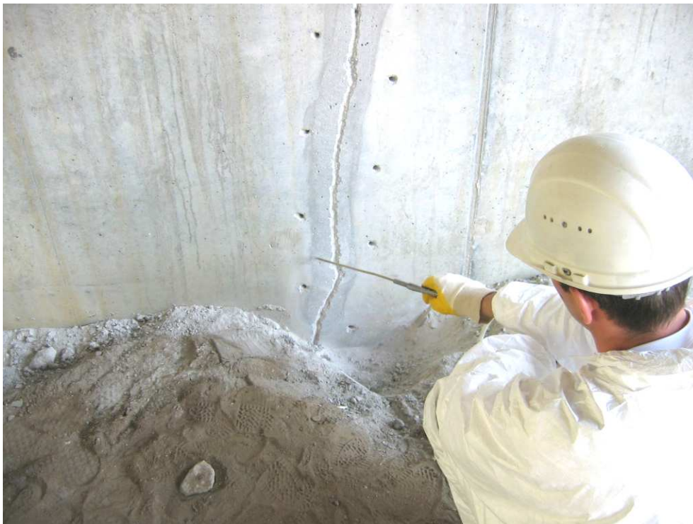
Rys. 68. Przedmuchiwanie otworów podawczych sprężonym powietrzem
