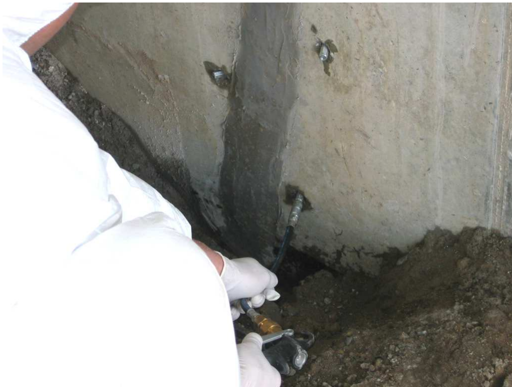
Rys. 70. Montaż pakierów podawczych
