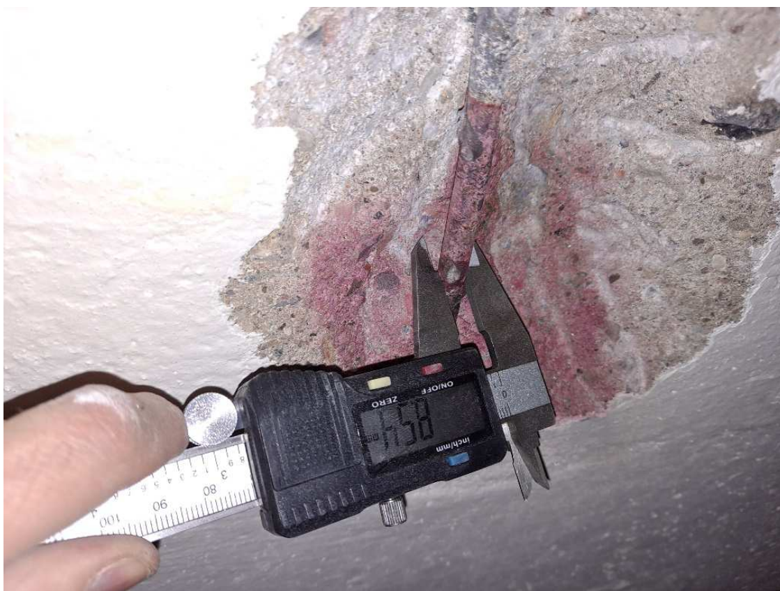
Rys. 52. Pomiar średnicy zbrojenia w płycie – \Phi 8 mm
