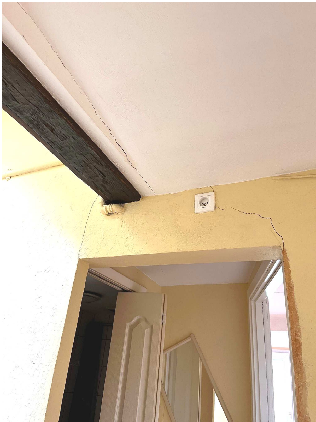
Rys. 62. Rzut III p. - występujące zarysowania w lokalu nr 25/26
