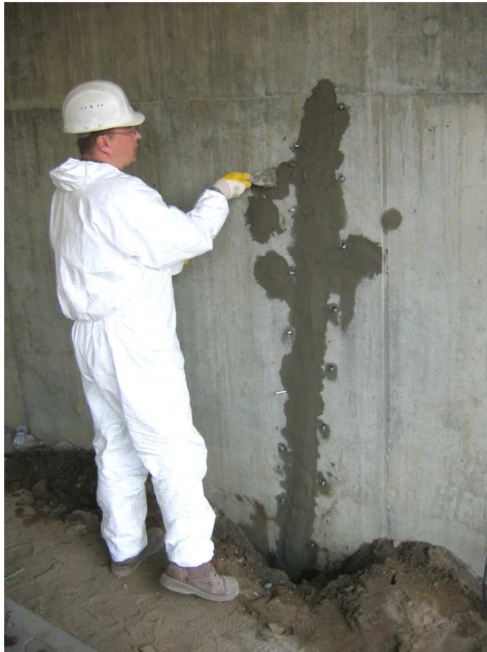
Rys. 69. Zamykanie bruzd przed iniekcją i otworów po iniekcji
