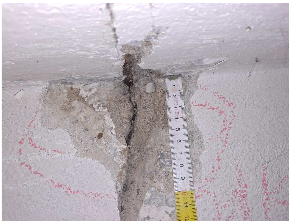
Rys. 28. Odkrywka w celu weryfikacji oparcia płyty stropowej na połączeniu ze ścianą zewnętrzną
