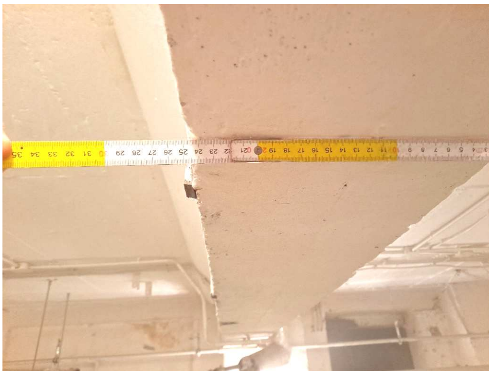
Rys. 24. Pomiar szerokości belki środkowej – 24,5 cm
