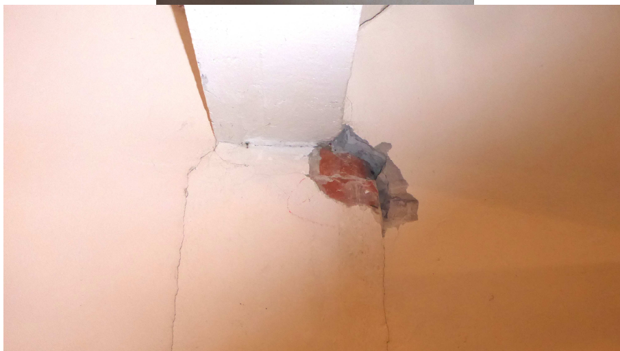
Rys. 14, 15. Odkrywka w strefie podparcia żebra na filarku nośnym
