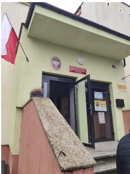
Zdj. 10 Uszkodzone płyty na murkach przy wejściu głównym, przeznaczone do wymiany
