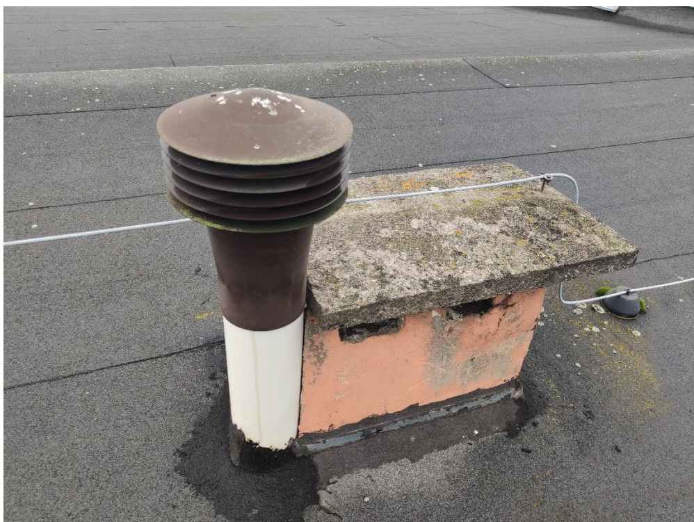
Zdj. 17 Nieszczelność przejścia kominą przez pokrycie dachowe
