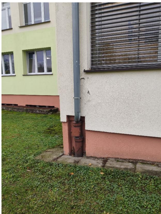
Zdj. 7 Uszkodzenie elewacji budynku - odspajający się tynk
