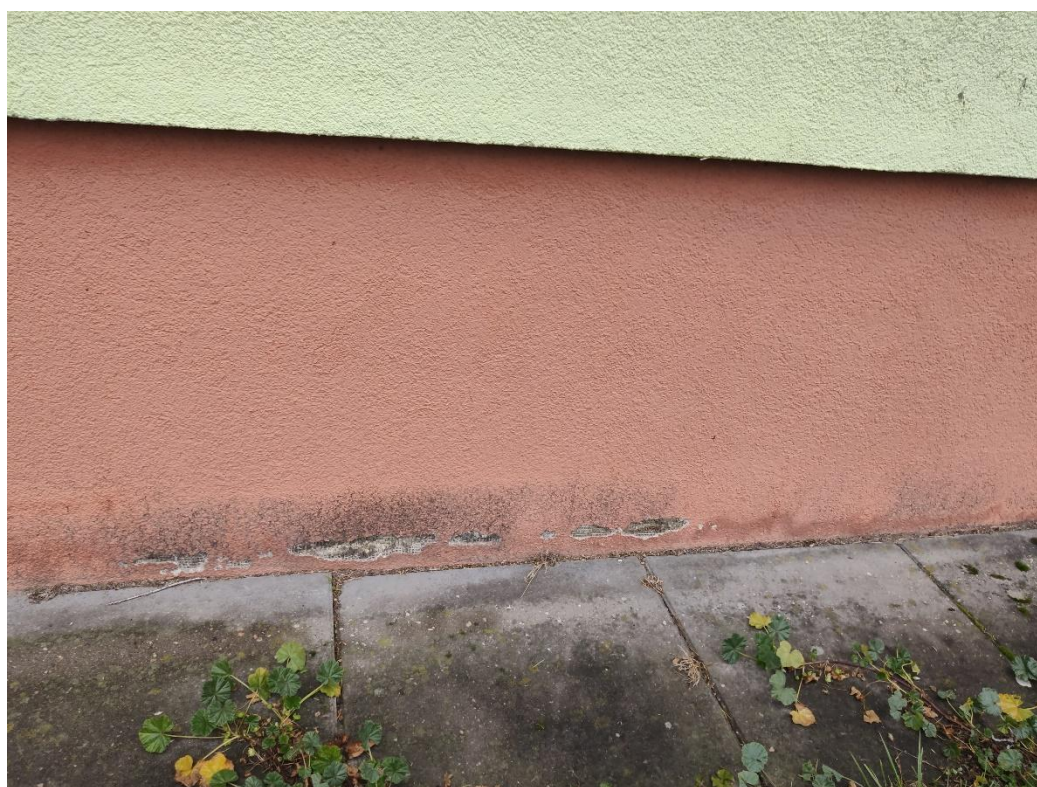
Zdj. 2 Uszkodzony cokół budynku
