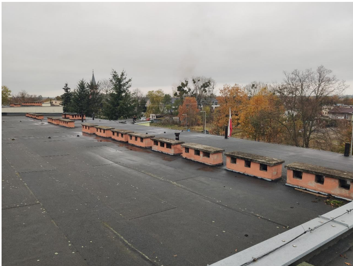
Zdj. 13 Brak wyprofilowanych spadków pokrycia przy kominkach wentylacyjnych
