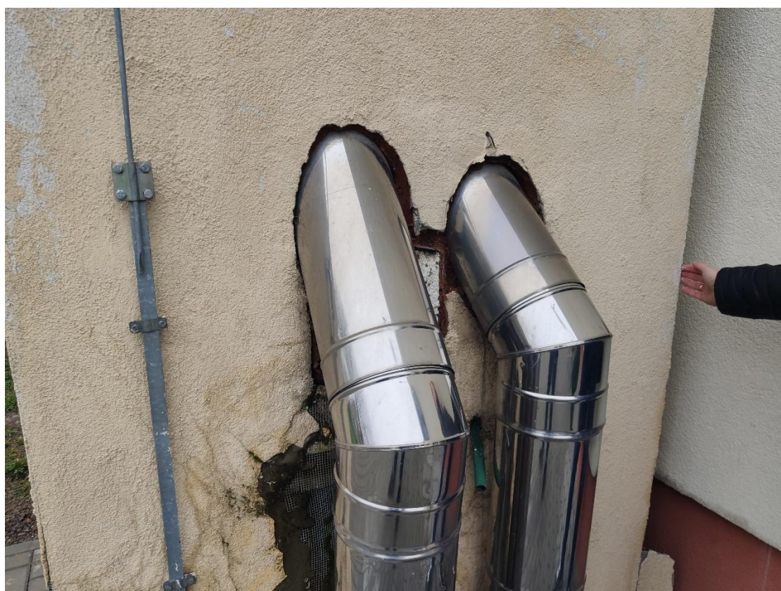
Zdj. 12 Odsypająca się od komina warstwa izolacji termicznej
