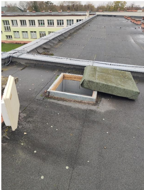
Zdj. 14 Wyłaz dachowy przeznaczony do wymiany
