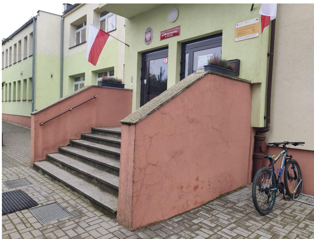
Zdj. 9 Odspajająca się warstwa izolacji od murków przy wejściu głównym do budynku
