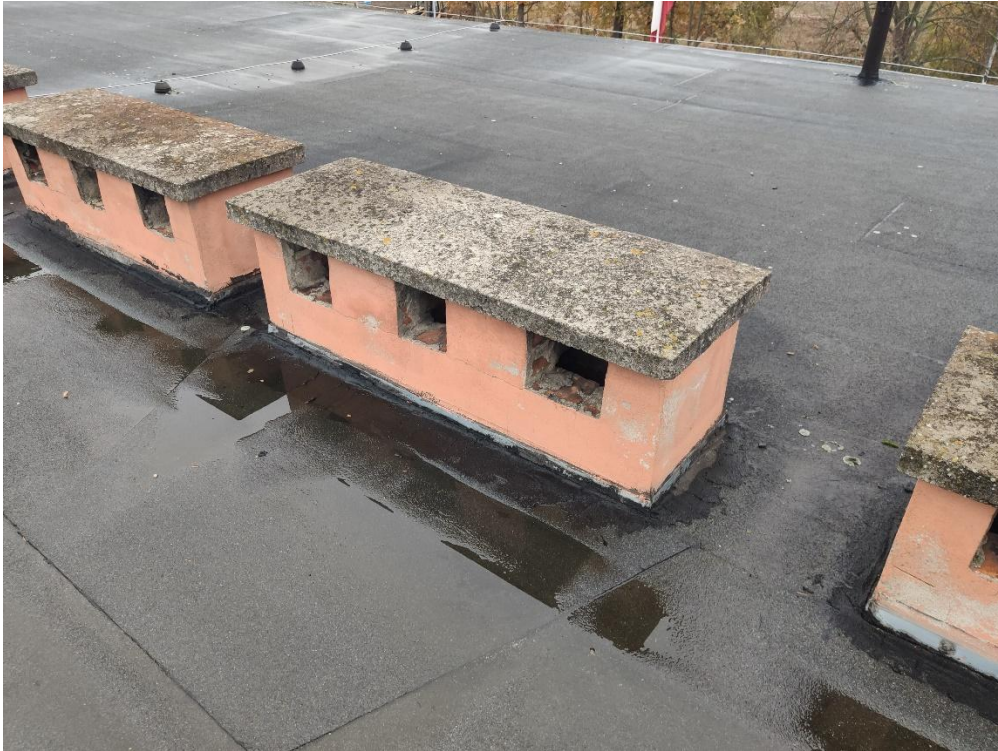
Zdj. 16 Brak wyprofilowanego spadku połaci dachowej, nieszczelność przy kominie wentylacyjnym
