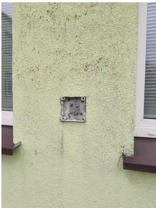
Zdj. 3 Uszkodzona puszka złącza kontrolnego instalacji odgromowej
