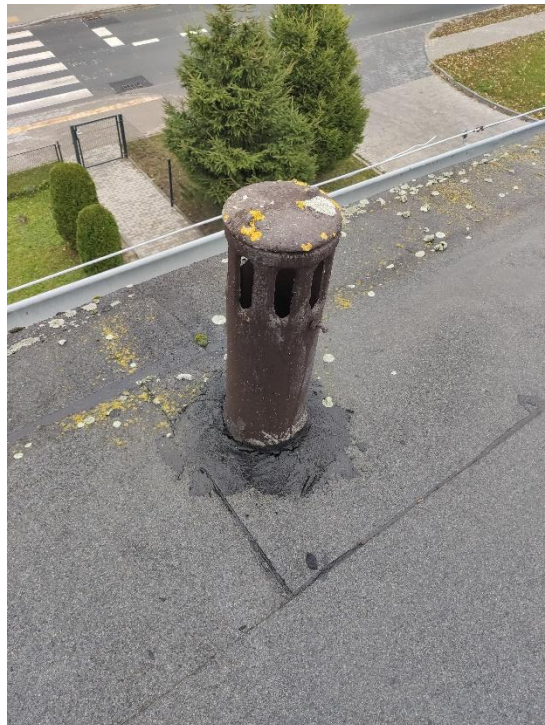
Zdj. 15 Nieszczelność przejścia kominka wentylacyjnego przez pokrycie dachowe
