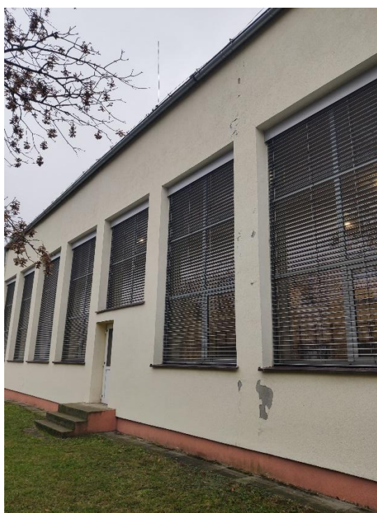
Zdj. 6 Uszkodzenie elewacji wynikające z przecieku/nieszczelności dachu
