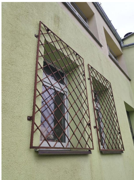
Zdj. 11 Uszkodzona powłoka malarska krat okiennych
