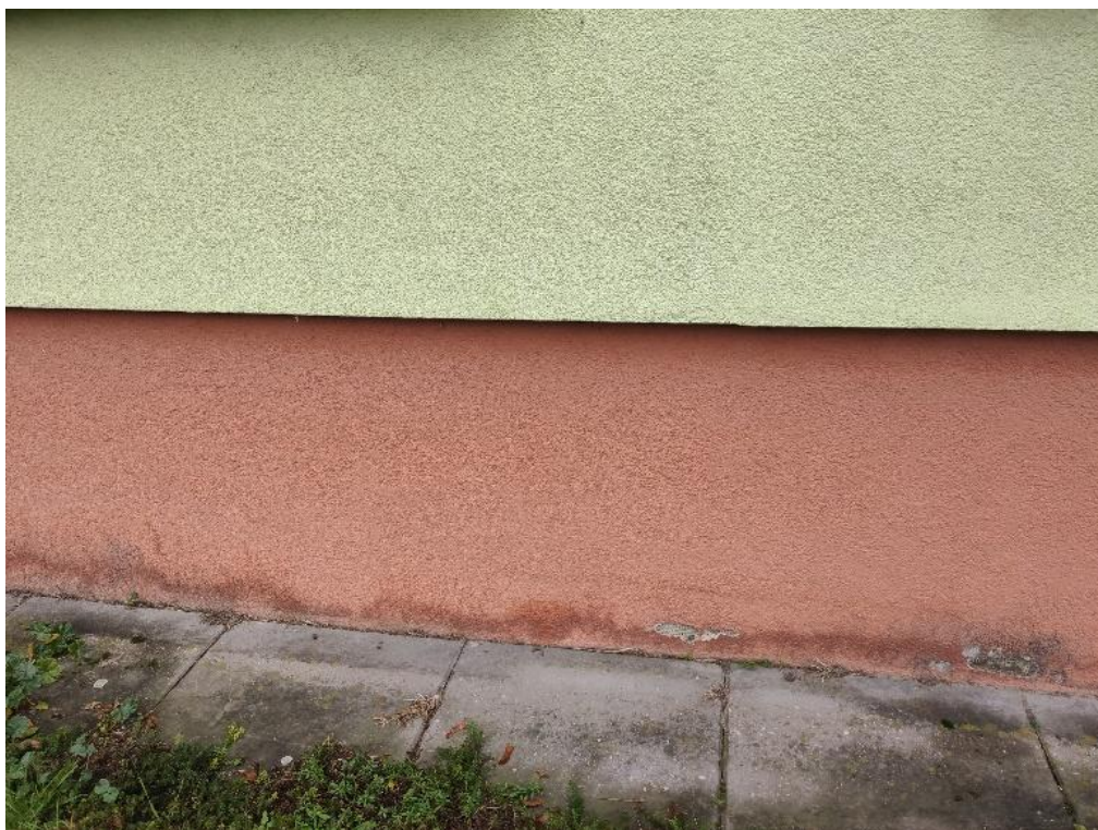
Zdj. 1 Uszkodzony cokół budynku
