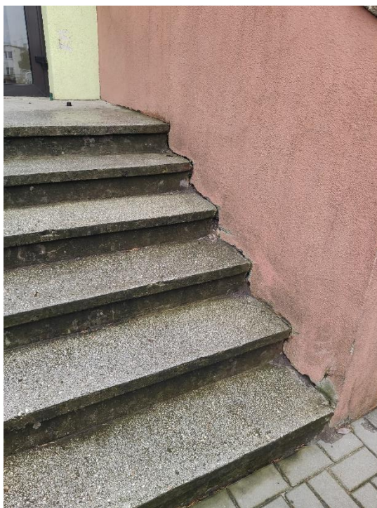
Zdj. 8 Odspajająca się warstwa izolacji od murków przy wejściu głównym do budynku
