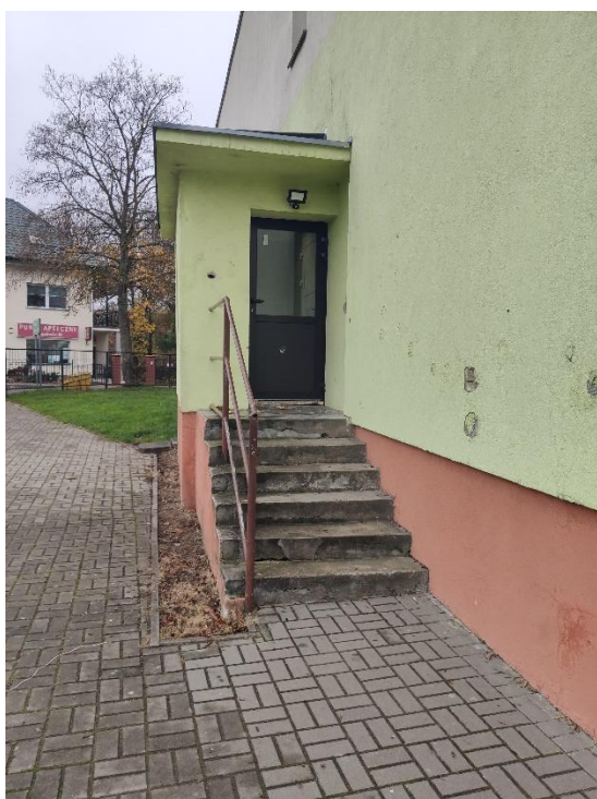
Zdj. 5 Uszkodzone schody, dojście do budynku
