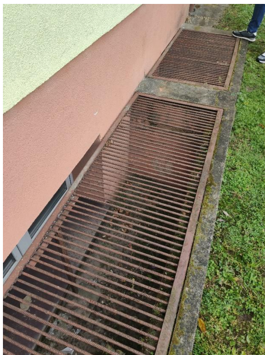
Zdj. 4 Uszkodzone murki betonowe studni doświetlających
