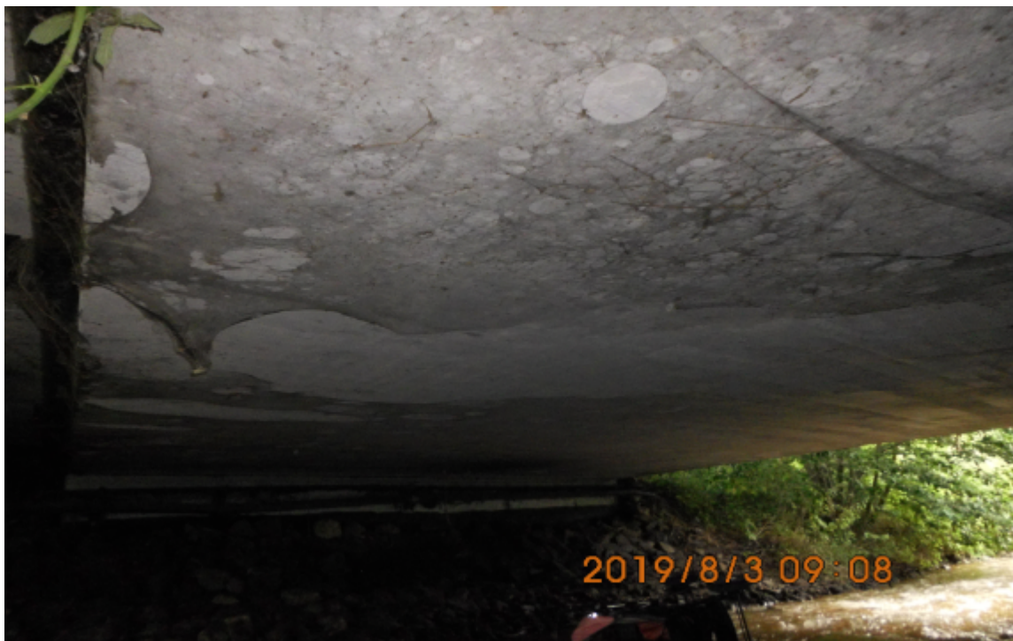
Zdjęcie 3.11 : Widok płyty od spodu mostu
