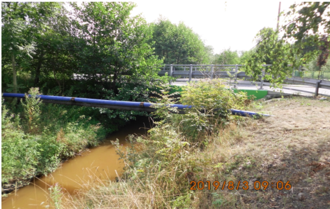
Zdjęcie nr 3.3: Widok mostu od strony zachodniej
