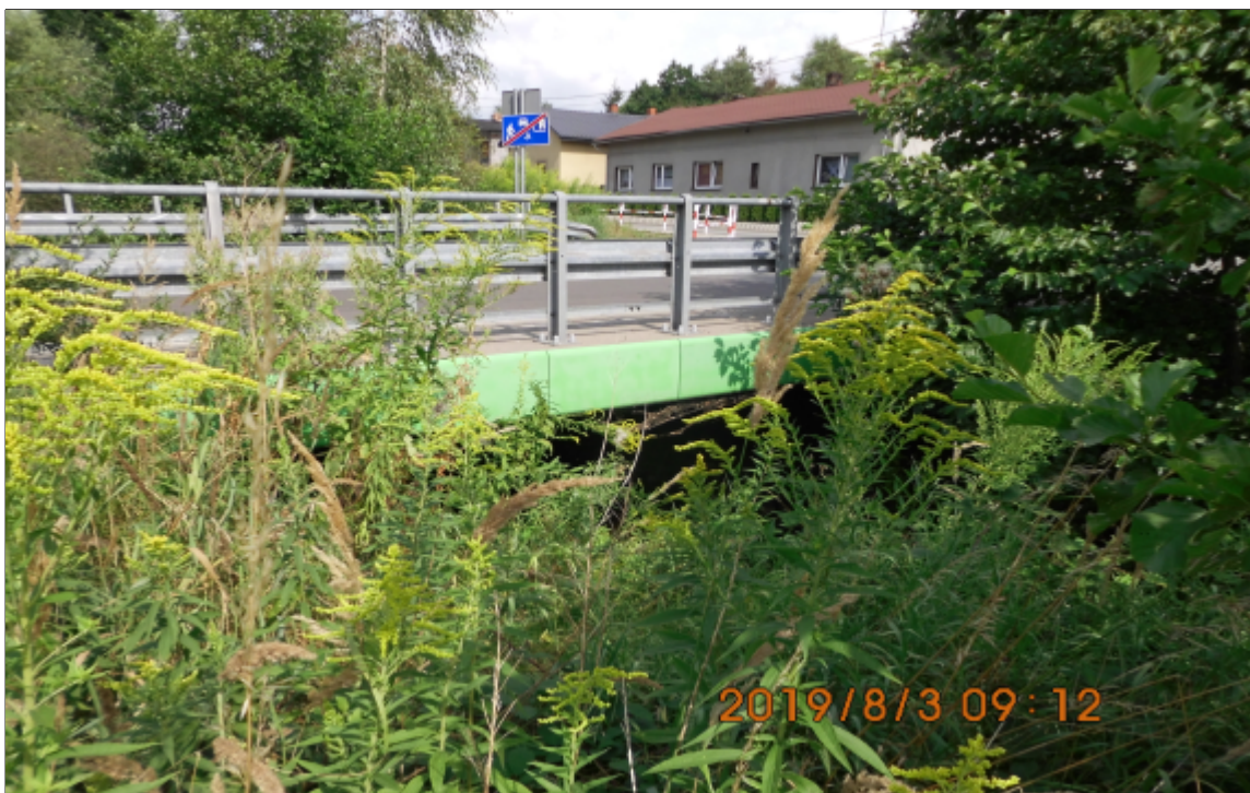
Zdjęcie nr 3.4 : Widok drogi na moście od strony wschodniej
