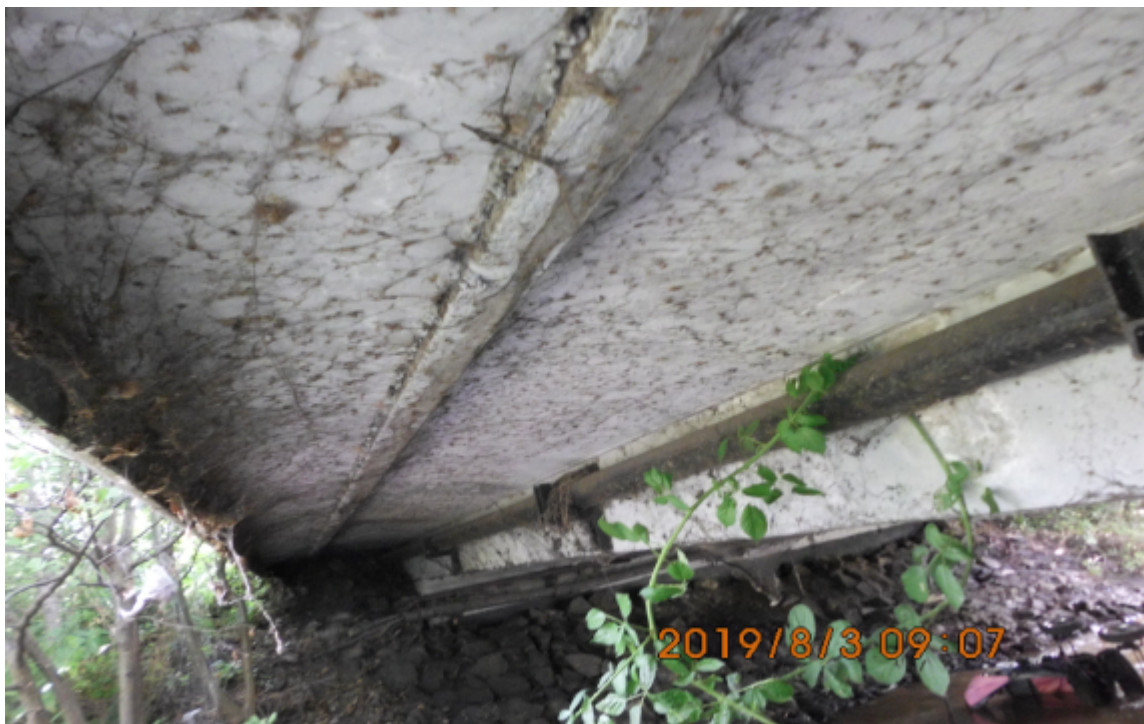
Zdjęcie 3.10 : Widok poszerzonego wspornika podchodnikowego od spodu mostu
