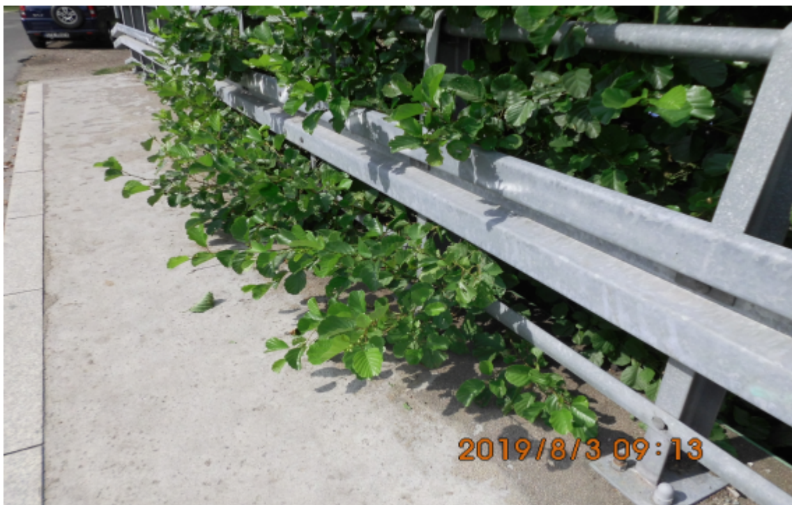
Zdjęcie nr 3.7 : Balustrada wraz z poręczą sprężystą
