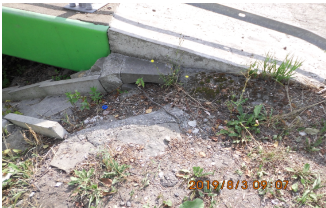
Zdjęcie nr 3.6 : Odpływ wody z powierzchni mostowej do ścieku skarpowego
