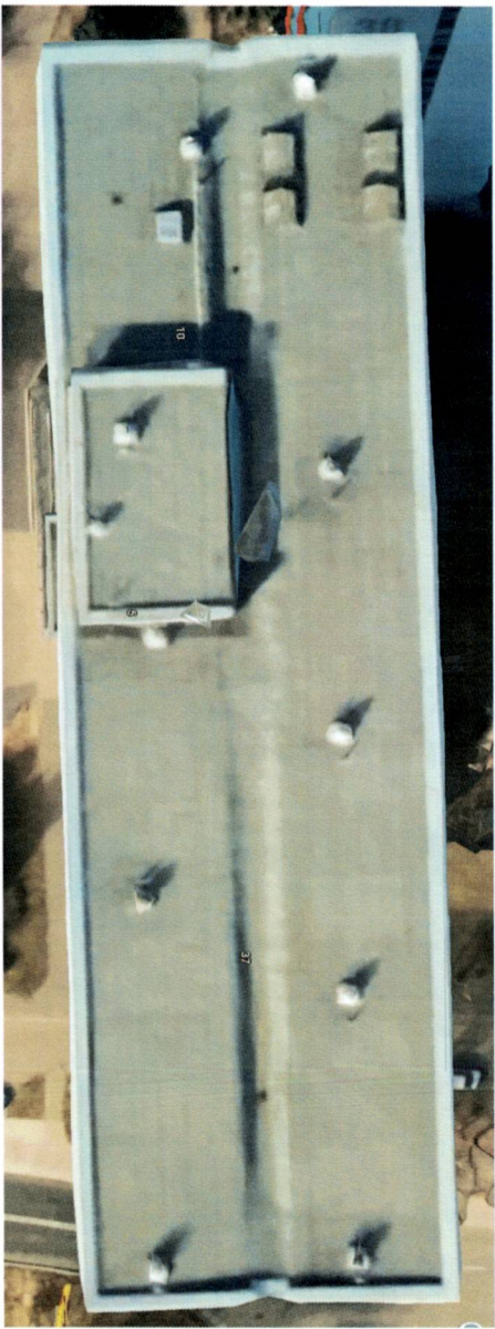
Zdj. 2 – Widok dachu budynku z góry
