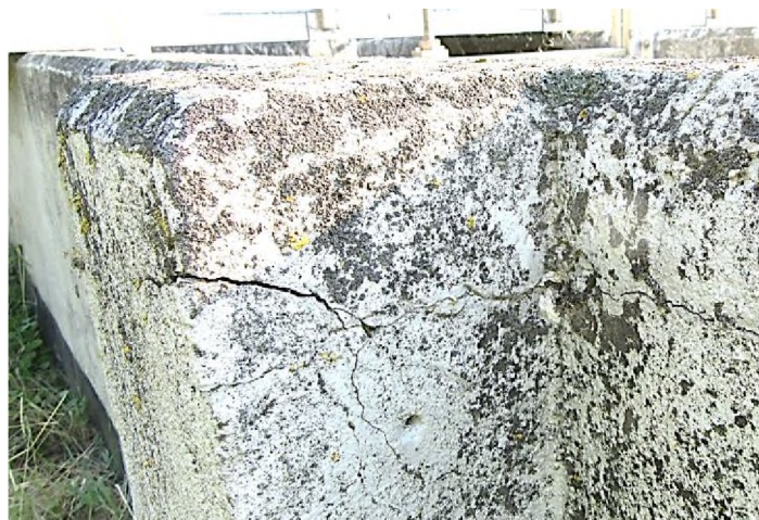
Fot.3 Pęknięcia otuliny betonu w strefach korony
