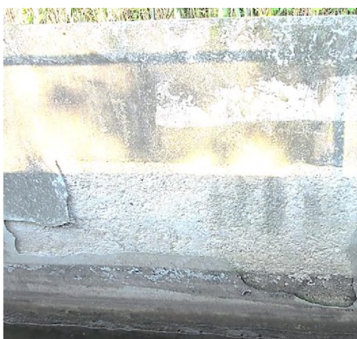
Fot. 2 Złuszczenia powłok naprawczych (wyrównujących) i ochronnych – powierzchnia wewnętrzna
