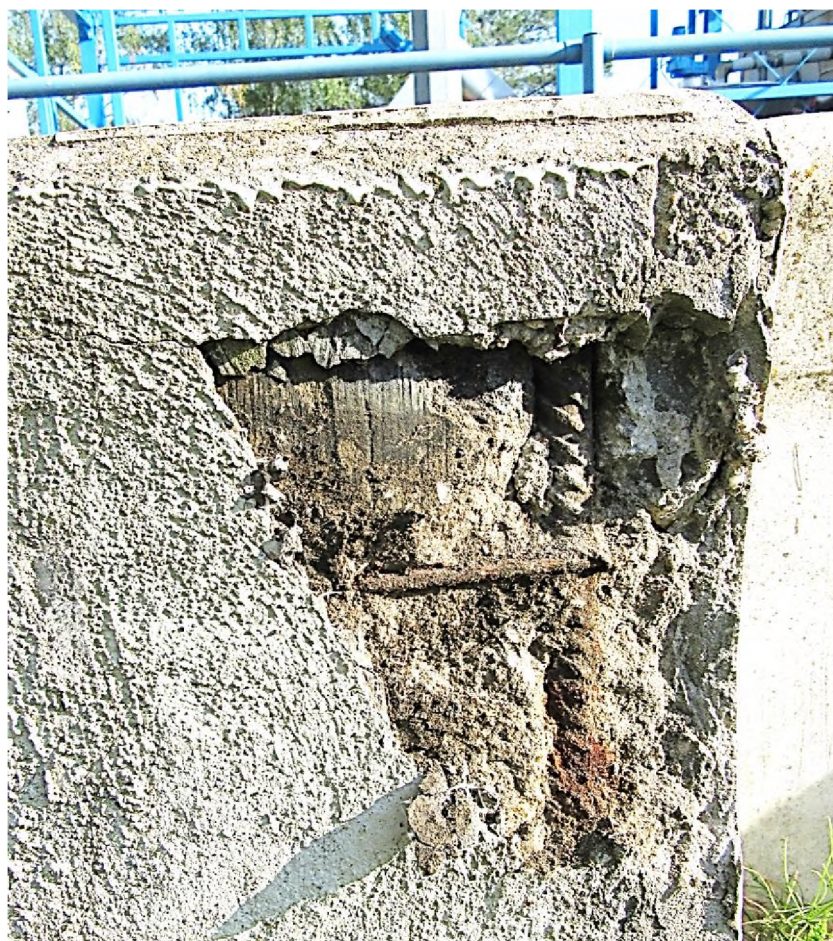
Fot. 5 Odspojenia otuliny i warstw naprawczych. Widoczne wady betonowania.
