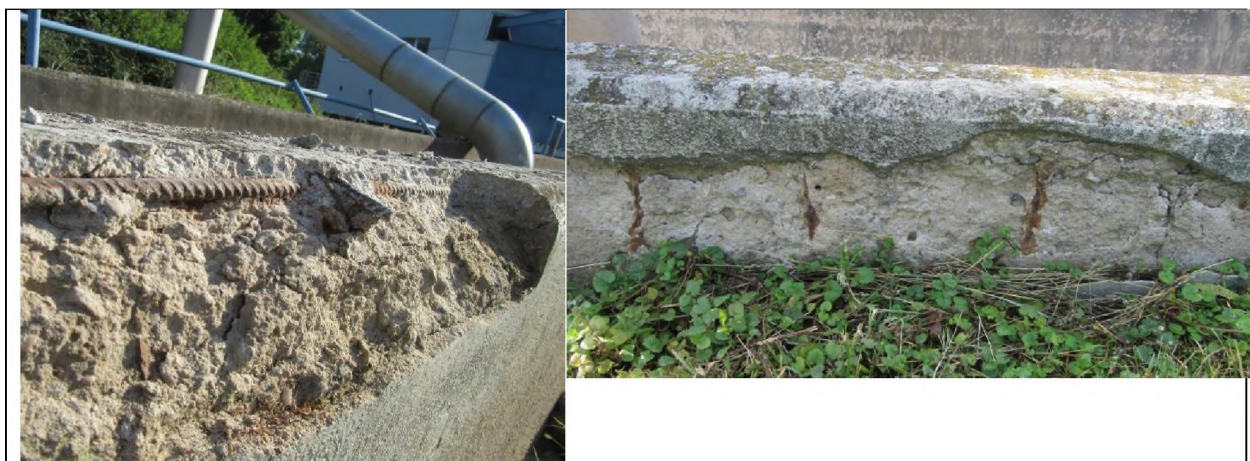
Fot. 8/9 Odspojenia otuliny, bardzo niska jakość betonu, korozja węglanowa.
