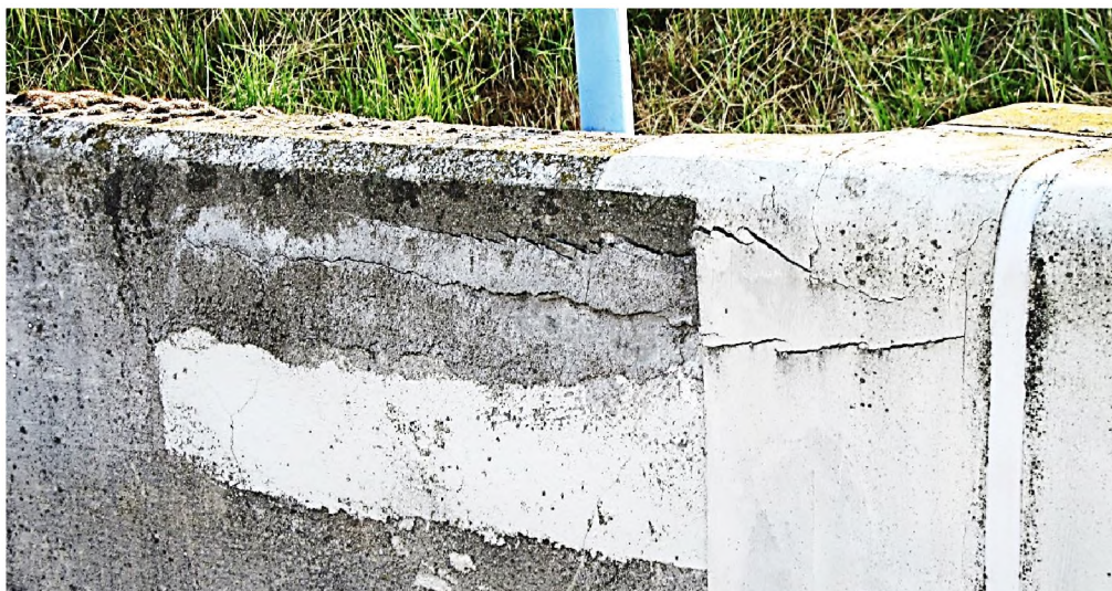
Fot.4 Spękania korony
