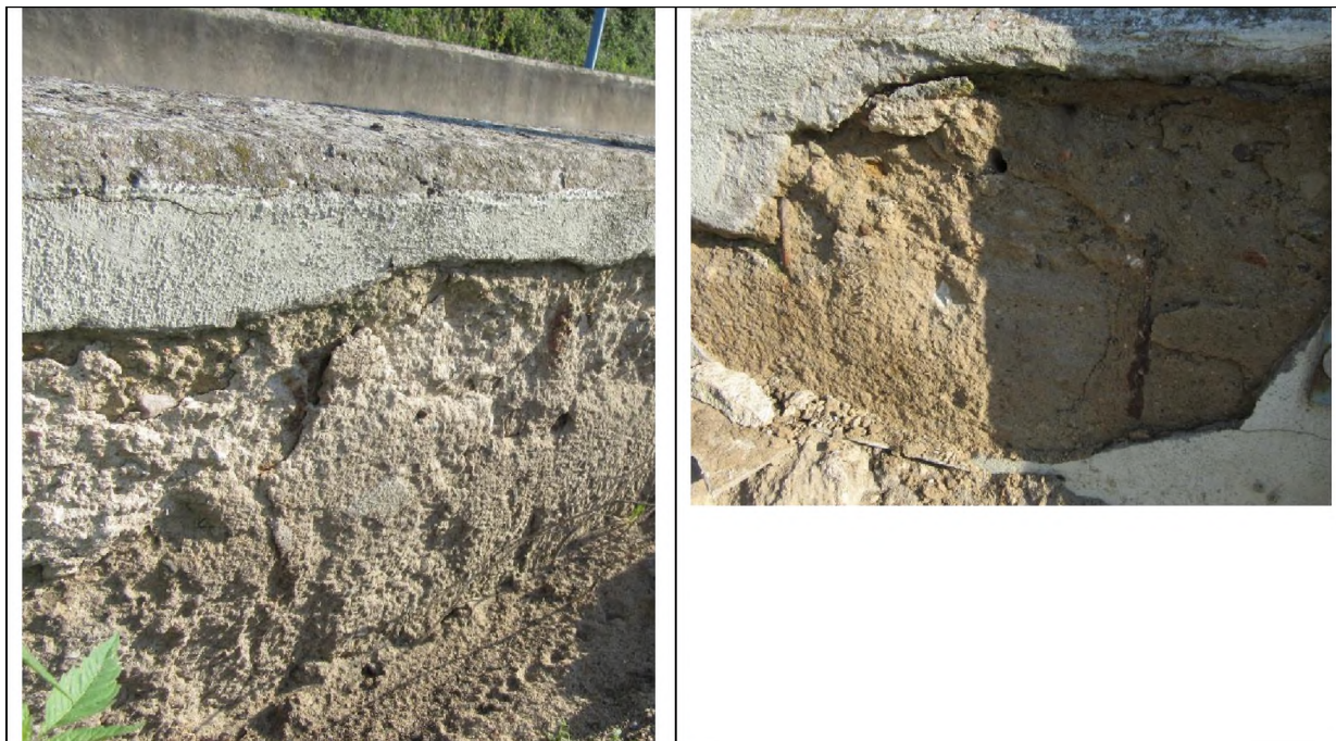
Fot. 6/7 Odspojenia otuliny, bardzo niska jakość betonu, korozja węglanowa.
