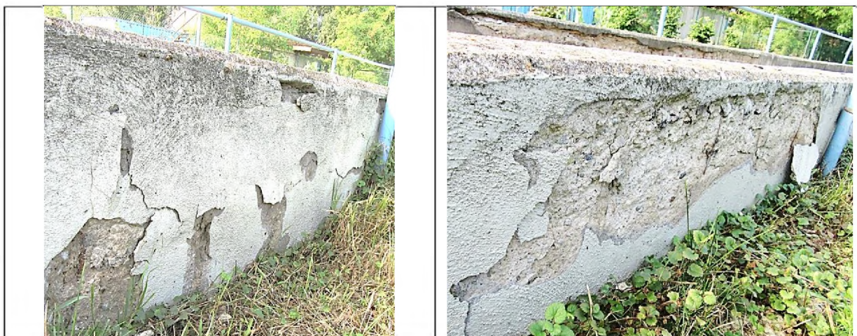
Fot. 10/11 Odspojenia otuliny, bardzo niska jakość betonu, korozja węglanowa.
