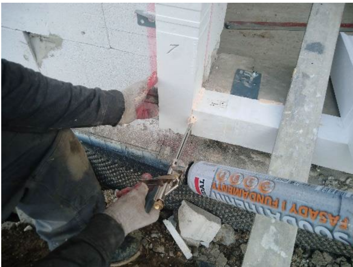
Zdjęcie nr 12 - Montaż bocznej linii CBM
