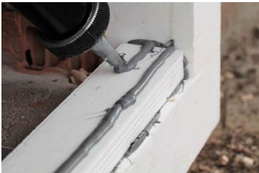
Zdjęcie nr 16– Nakładanie hybrydy na belkę BP przygotowanie do połączenia belki BP z futryną
