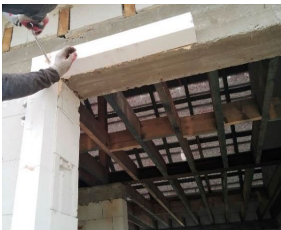
Zdjęcie nr 13 - Montaż górnej linii CBM
