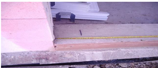
Zdjęcie nr 1 - Pomiar kontrolny otworu, naniesienie osi belek CBM
