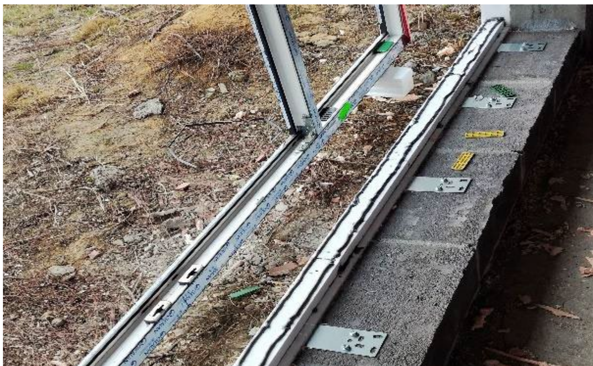
Zdjęcie nr 17 – Nakładanie ramy na belkę BP
