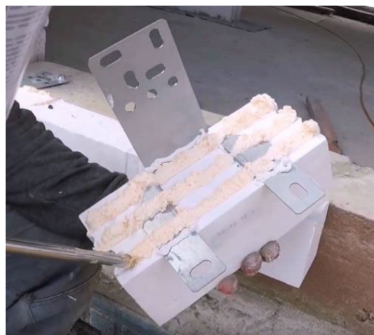
Zdjęcie nr 10 - Nałożenie kleju do styropianu PU
