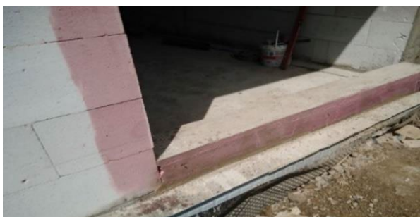
Zdjęcie nr 3 - Przygotowanie otworu – gruntowanie
