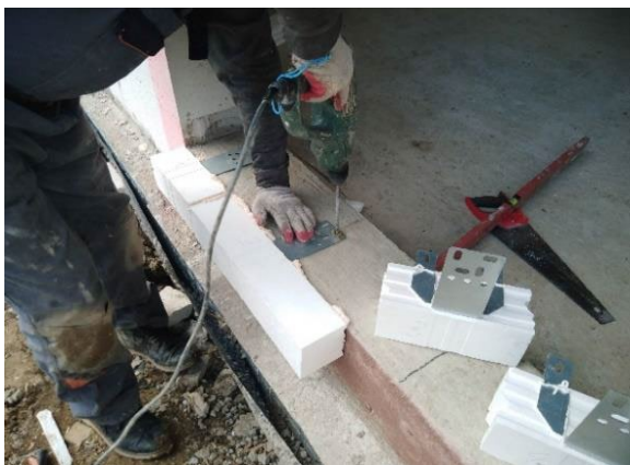
Zdjęcie nr 11 - Montaż dolnej linii CBM
