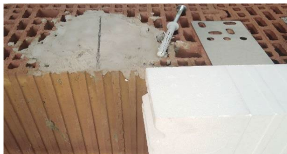
Zdjęcie nr 4 - Wzmocnienie nośności podłoża w miejscu montażu blach wsporników CBM poprzez zalanie pustaków ceramicznych zaprawą
