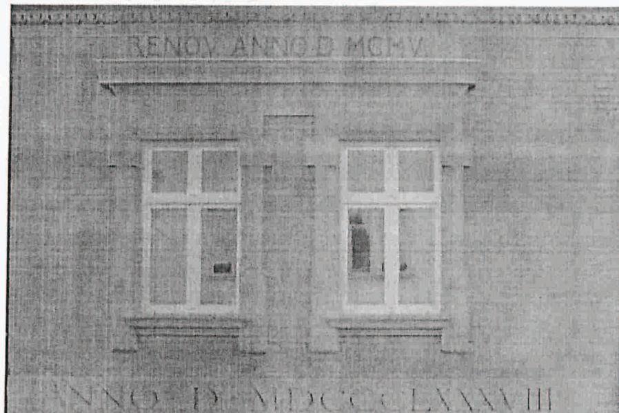
Fot. 5. Detale architektoniczne wykonane z cementu romańskiego.
