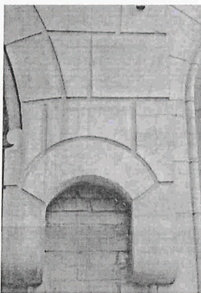
Fot. 1. Przykład tynku z cementu romańskiego o lekko spękanej powierzchni i kolorze przypominającym kamień naturalny.
