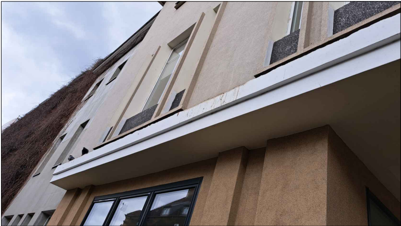
Wykonać obróbki blacharskie tytanowo– cynkowej na długości całego gzymsu
