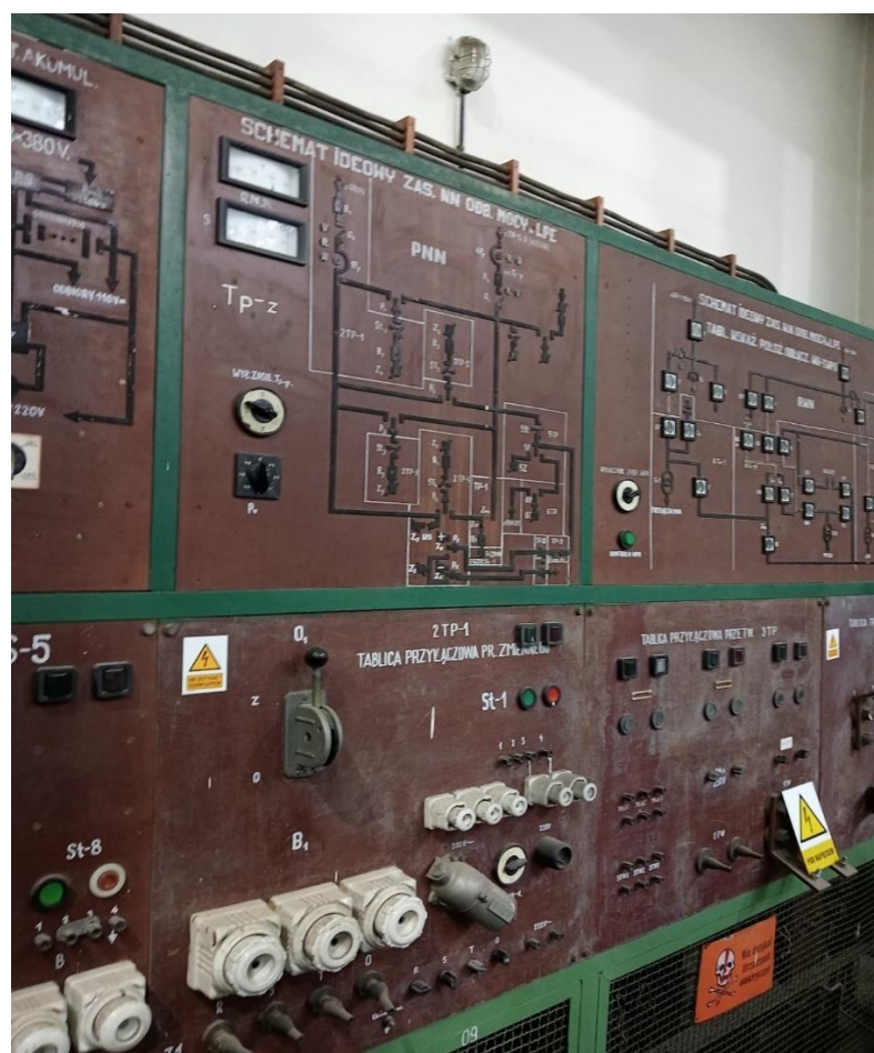
Fot. 4. Istniejąca tablica przyłączeniowa wraz z schematami ideowymi do odtworzenia.
