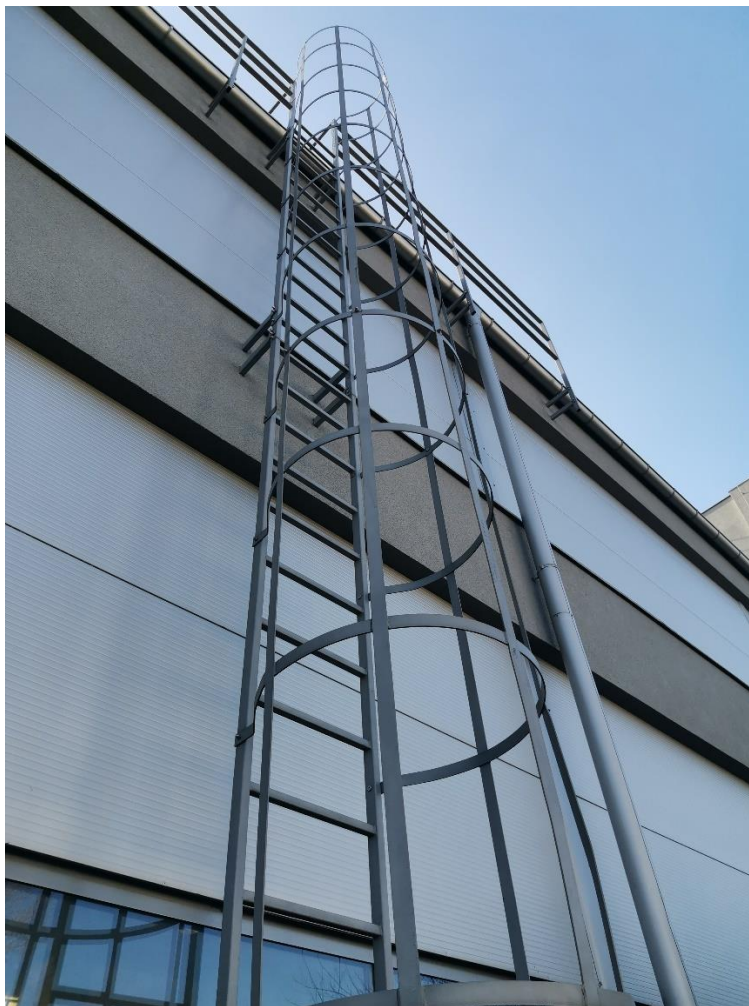
Zdj. 6 i 7 Drabiny elewacyjne od ptn. strony hali. Wysokość 8,5 m
