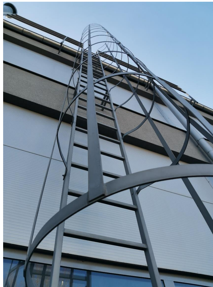
Zdj. 6 i 7 Drabiny elewacyjne od ptn. strony hali. Wysokość 8,5 m
