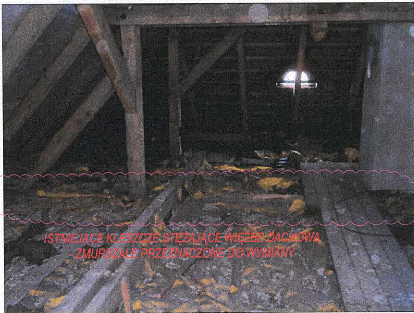
KONSTRUKCJA DACHU - STRONA ZACHODNIA
