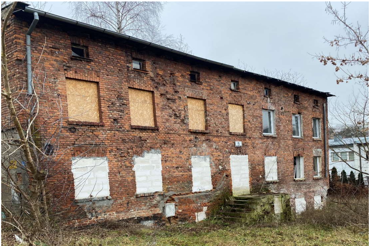
Fot. Budynek A od strony wschodniej
