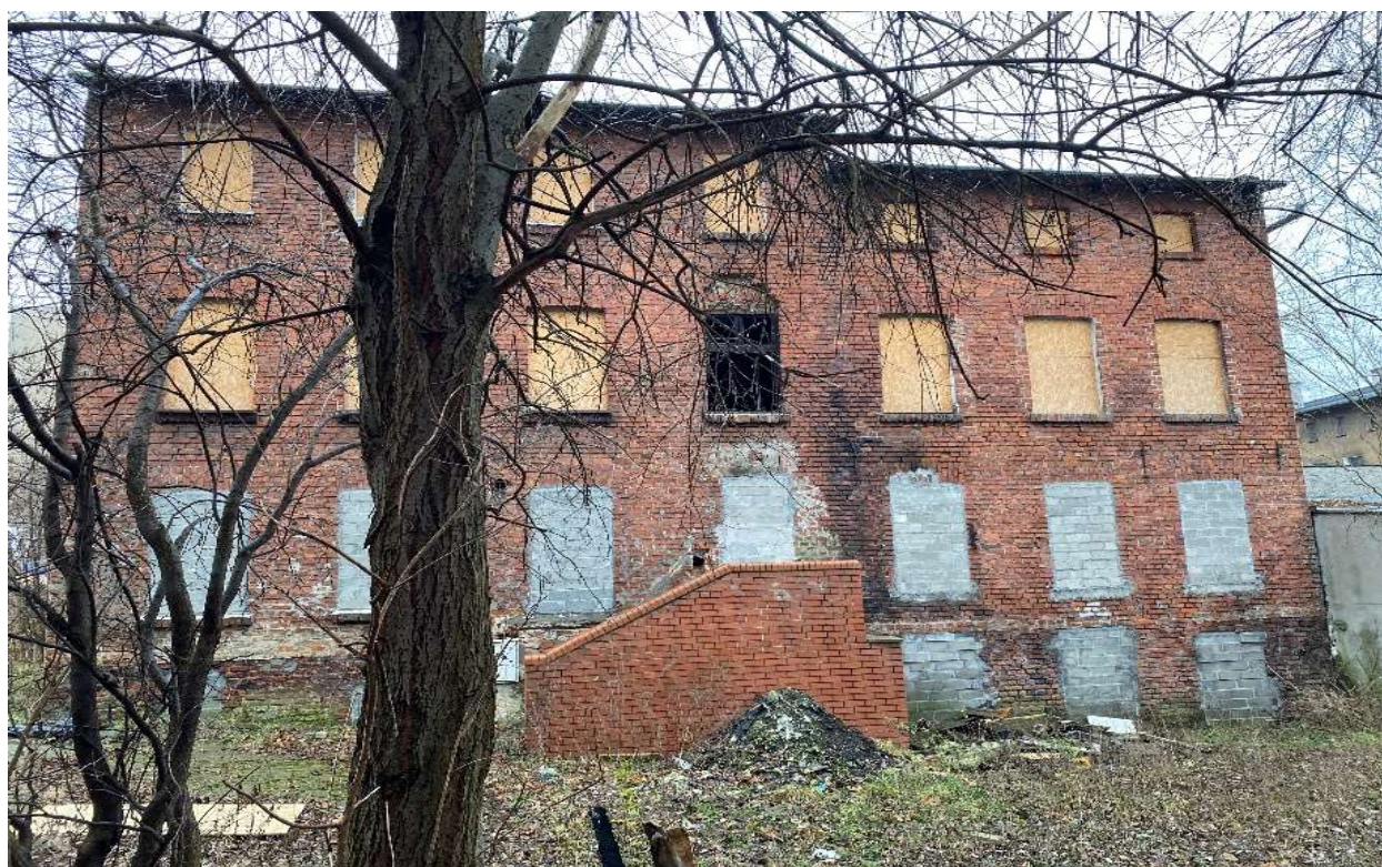
Fot. Budynek B od strony wschodniej
