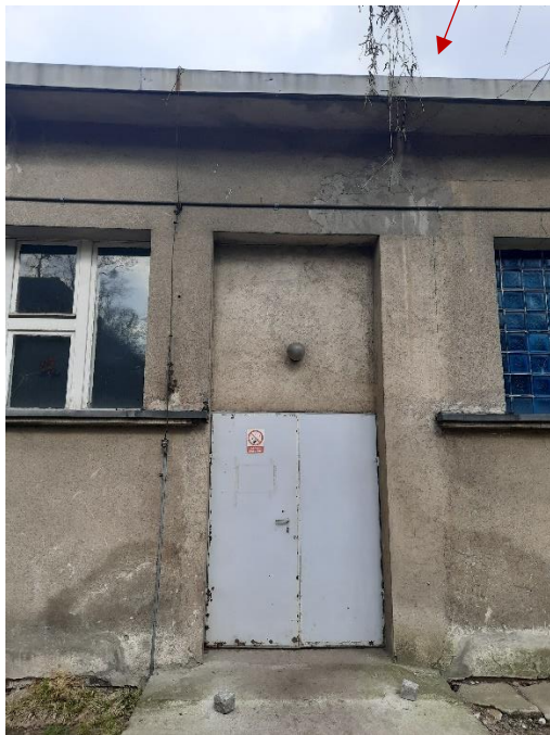
Fot. 31 Wtórnie zamurowany otwór okienny i wykonane wejście drzwiowe
