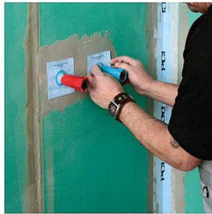
Wklejenie manszet PCI Pectape® 10 x 10 na warstwie izolacji PCI Lastogum® szary.
