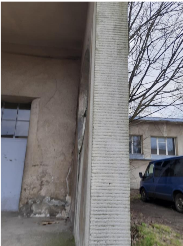
Fot. 27 Ryflowane wykończenie ściany i okapu przy podjeździe od strony północnej
