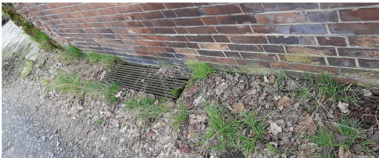
Fot. 57 Wykończenie studni w murku podjazdu
