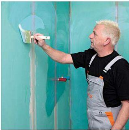
Gruntowanie nierozcieńczonym środkiem PCI Gisogrund®.
