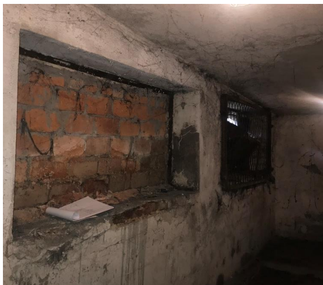
Fot. 54 Zamurowane okno piwniczne w murze podjazdu
