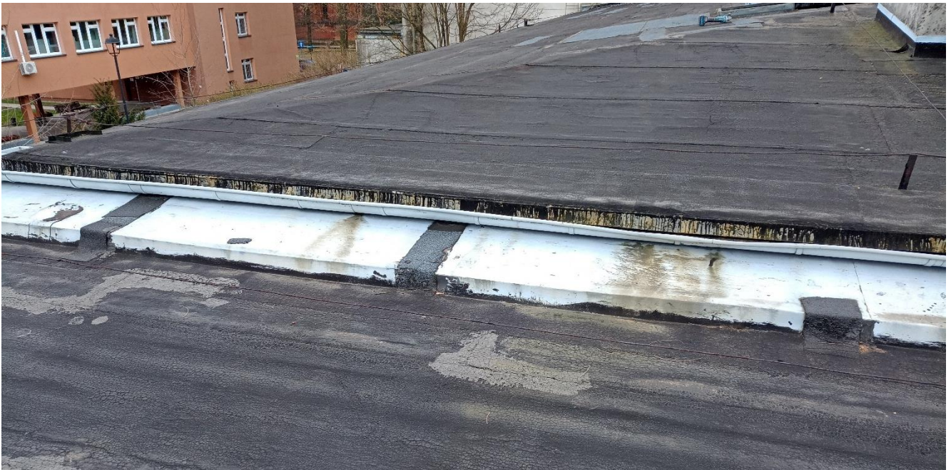
Fot. 38 Okap parterowej części budynku na styku z dobudową od strony zachodniej
