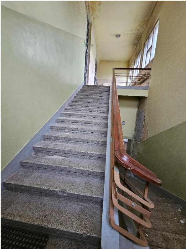
Fot. 21 Nawierzchnia z płytek lastriko na piętrze oraz lastriko na biegach schodowych istniejącej klatki schodowej
