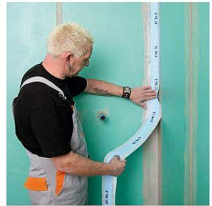
Wklejenie taśm PCI Pectape® Objekt na warstwie izolacji PCI Lastogum® szary.
