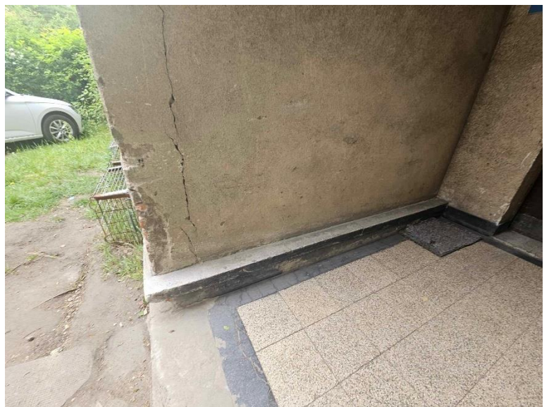
Fot. 19 Oryginalny cokół i wykończenie posadzi od strony elewacji południowej
