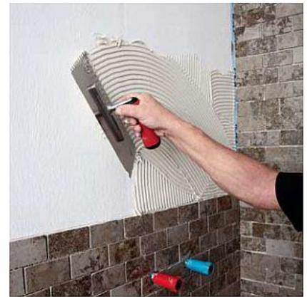
Wyklejenie okładziny płytkowej na odpowiedniej elastycznej zaprawie klejącej PCI.
