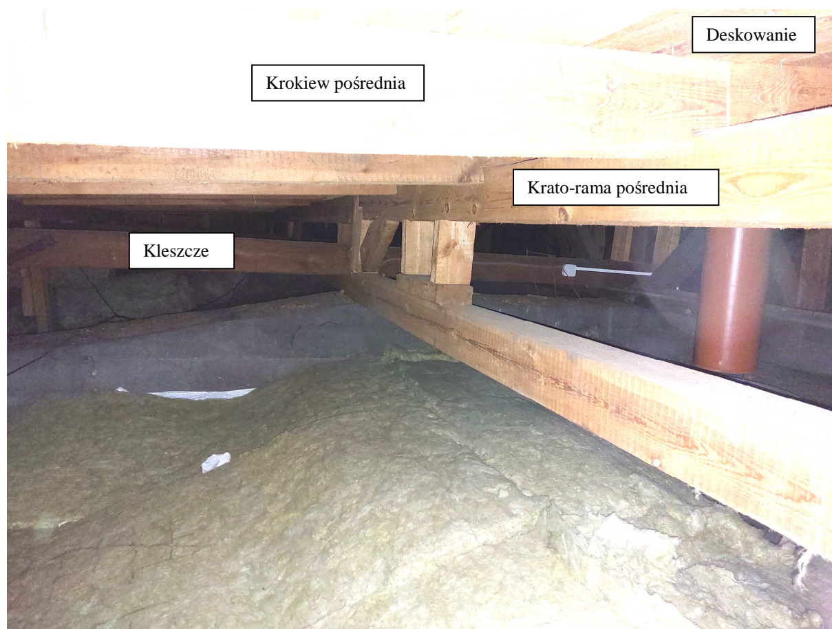
Rys. 4. Drewniana konstrukcja dachu nad „Salą na Piętrze”
