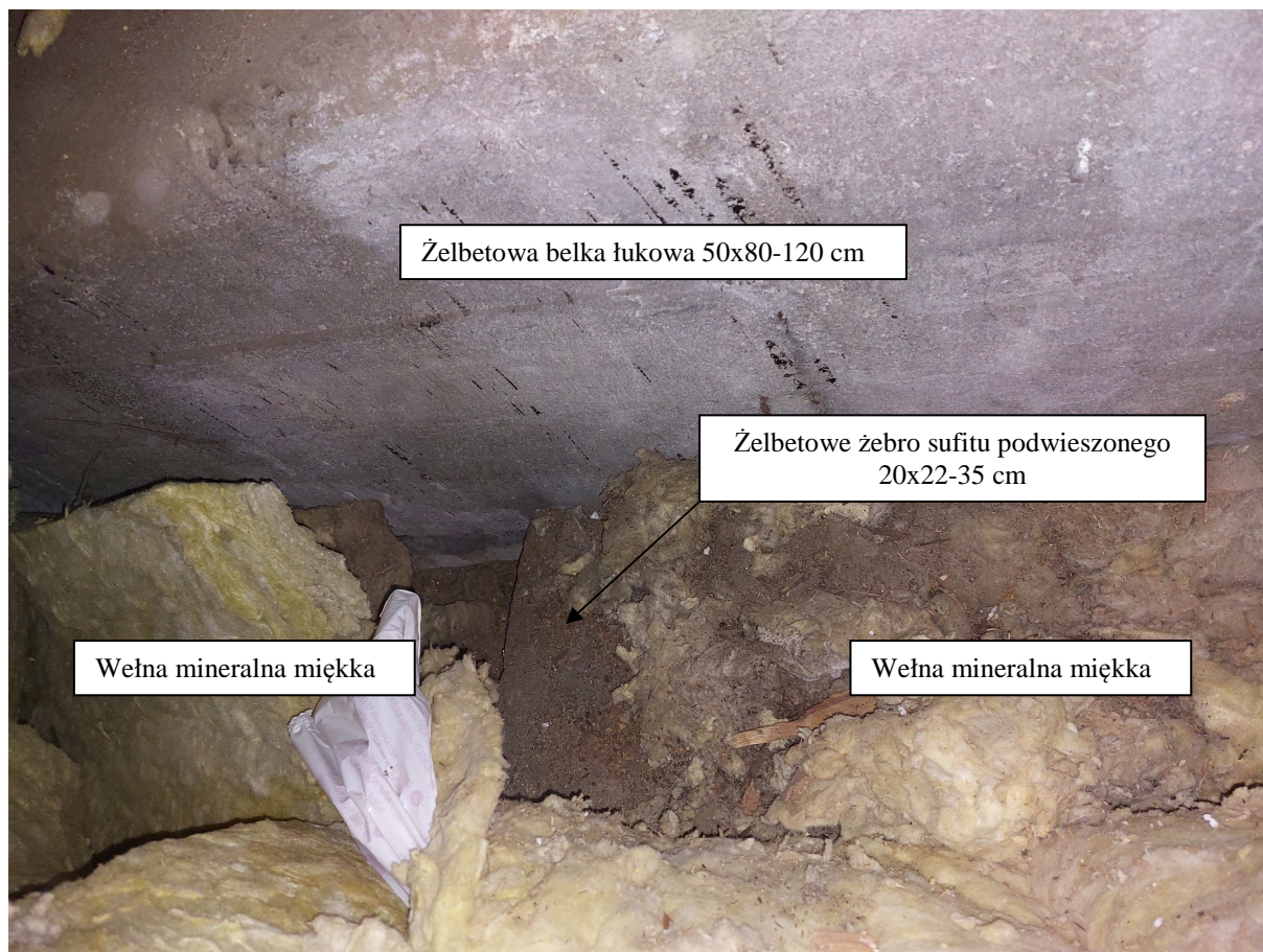
Rys. 10. Widok na strefę żelbetowej belki łukowej nad „Salą na Piętrze”
