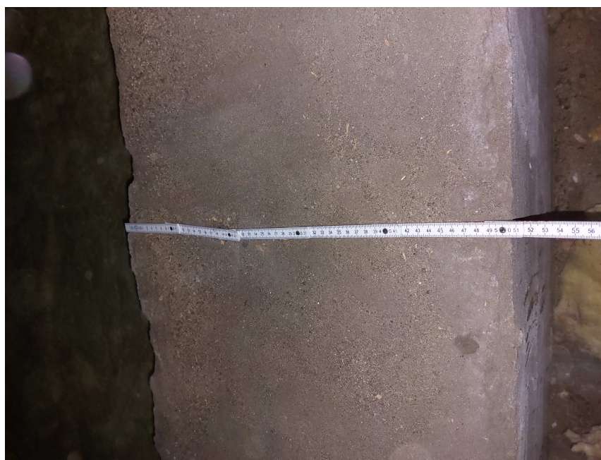
Rys. 11. Pomiar szerokości żelbetowej belki łukowej nad „Salą na Piętrze”
