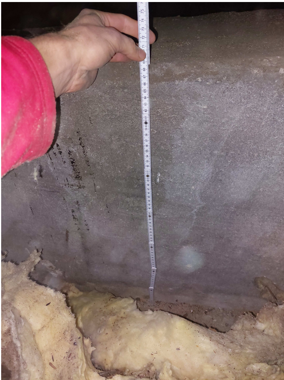
Rys. 12. Pomiar wysokości żelbetowej belki łukowej nad „Salą na Piętrze”
