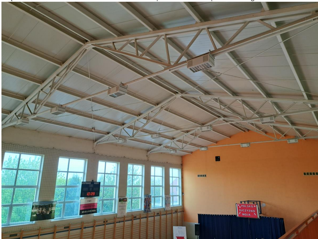
Zdjęcie nr 2 – Widok no rozmieszczenie i montaż opraw oświetlenia podstawowego
