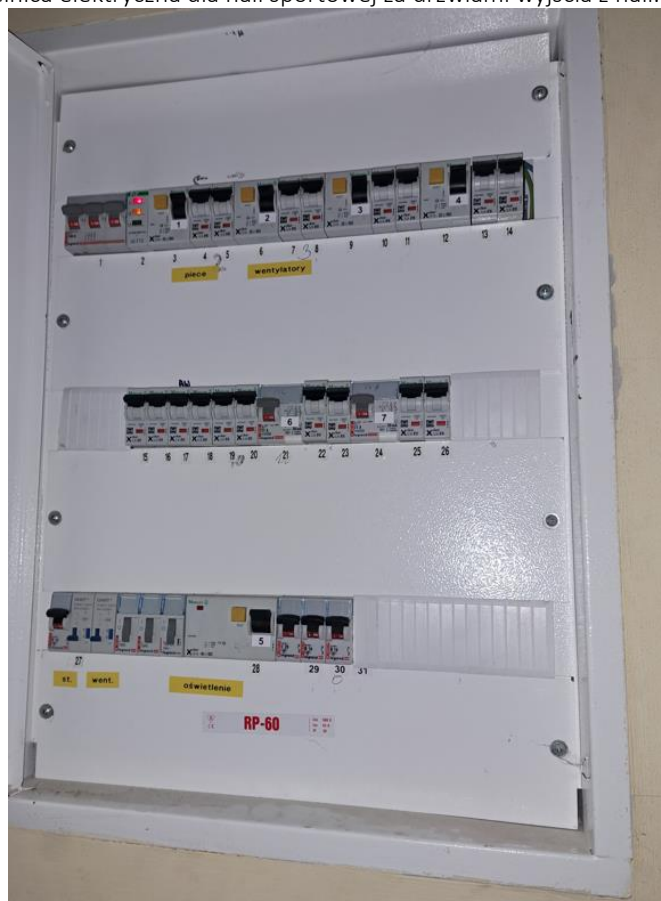
Zdjęcie nr 6 – Rozdzielnica elektryczna dla hali sportowej za drzwiami wyjścia z hali.
