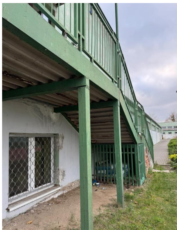
Konstrukcja stalowa schodów – do oczyszczenia i pomalowania
