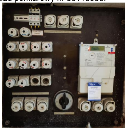
Rysunek nr 1 – Rozdzielnica Główna RG
