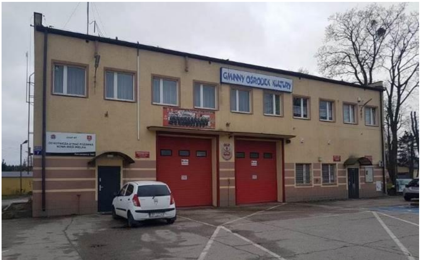
Rysunek 1. Budynek od strony północnej
