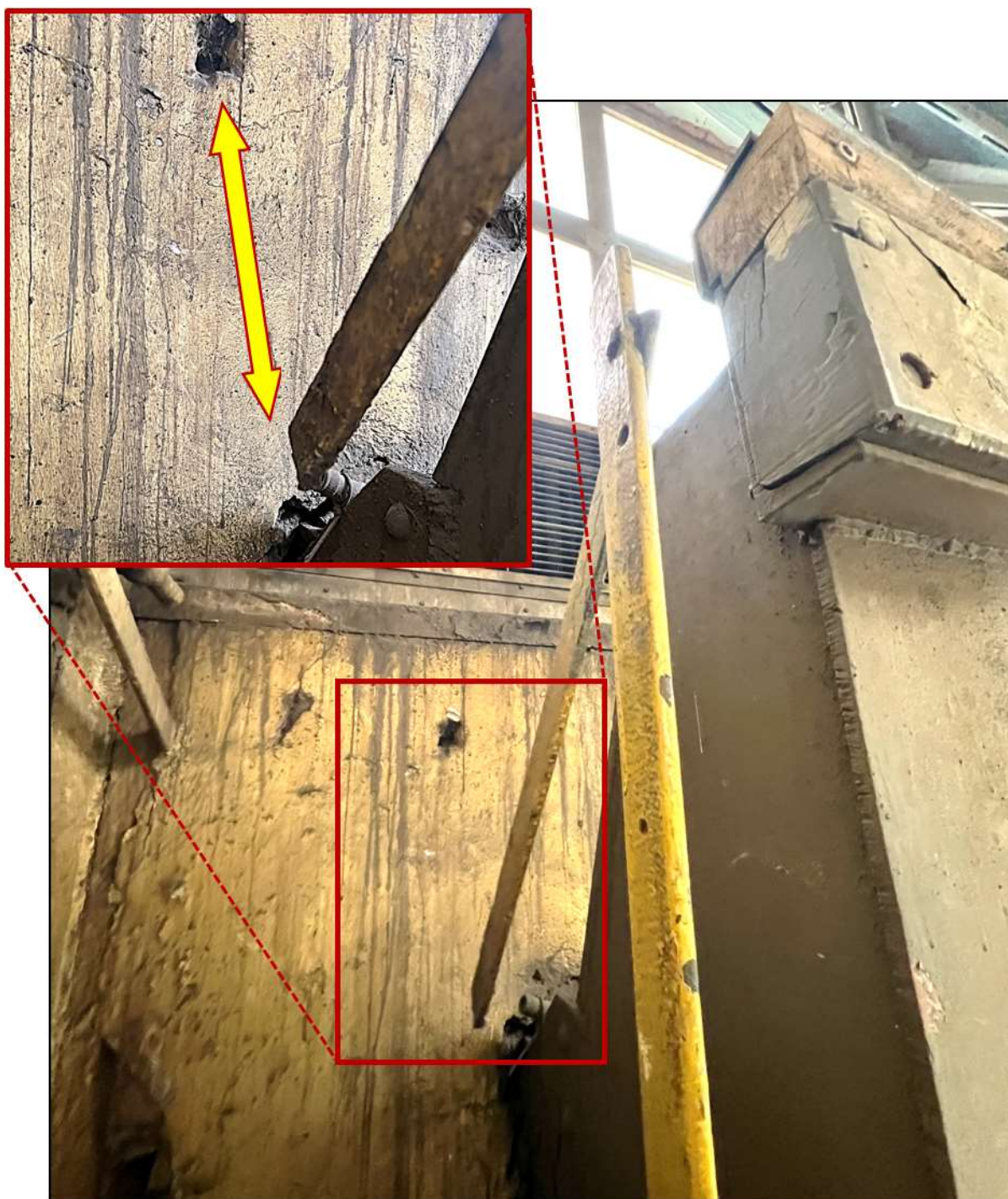
Fot. 3.4. Wskazanie nr 3/Podest nr 9- Utrata spójności górnego mocowania poręczy drabiny serwisowej do ściany przy wejściu na podest nr 9.
