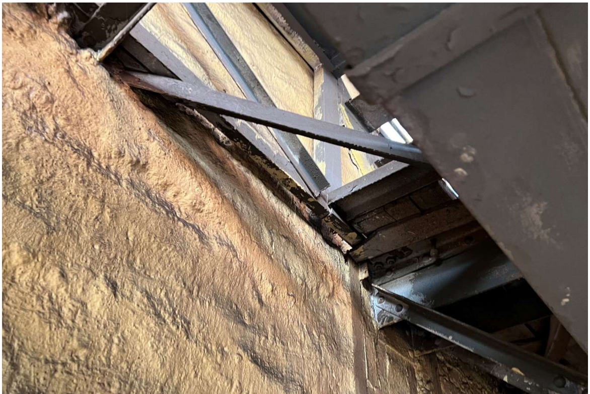
Fot. 3.16. Podest nr 9 – widok od dołu -mocowanie podestu do ściany.
