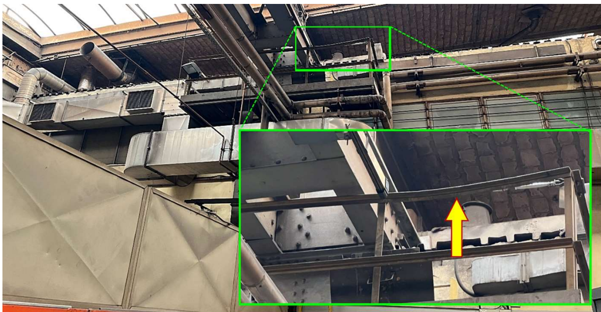
Fot. 3.2. Wskazanie nr 1/Podest nr 1- Deformacja poręczu balkonu podestu serwisowego bez utraty ciągłości spoin.
