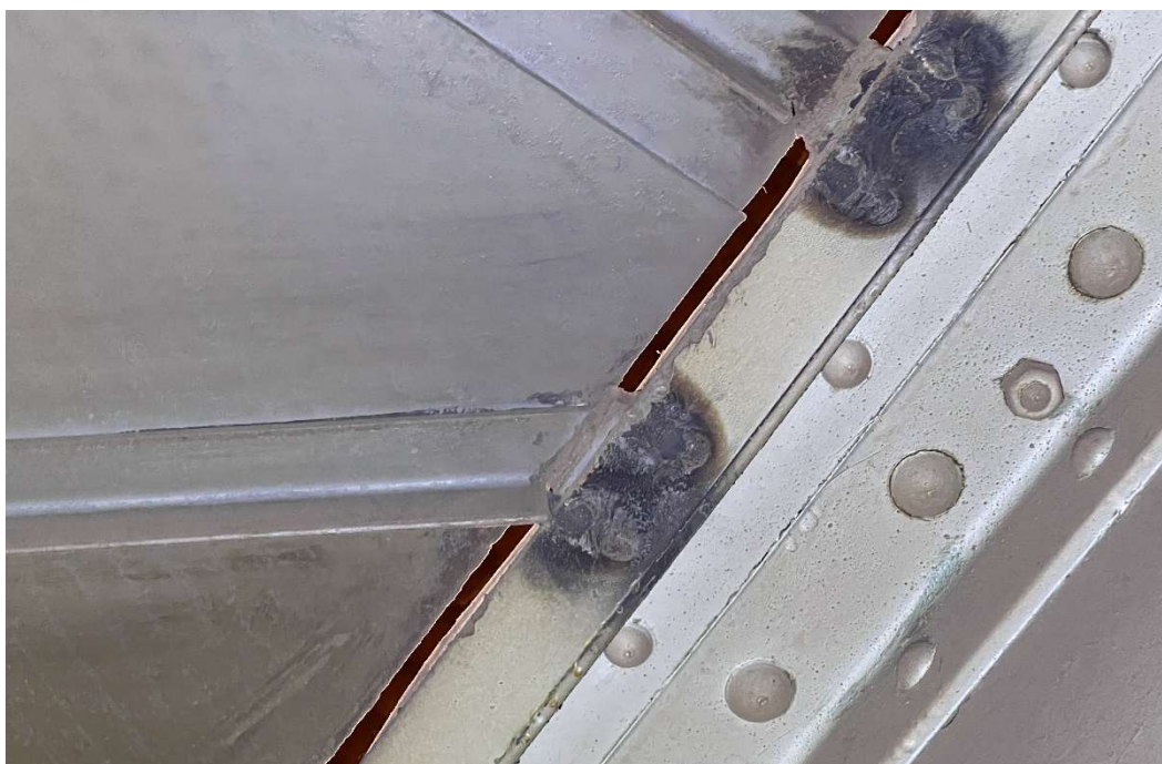
Fot. 3.12. Podest nr 7 – spoiny mocujące kątownik wsporcze podestu (blachy) do profilu głównego belki podsuwnicowej – zachowana ciągłość.
