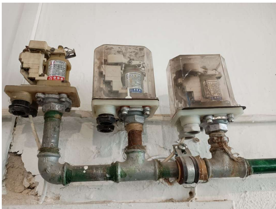
Rys.1 Istniejący układ sterowania ciśnieniem wody w instalacji wodociągowej.
