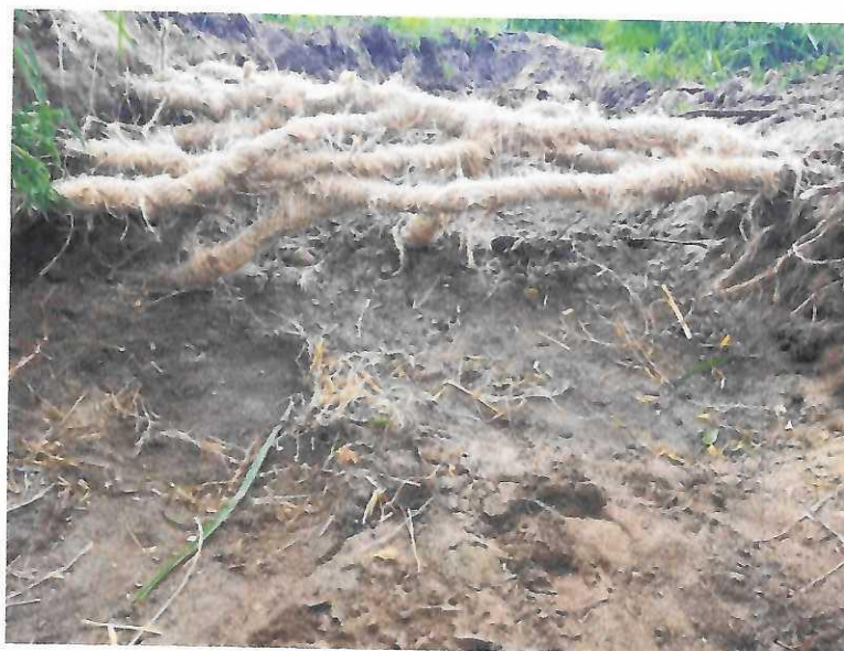
Ryc.13. Korzenie drzewa odsłonięte w wykopie, zabezpieczone przez prawidłowe „odłożenie” i owinięcie tkaniną jutową. Źródło: https://siedem-wierzb.pl/korzenie-drzew-podczas-prac-ziemnych-jak-chronic/
