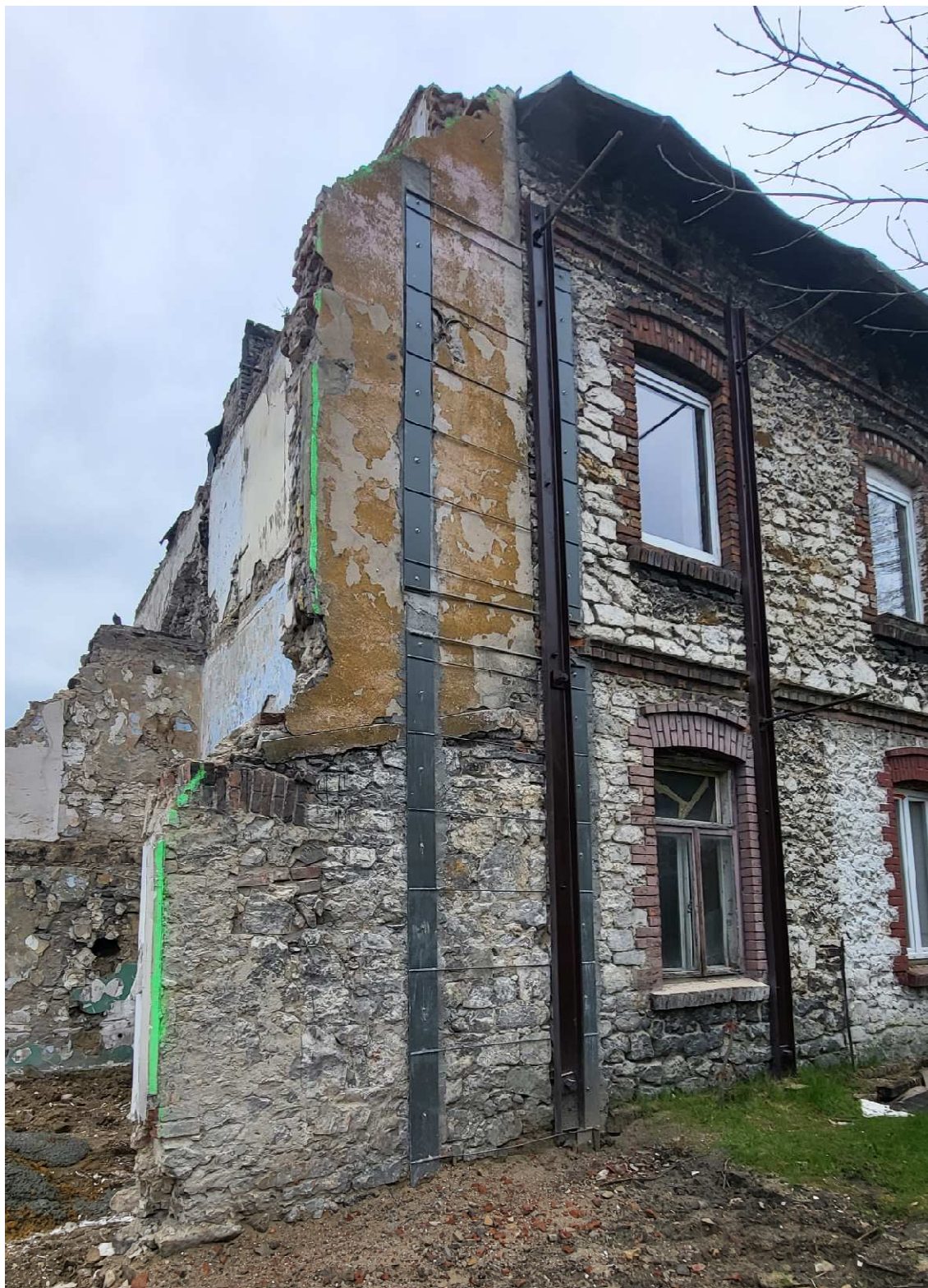
Zdj. 3 wzmocnienie ścianami wykonane na podstawie projektu technicznego, widok od podwórza wraz ze ścianami
