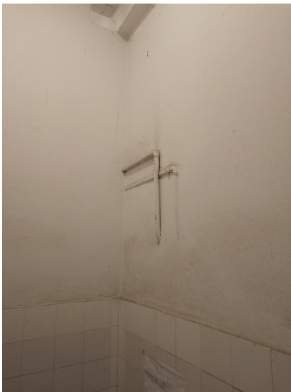
Fot. 34 – stara instalacja wody do demontażu lub ukrycia
