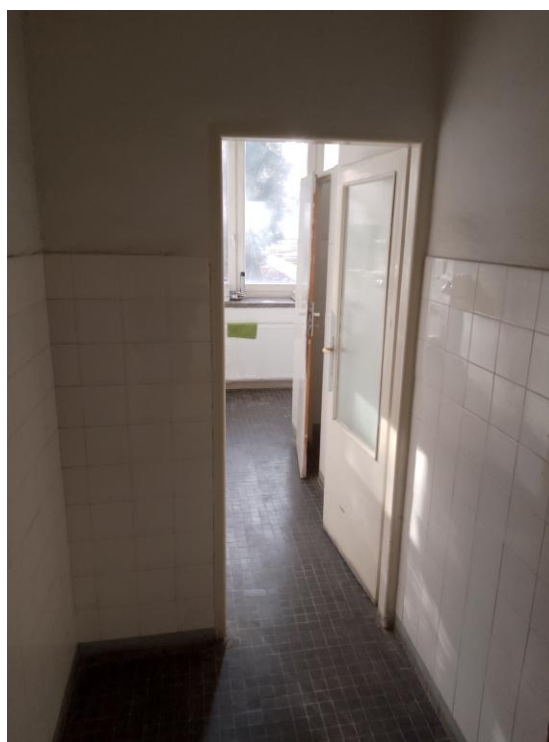
Fot. 29 – stare drzwi do demontażu oraz montaż nowych z podcięciami
