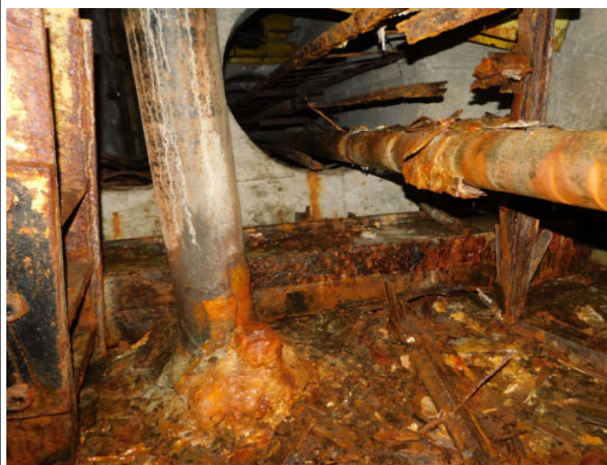
FOT. 10.3. WIDOK CIĘGIEN SKRZYNKI NR 9 DW NAD FILAREM OD STRONY RONDA GRUNWALDZKIEGO
