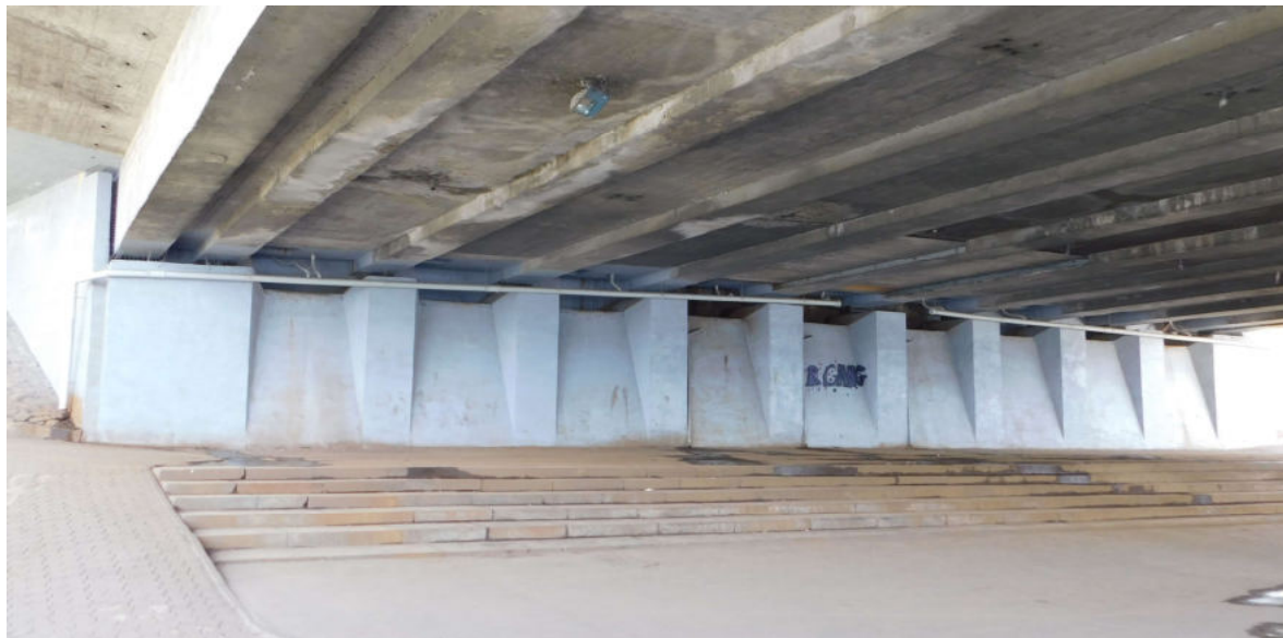
FOT. 9.1. WIDOK PŁYTY - SKRZYNKI NR 1 GW
