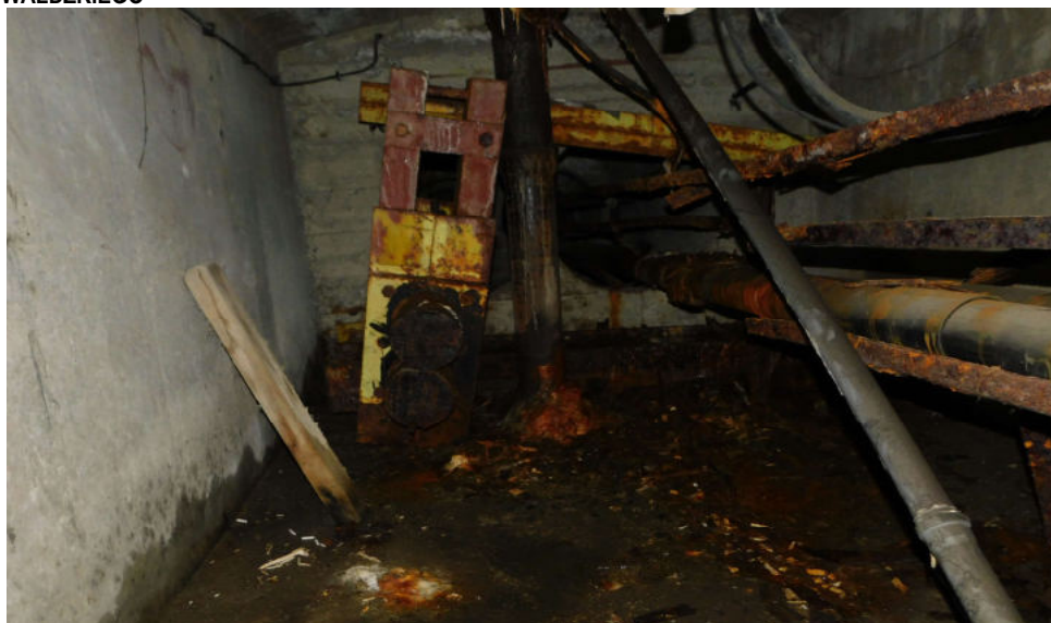
FOT. 10.1. WIDOK RAMY BLOKU ZAKOTWIENIA CIĘGIEN SPRĘŻAJĄCYCH SKRZYNKI NR 1 GW NAD FILAREM OD STRONY RONDA GRUNWALDZKIEGO
