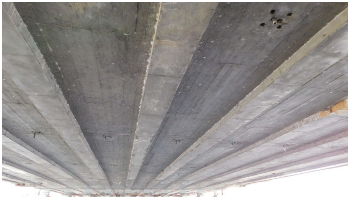
FOT. 3.3. WIDOK PRZĘŚLA NR 1 OD STRONY ZACHODNIEJ
