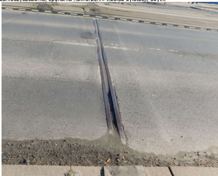
FOT. 2.2. WIDOK DYLATACJI PODPORY NR 2 - PRZYCZÓŁKA OD STRONY WSCHODNIEJ
