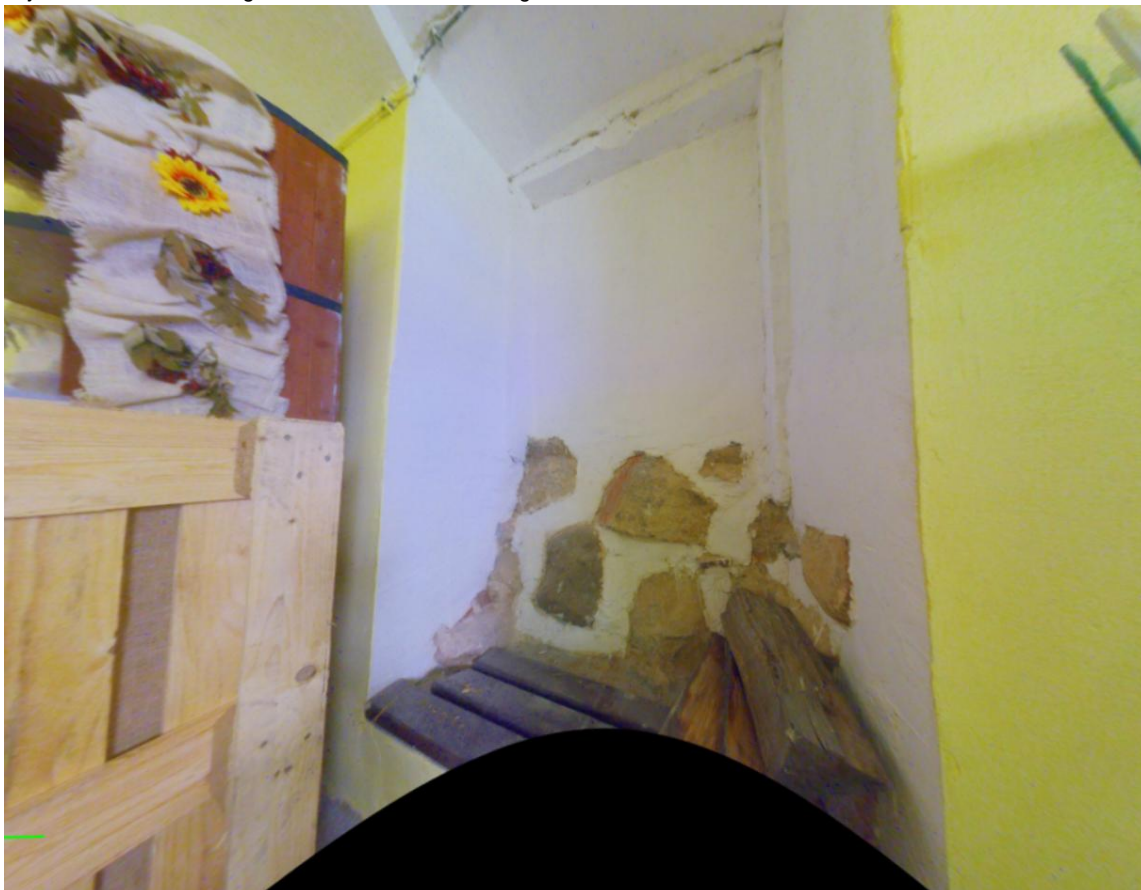
Zdj. Nr 16. Piwnica – fragment fundamentu kamiennego
