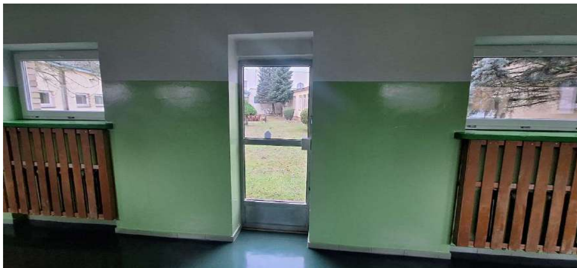
Zdj. 1 Istniejący otwór drzwiowy projektowany do powiększenia
