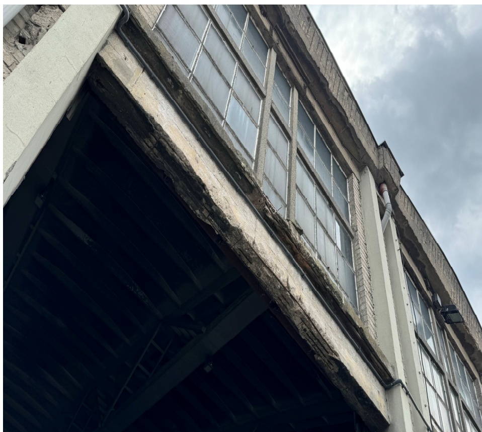
Fot. nr 8. Widoczne mechaniczne uszkodzenie i korozja w nadprożu istniejącym bramy do przebudowy w magazynie 12
