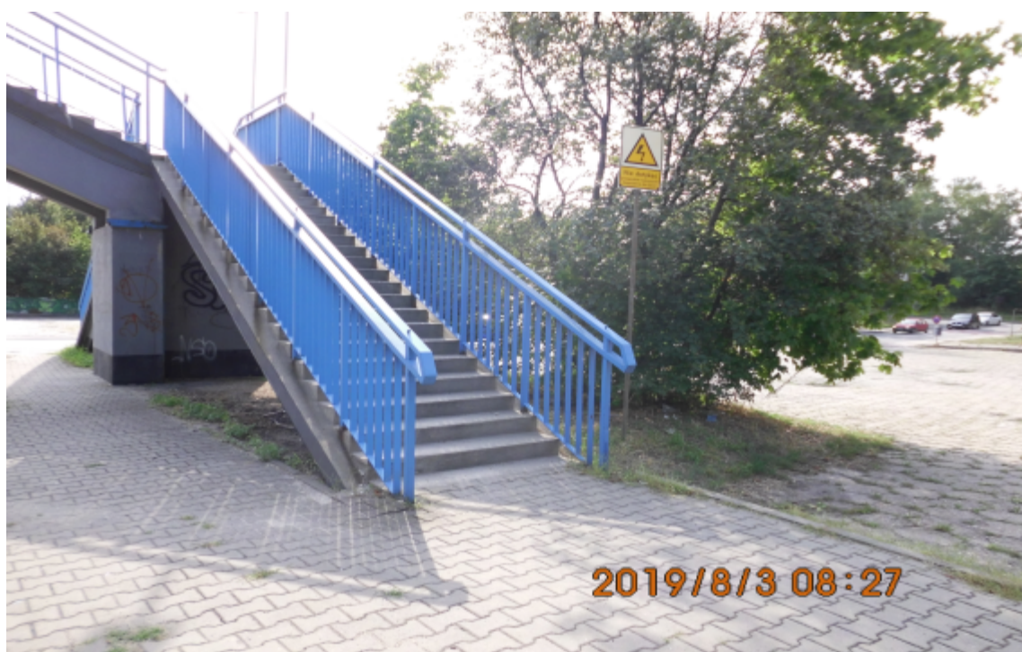
Zdjęcie nr 3.3: Wejście na kładkę od strony południowej
