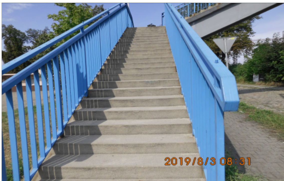
Zdjęcie nr 3.4 : Bieg schodowy na kładkę od strony północnej
