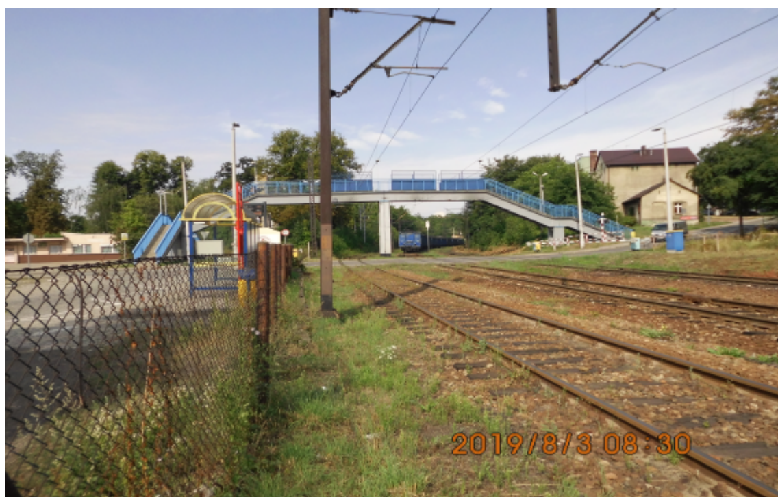
Zdjęcie nr 3.2 : Widok ogólny kładki od strony wschodniej
