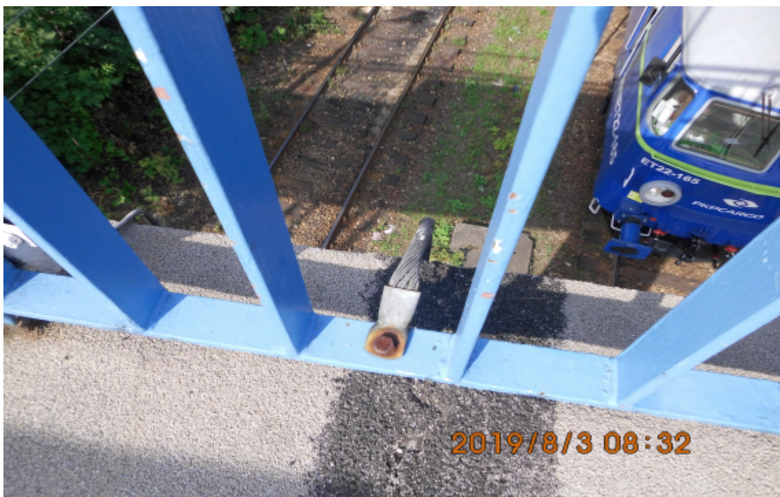
Zdjęcie 3.12 : uziemienie balustrady
