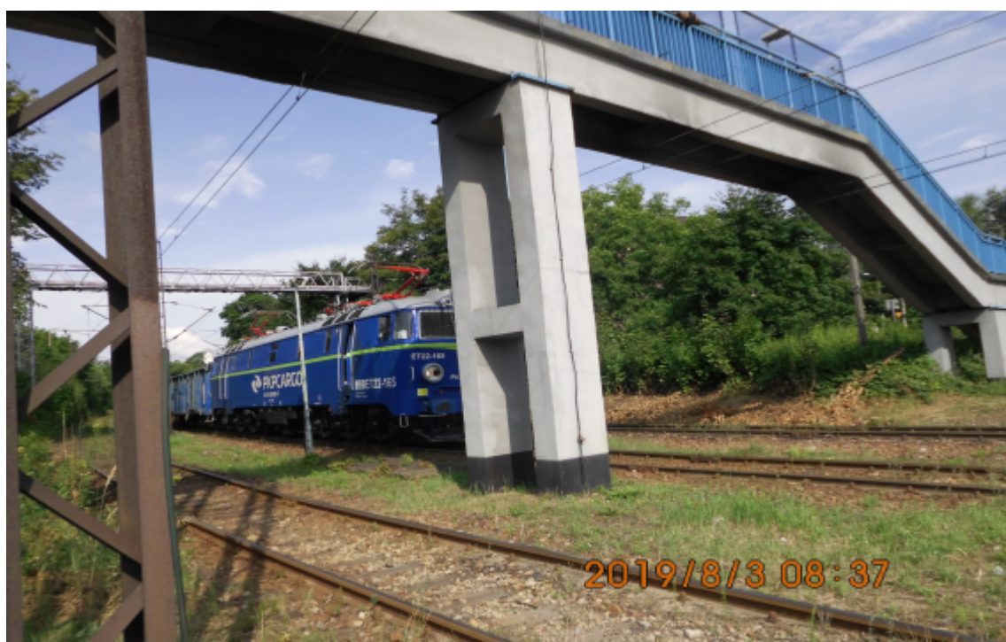
Zdjęcie nr 3.7 : Filar dwudzielny środkowy wraz z uziemieniem konstrukcji kładki.
