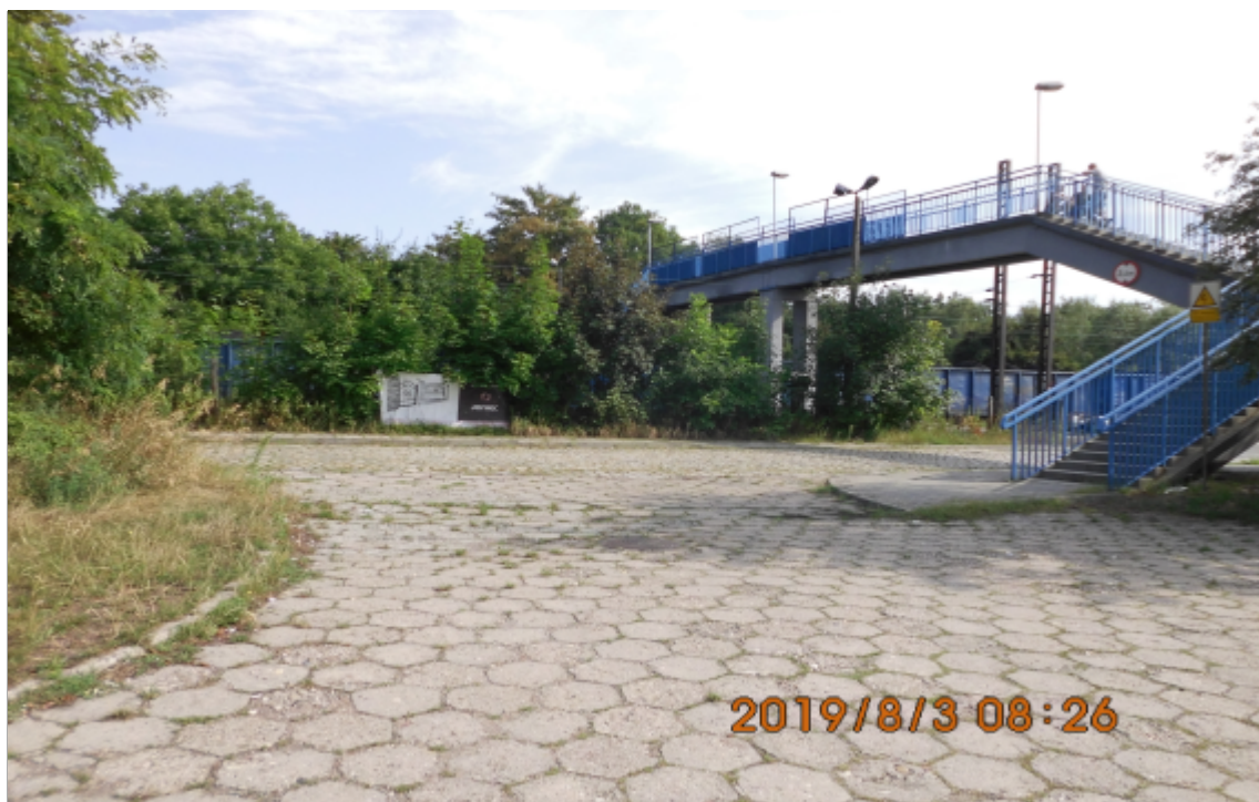
Zdjęcie nr 3.1 Widok ogólny kładki od strony zachodniej
