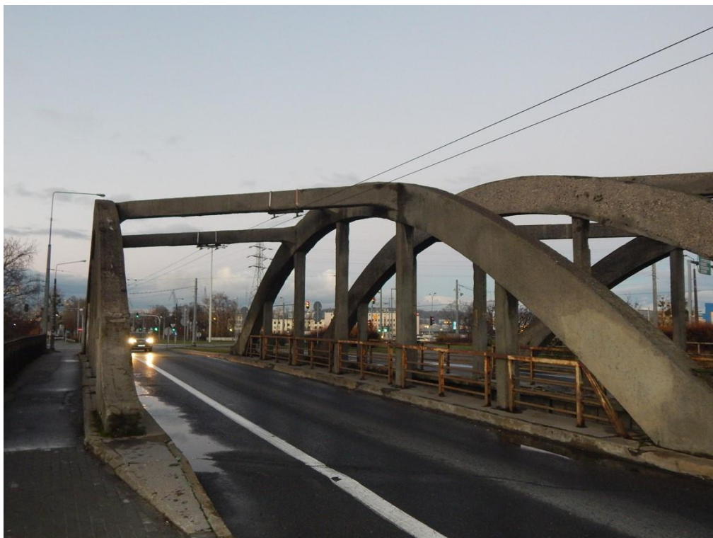
Fot. 1. Widok na obiekt od strony peronu PKP
