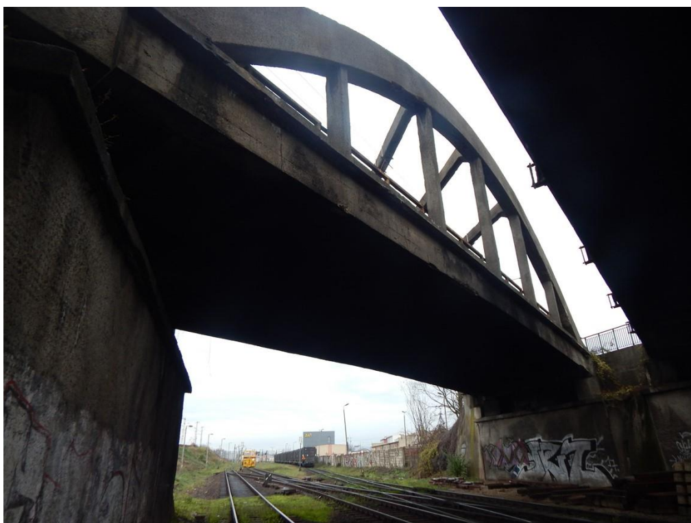
Fot. 2. Widok z boku na obiekt inżynierski
