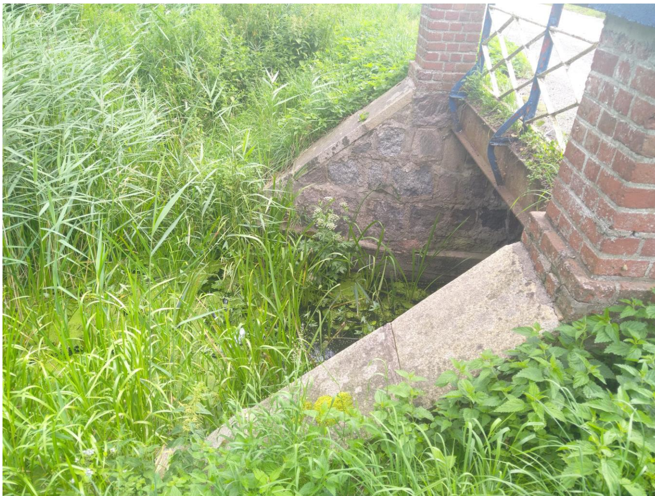
Fot.2 Widok na istniejący most w ciągu drogi powiatowej nr 1307N od strony północno-zachodniej.
