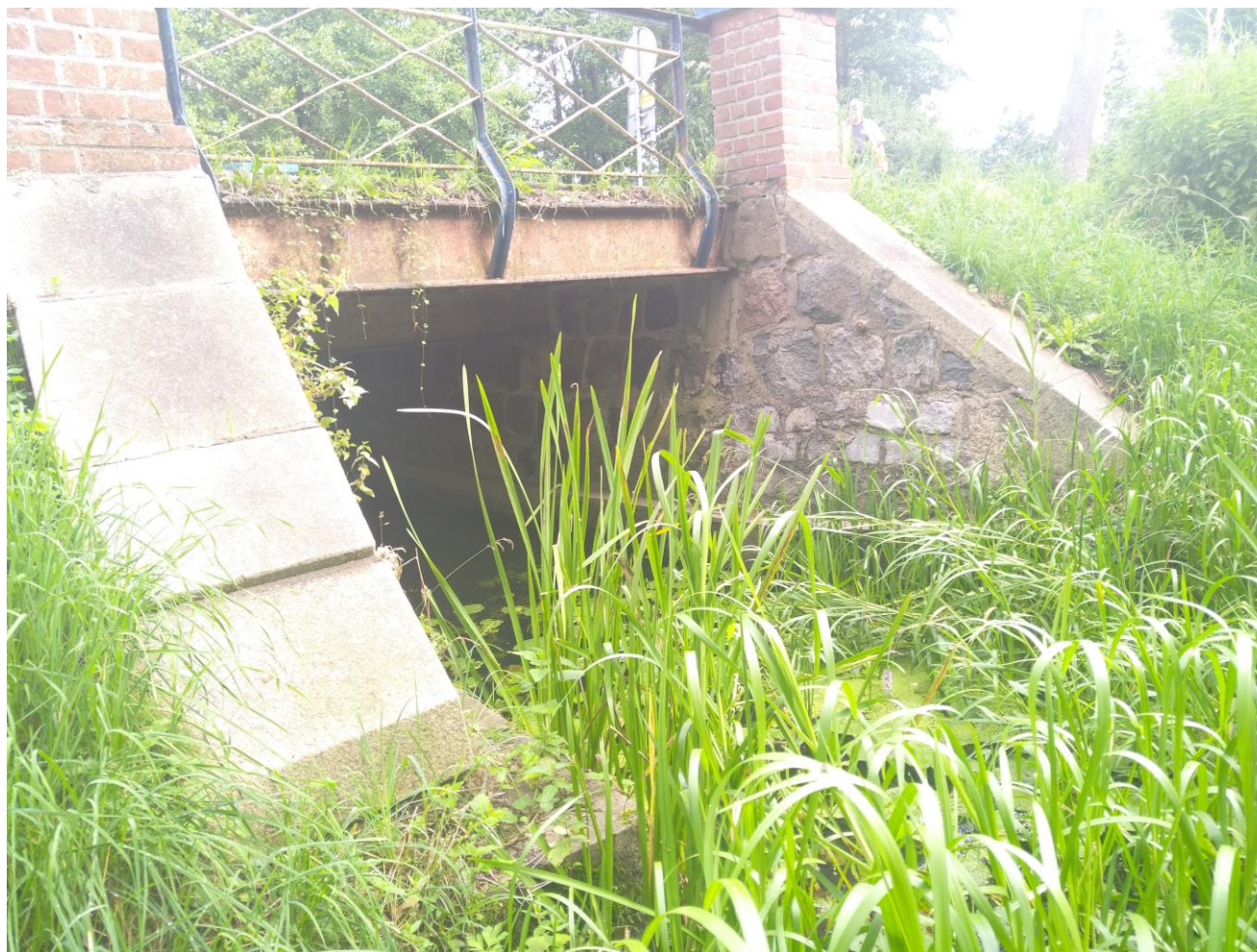
Fot.1 Widok na istniejący most w ciągu drogi powiatowej nr 1307N od strony południowo-wschodniej.
