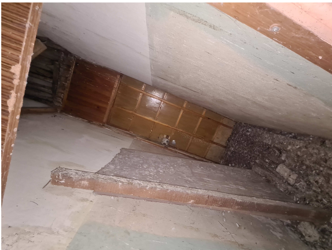
ZDJ. NR. 9 LOKAL MIESZKALNY nr. 13 – drzwi na strych do likwidacji i zamurowania
