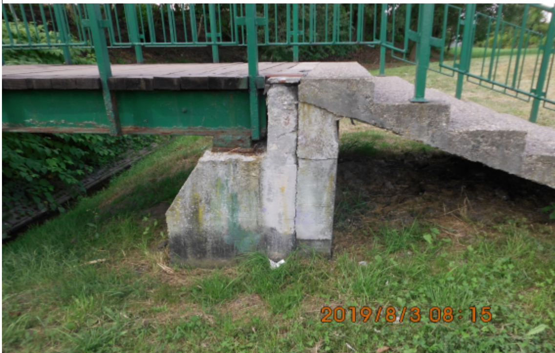
Zdjęcie nr 3.7 : Przyczółek od strony północnej
