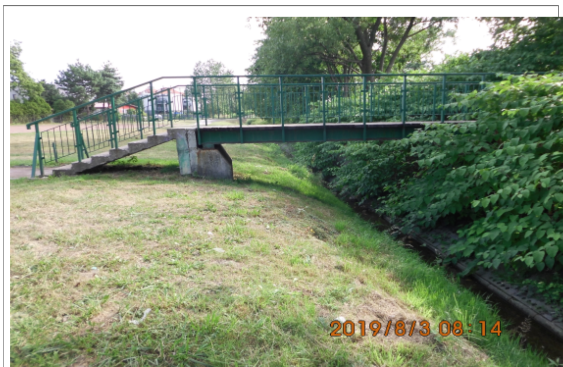
Zdjęcie nr 3.2 : Widok ogólny kładki od strony zachodniej
