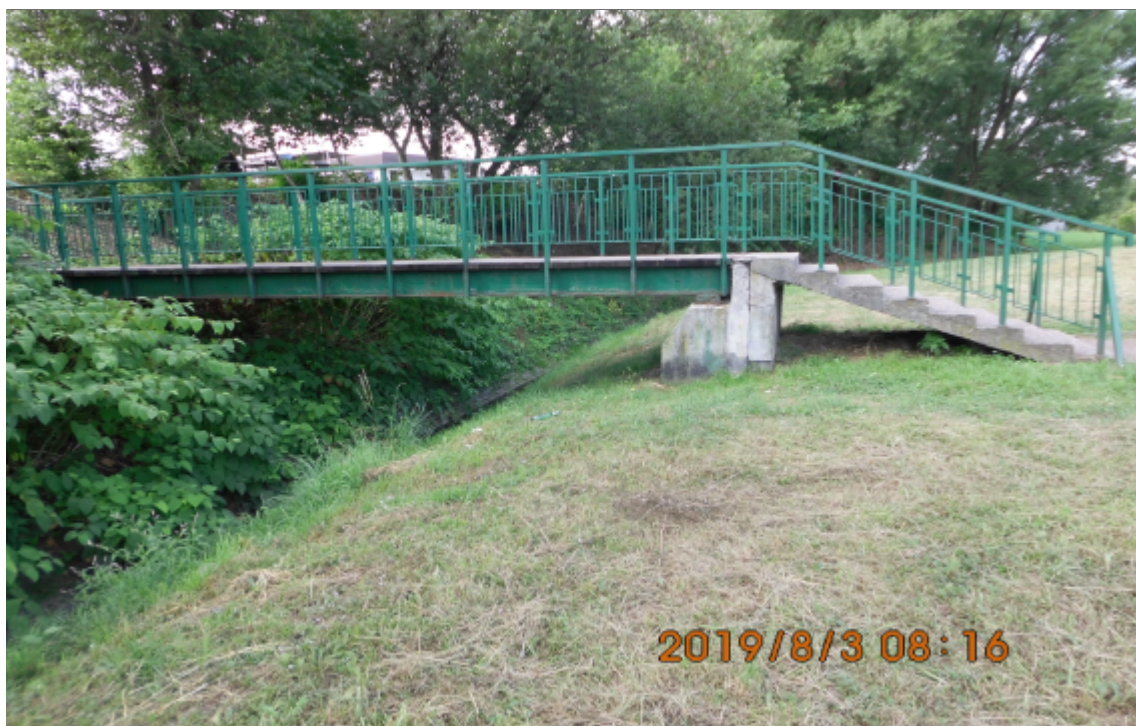
Zdjęcie nr 3.1 Widok ogólny kładki od strony wschodniej
