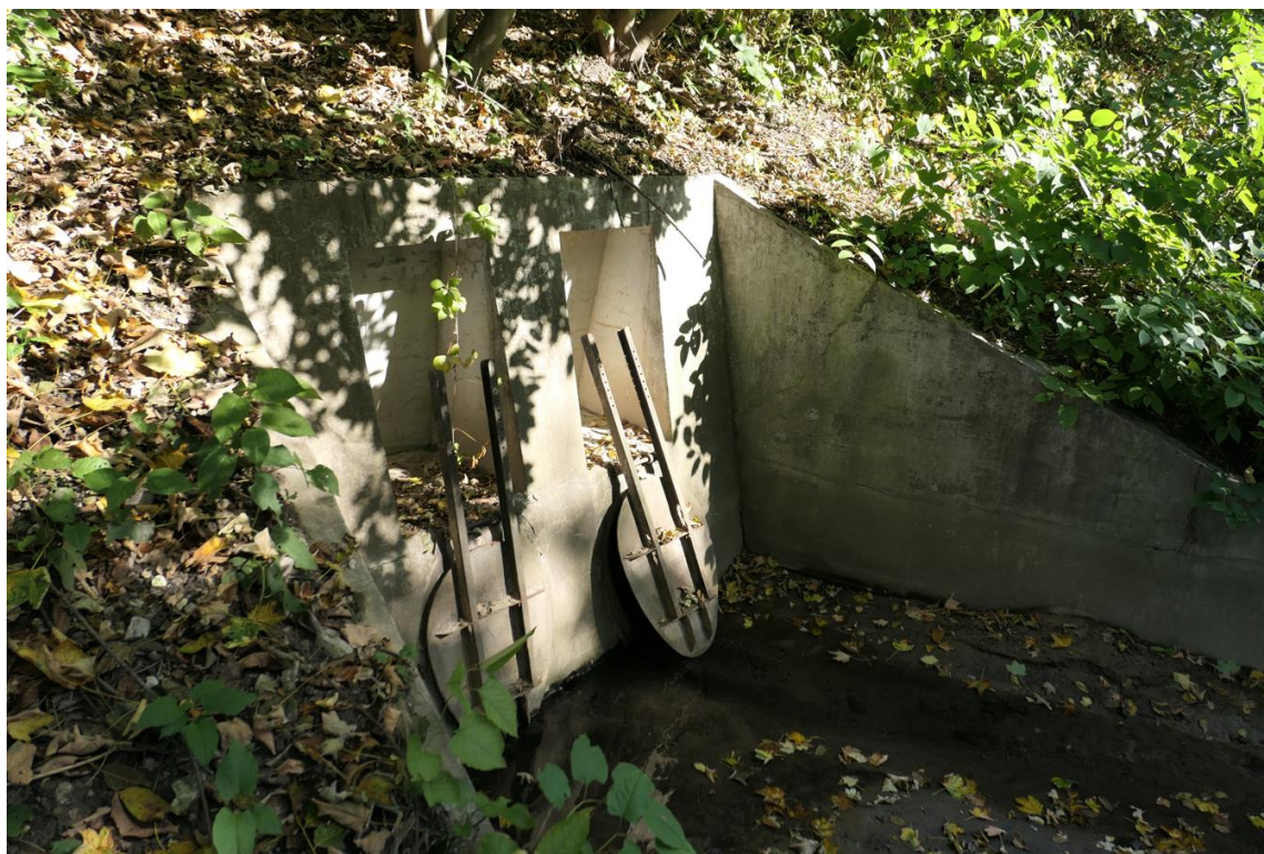
Fot. 16 Ujście kanalizacji deszczowej kdA1500/1000 do rz. Prądnik
