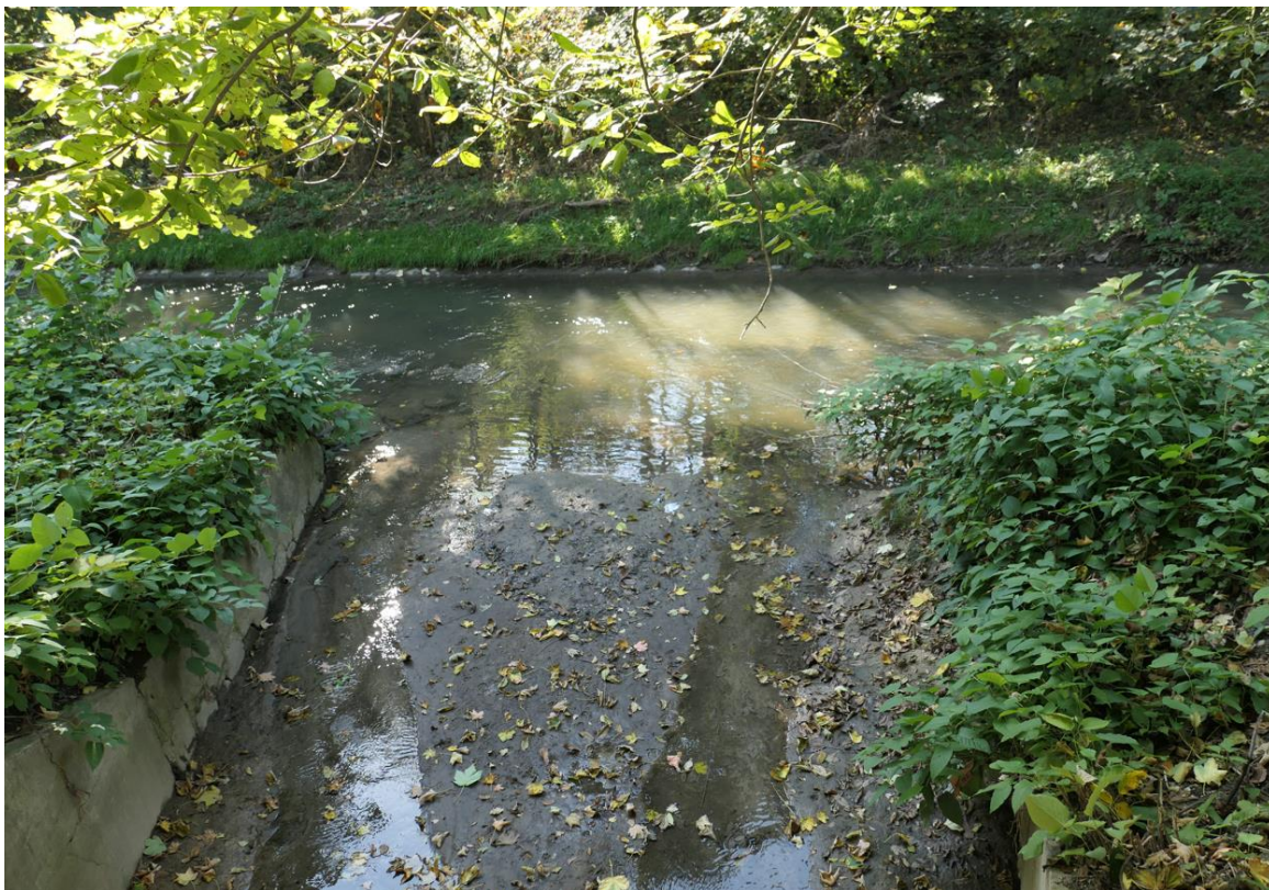
Fot. 15 Ujście kanalizacji deszczowej kdA1500/1000 do rz. Prądnik
